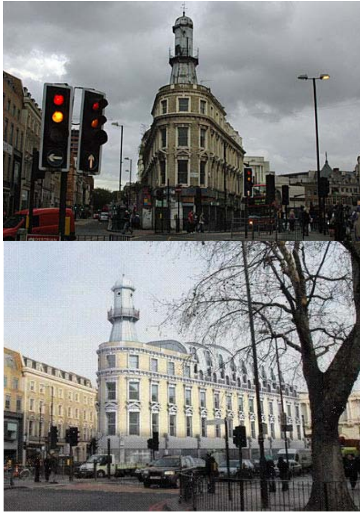
Şekil 3.46 Lighthouse binası (Regent Quarter projesi, A blok), 2009 yılındaki (üst resim) durumu ve hedeflenen görüntüsü, (www.urban75.org , www.propertyweek.com).
