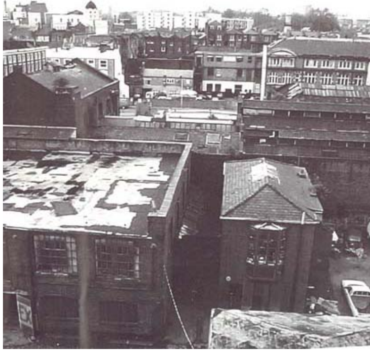
Şekil 3.48 Regent Quarter , C blok binaları, (Vogdopoulou, 2006).
