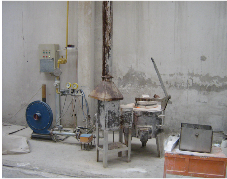
Şekil 2.1 Ergitme işlemlerinin yapıldığı doğalgazla çalışan frit fırını
