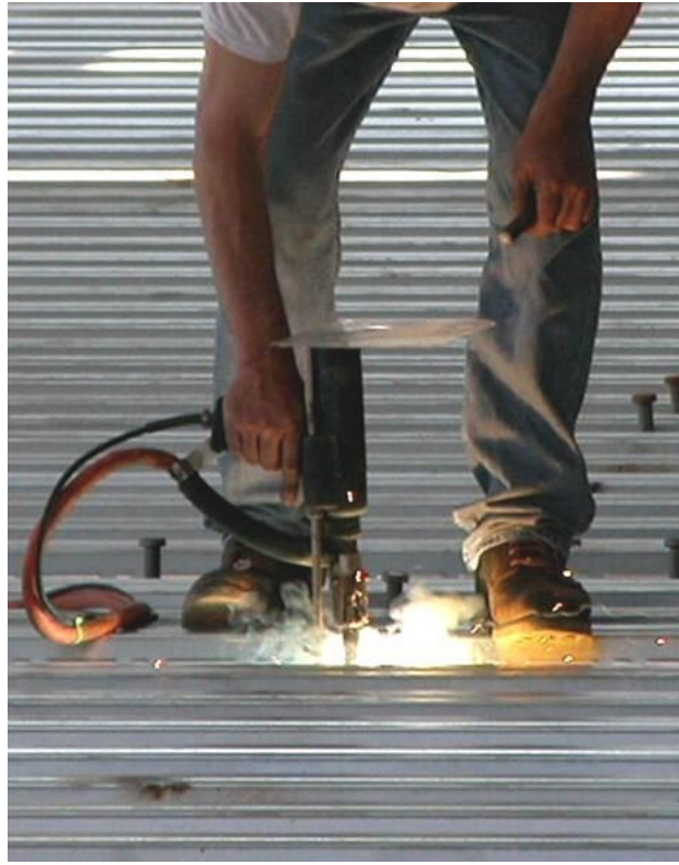
Şekil 2.9 Başlıklı kayma bağlantılarının uygulamada kaynaklanması
