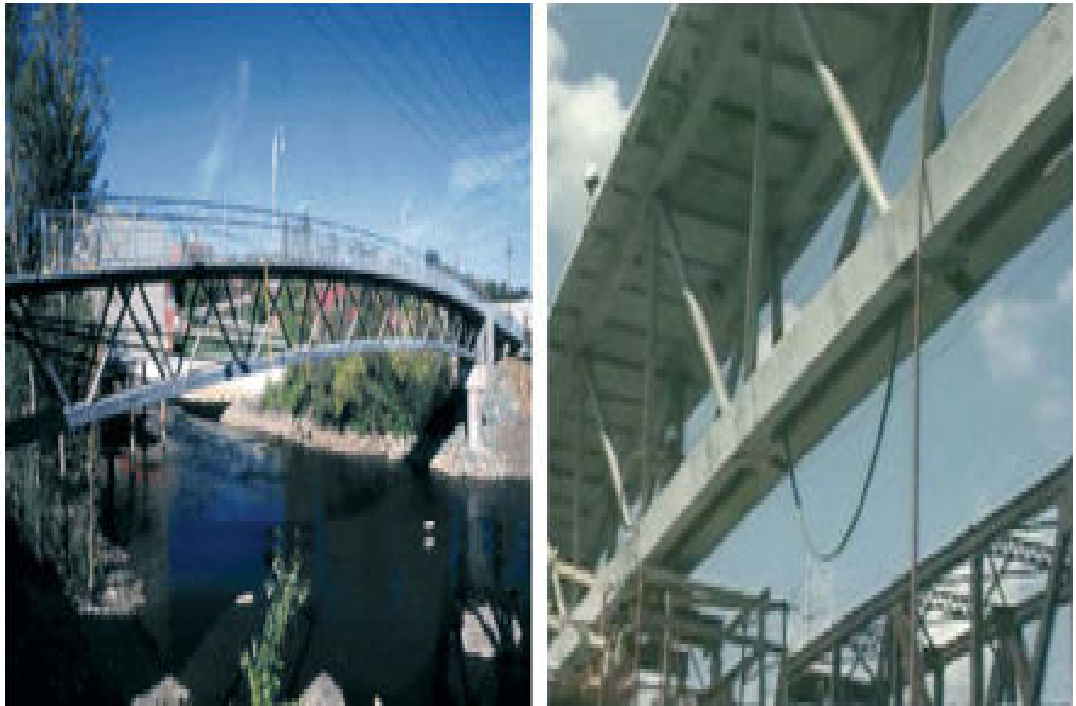
Şekil 3.1 Reaktif pudra betonu ile yapılmış Sherbrooke köprüsü
