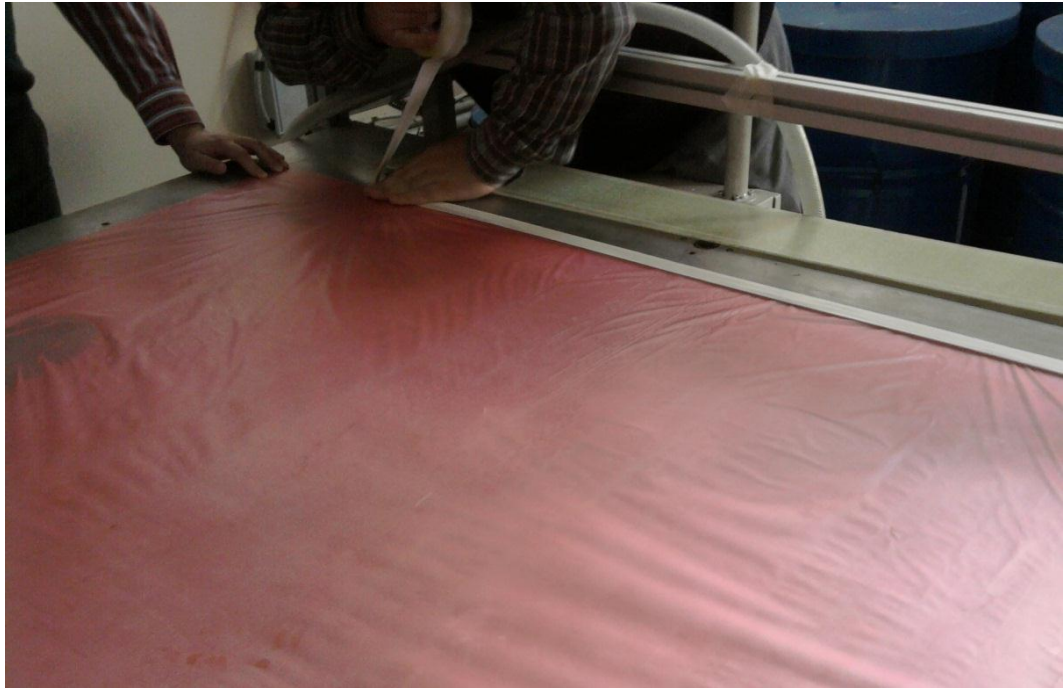
Şekil 3.6 Kalıp ayırıcı filmin etrafına sızdırmazlık macunu çekilmesi
