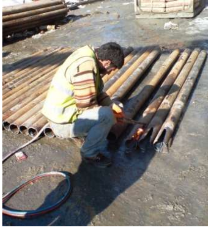
Şekil 2.11 Çelik boruların ucunun daraltılması işlemi
