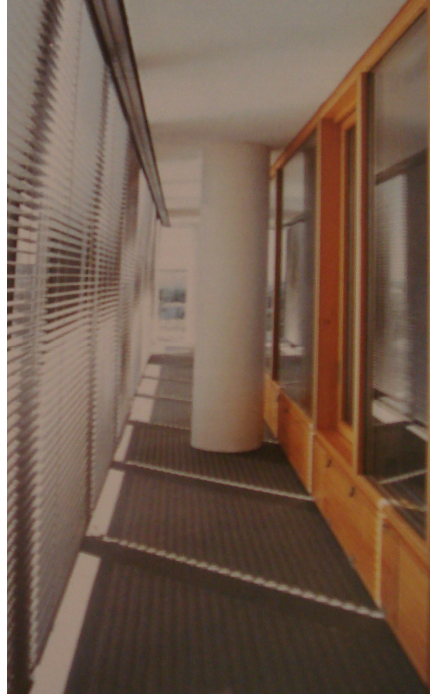
Şekil 4.6 Deutsche Messe AG binası, çift tabakalı giydirme cephe arası boşluk (Schittich, 2001, s.172).
