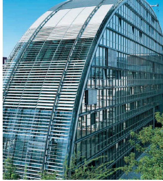
Şekil 3.8 Hareketli güneş kırıcılara örnek cephe (Schüco sistem kataloğu).
