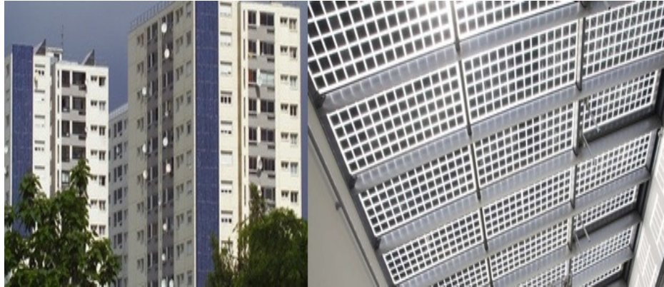
Şekil 3.15 Bina cephesine entegre edilmiş fotovoltaiik sistem örneđi, Lyon (Fransa) ( http://www.sapasolar.com/turkey/sapa-solar/index.html ).
