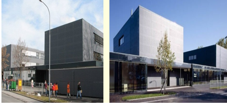
Şekil 2.16 Okul binası cephesi, Lauterach (Almanya) ( http://www.baudata.com/referenzobjekte#4a362e2a-cc12-4f4c-8246-1ec30f9edab6 ).
