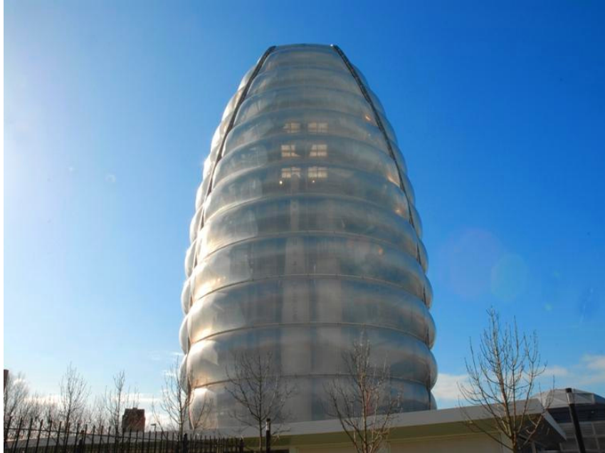
Şekil 4.13 Ulusal Uzay Merkezi, ETFE membran kaplı yüzeyi ( http://www.desso.com/BC_Delighted_customers_National_Space_Centre_EN.html ).
