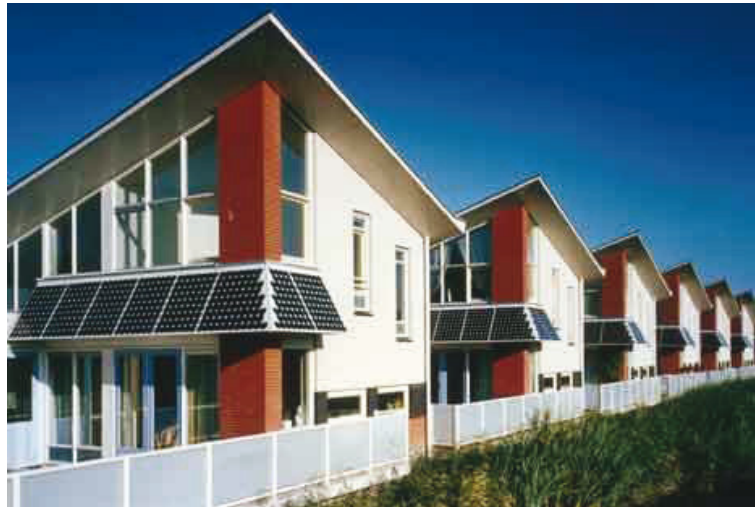
Şekil 3.14 Gölgeleme elemanı olan fotovoltaik modüller, Dortrecht (Hollanda) (Koç, 2010, s.716)
