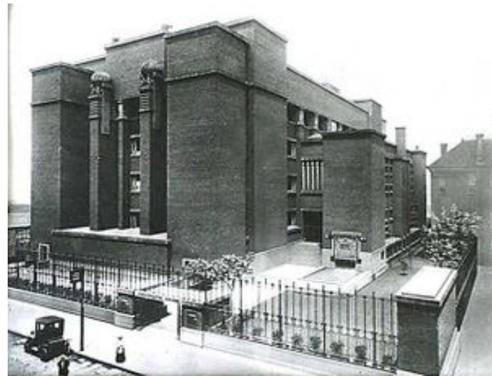
Şekil 2.28 Larkin Şirketi Yönetim Binası, New York (ABD) ( http://www.buffalohistoryworks.com/photograph/others/pic49.htm ).
