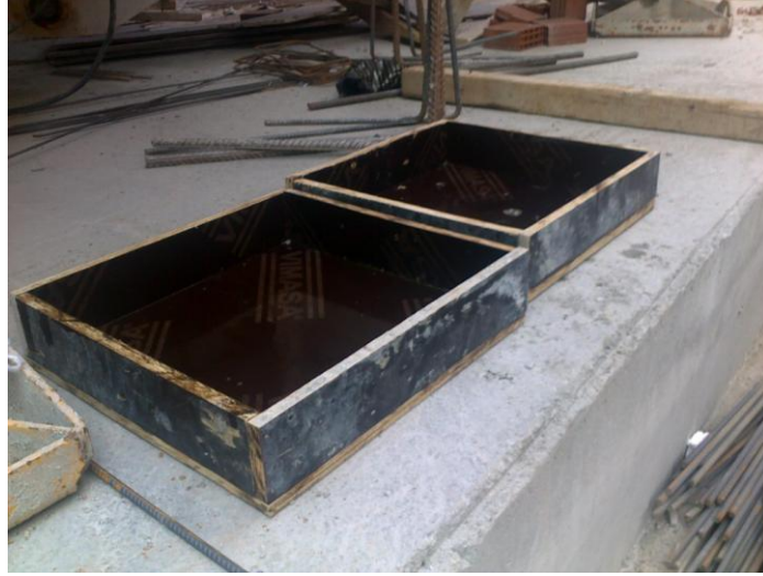
Şekil 5.20 Beton numuneler için ahşap kalıp
