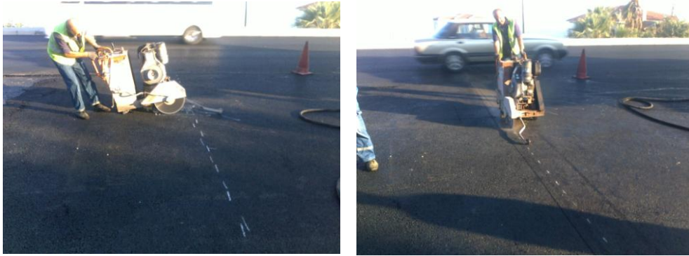
Şekil 5.6 Taş mastik asfalt numunesinin sıkıştırma aşamasından sonra alınması.
