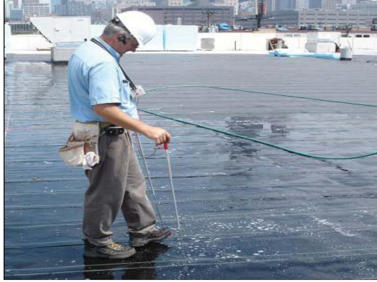
Şekil 3.34 American Hydrotech firması kaçak testi uygulaması (Tolderlund, 2010)
