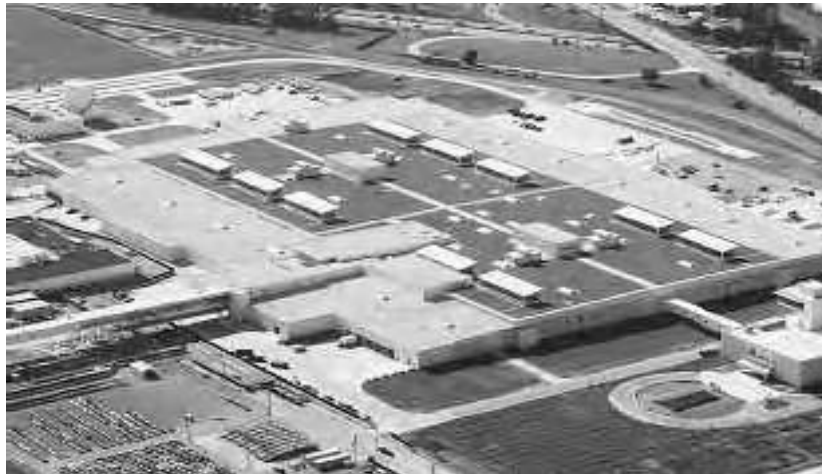
Şekil 2.10 Ford Motor Company River Rouge Plant Yeşil çatısı. (Yudelson, 2007)
