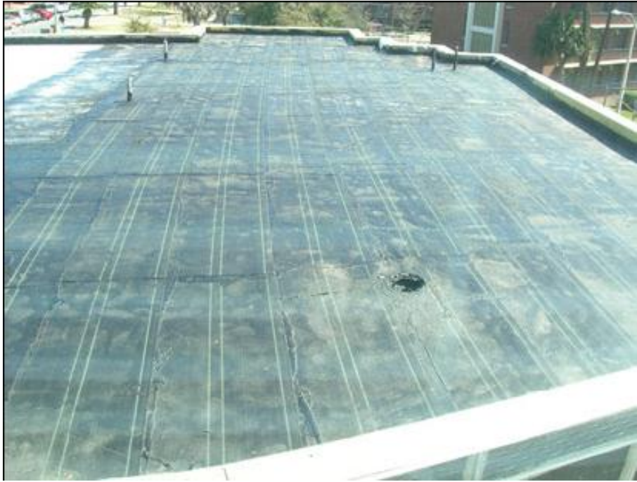
Şekil 3.5 Su yalıtım tabakası (Stater, b.t.)
