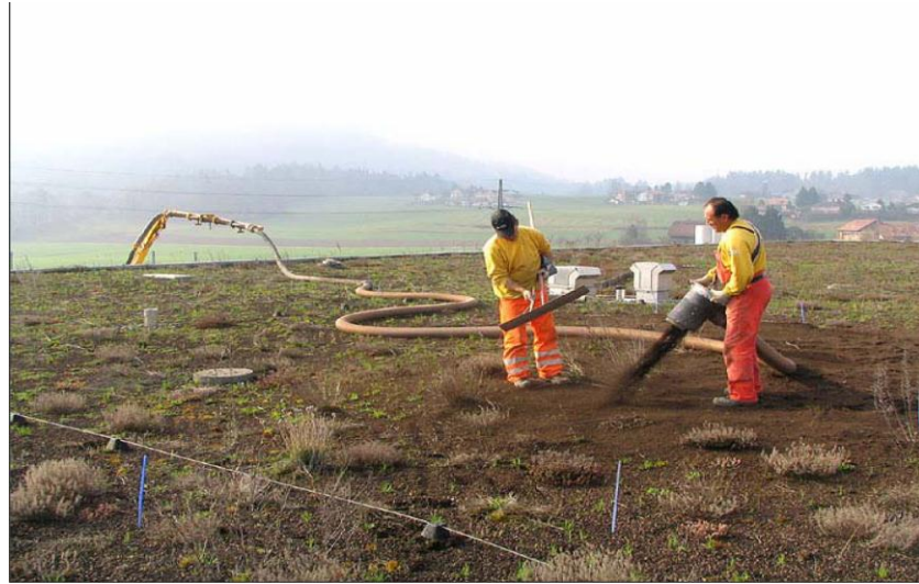
Şekil 3.10 Proje çalışanları mevcut çatıya substrat eklerken (Dunne ve diğer., 2006, s.45)
