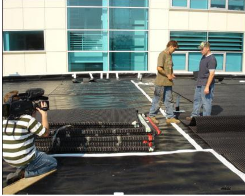
Şekil 3.8 Kök tutucu tabaka ve direnç tabakası (Stater, bt.)
