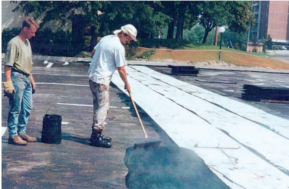
Şekil 3.6 Sıcak uygulanan likid membran (Henshell, 2005)
