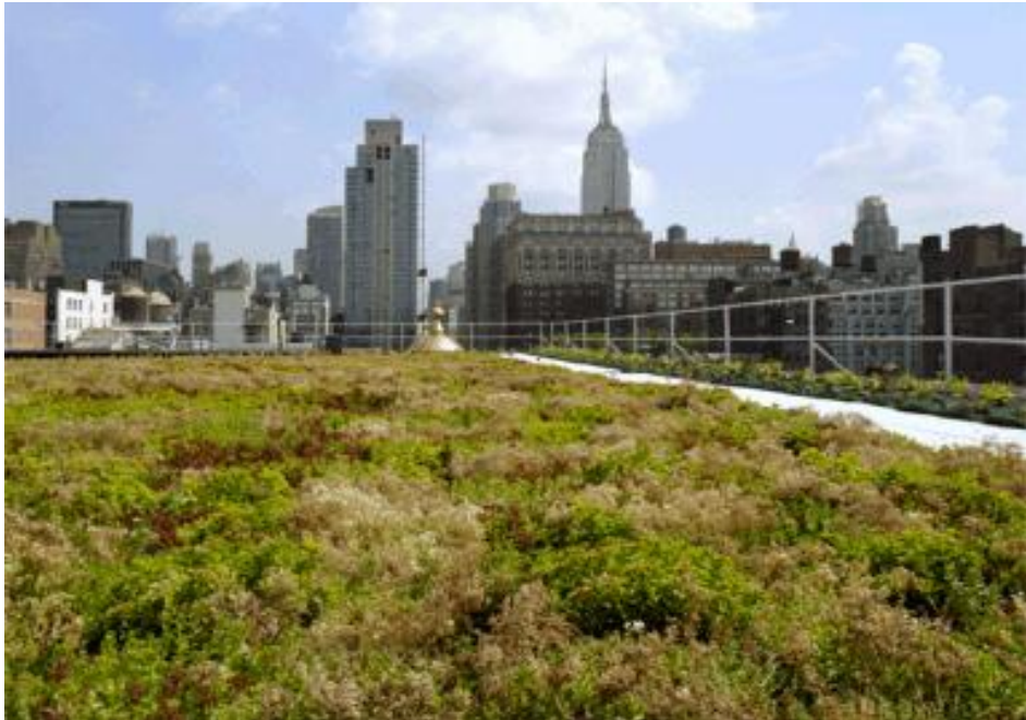
Şekil 2.5 Ekstansif Yeşil Çatı on the Cook + Fox offices, New York (Beitz, 2011)
