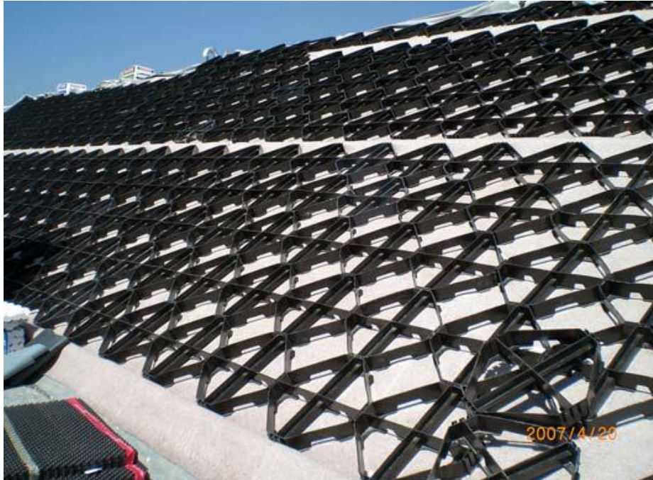
Şekil 4.32 Yeşil çatıda georast uygulaması (The Meydan- Center in İstanbul has model character, b.t)
