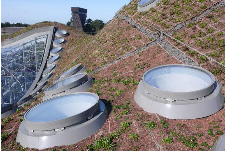
Şekil 4.11 Tamamlanmış modüler yeşil çatı sisteminden bir görünüş (Academy of Science in California, b.t)
