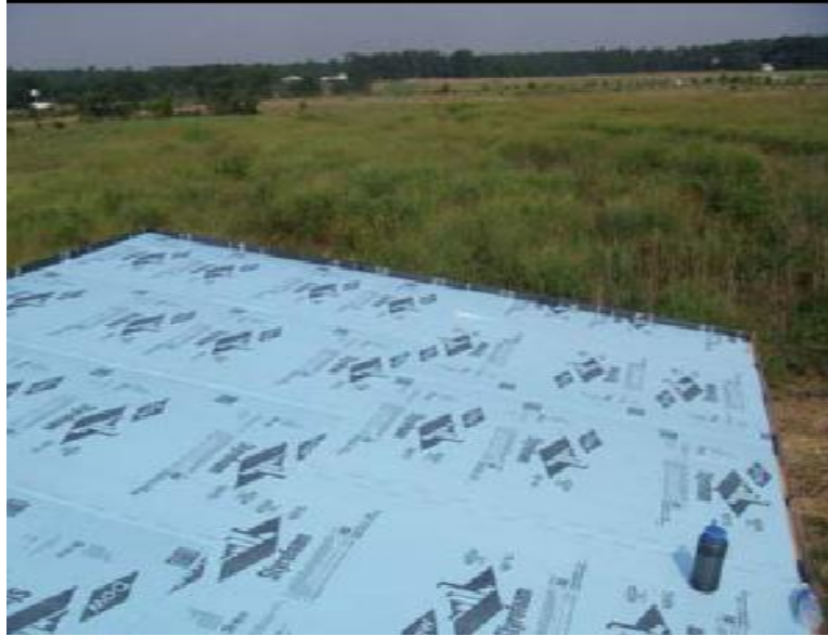
Şekil 3.7 Isı yalıtım tabakası (Ancaya, b.t)
