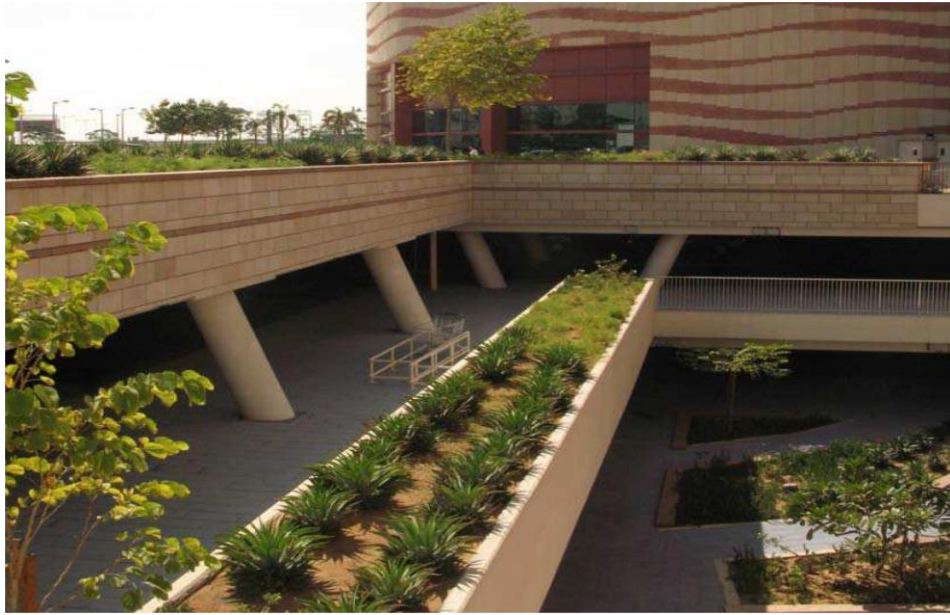
Şekil 3.3 Yer altı otoparkı, Dubai (Green Roof Manual, 2009)
