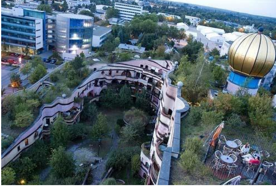
Şekil 2.7 İntansif bir yeşil çatı örneği Waldspirale'in üstünden bir görünüm, Darmstadt, Almanya'da bir konut yapı kompleksi (Ni, 2009)
