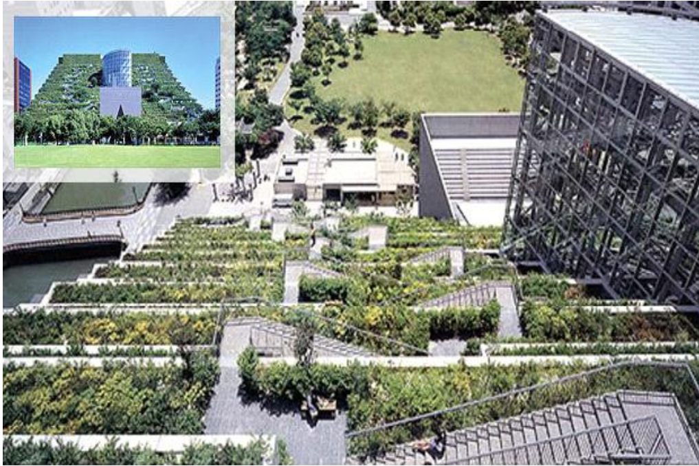
Şekil 2.14 Fukuoka Belediye binası (Green roof guidelines, b.t)
