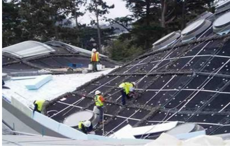
Şekil 4.9 Yeşil çatı kafes sistemi (Academy of Science in California, b.t)
