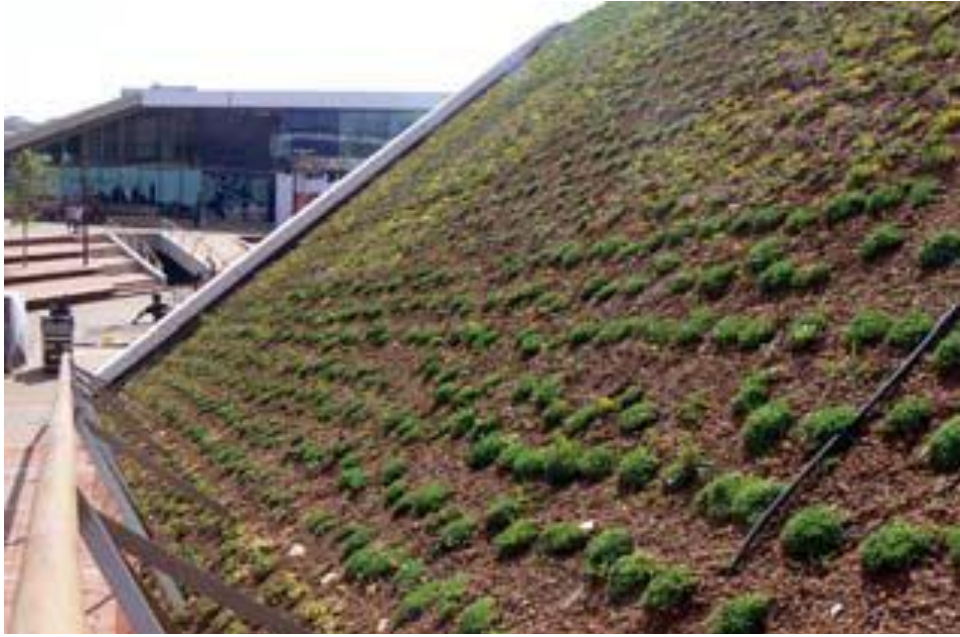
Şekil 4.28 Aşırı eğimli yeşil çatıdan bir görünüş (Zinco, b.t)
