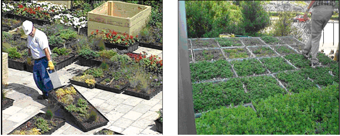
Şekil 3.22 Modüler yeşil çatı sistemi (Dinsdale ve diğer., 2006)
