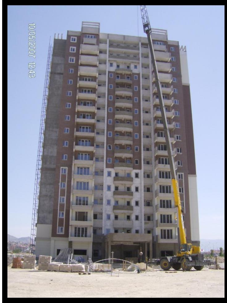
Şekil 3.15 Yapı-vinç ilişkisi. (Dilek Tezgelen arşivinden, 2007).
