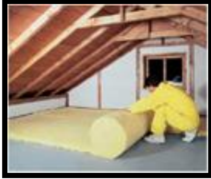
Şekil 2.16 Lifli ısı yalıtım malzemelerinden keçe uygulaması (İzocam,2010)
