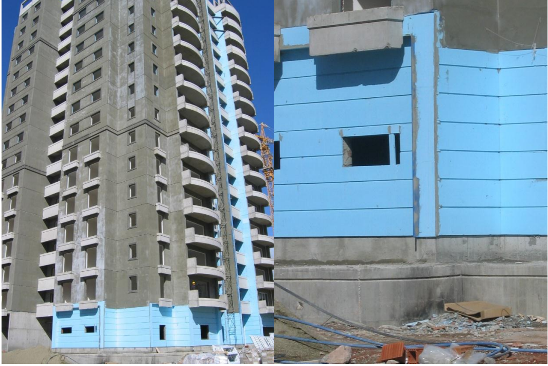
Şekil 3.16 SOYAK Mavişehir evleri yalıtım önlemleri. (Dilek Tezgelen arşivinden,2007).
