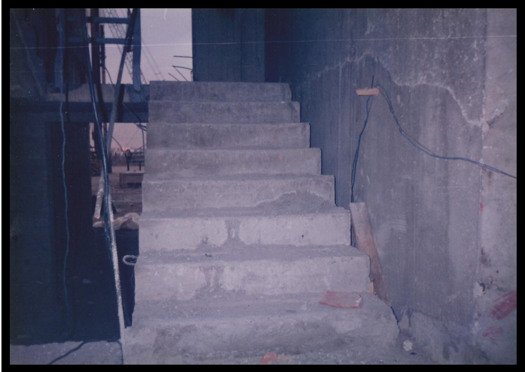
Şekil 3.10 Mavişehir I.Etap prekast merdiven. (Dilek Tezgelen arşivinden,1991).
