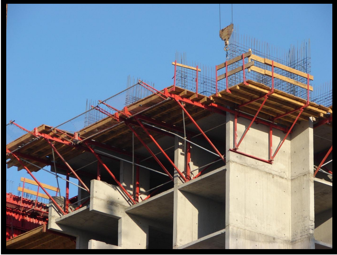
Şekil 3.11 Kalıp boyutlarına bağlı belirlenen mekan ölçüleri. (www.mesaimalat.com).
