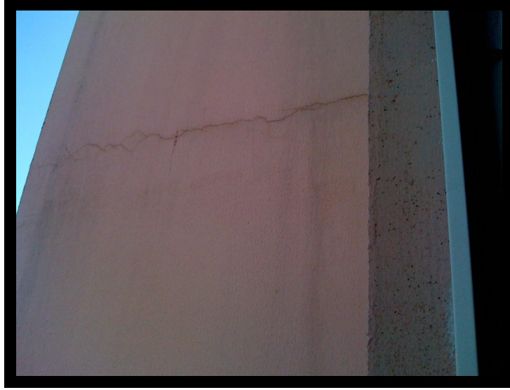
Şekil 4.73 TOKİ Uzundere Evleri dış cephe görünüşü (1)(Dilek Tezgelen arşivi 2012)
