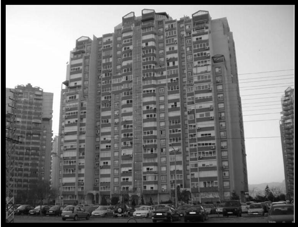
Şekil 3.17 Teras katlı çözümleriyle Mavişehir II.etap evleri Kuğu blokları. (AYDOĞAN, 2005).
