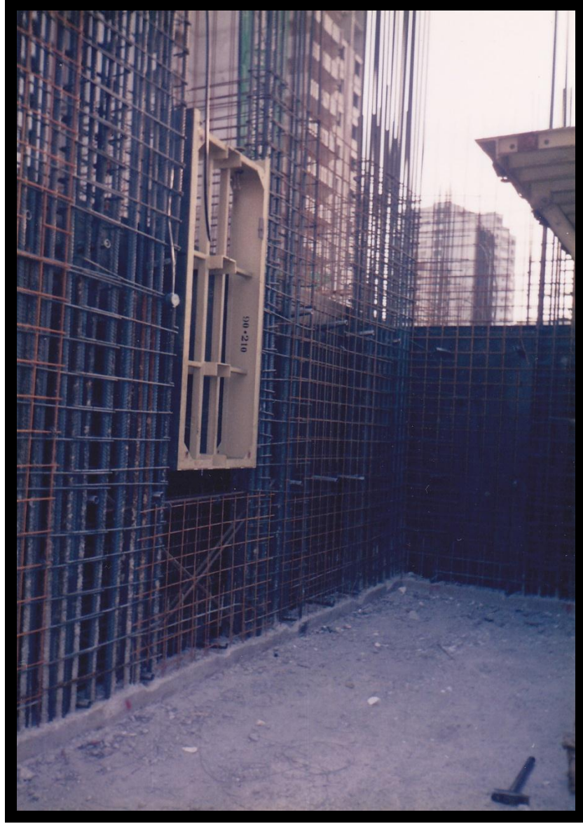
Şekil 3.7 Mavişehir I.Etap Evleri rezarvuvar boşluklarının imalatı.(Dilek Tezgelen arşivinden,1991)
