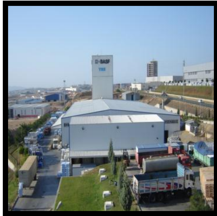
Şekil 2.2 BASF Yapı Kimyasalları Lojistik ve Teknik Geliştirme Merkezi Binası, Gebze
