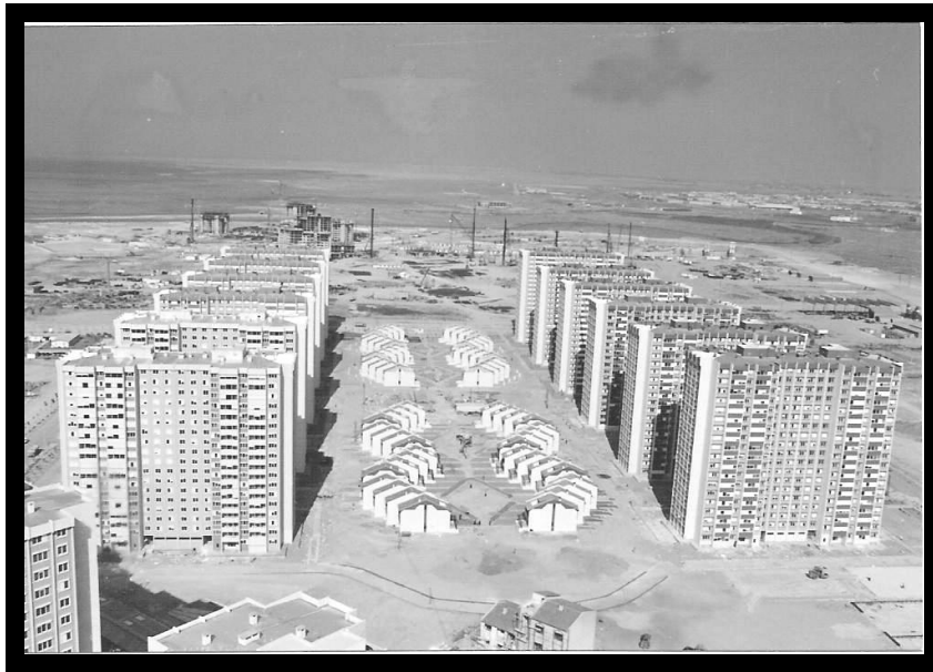
Şekil 4.51 Mavişehir I.Etap inşaat aşamasında (AYDOĞAN, 2005)
