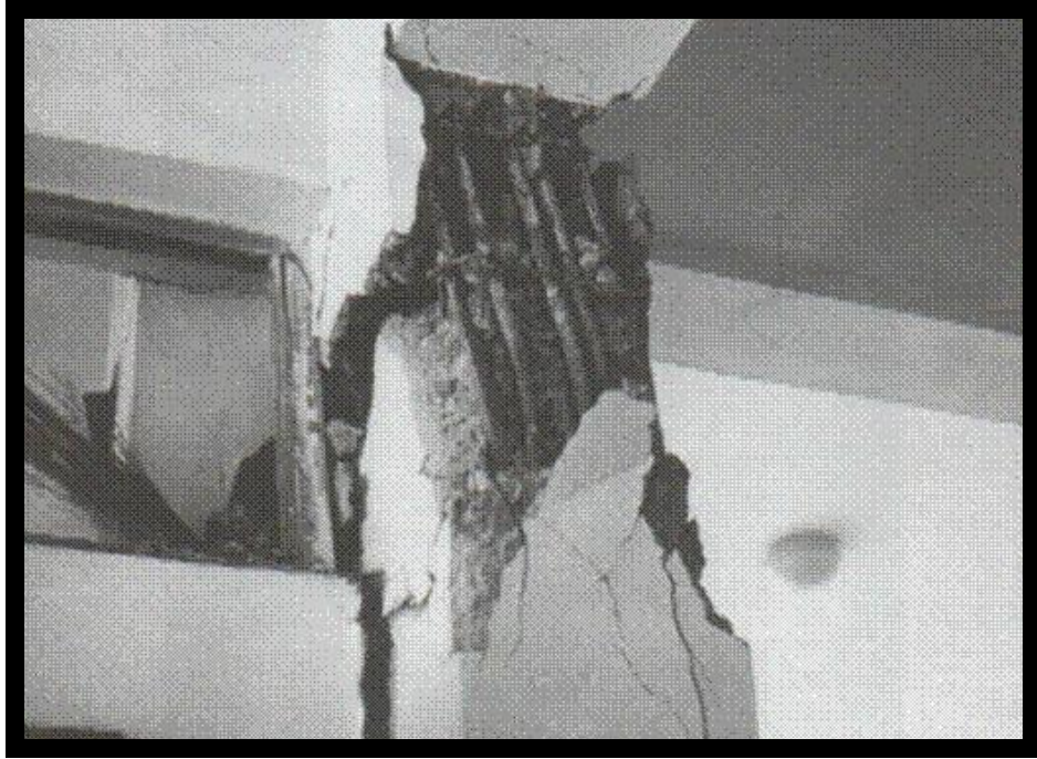
Şekil 2.31 Kolonda oluşan hasar (TMMOB,2009).
