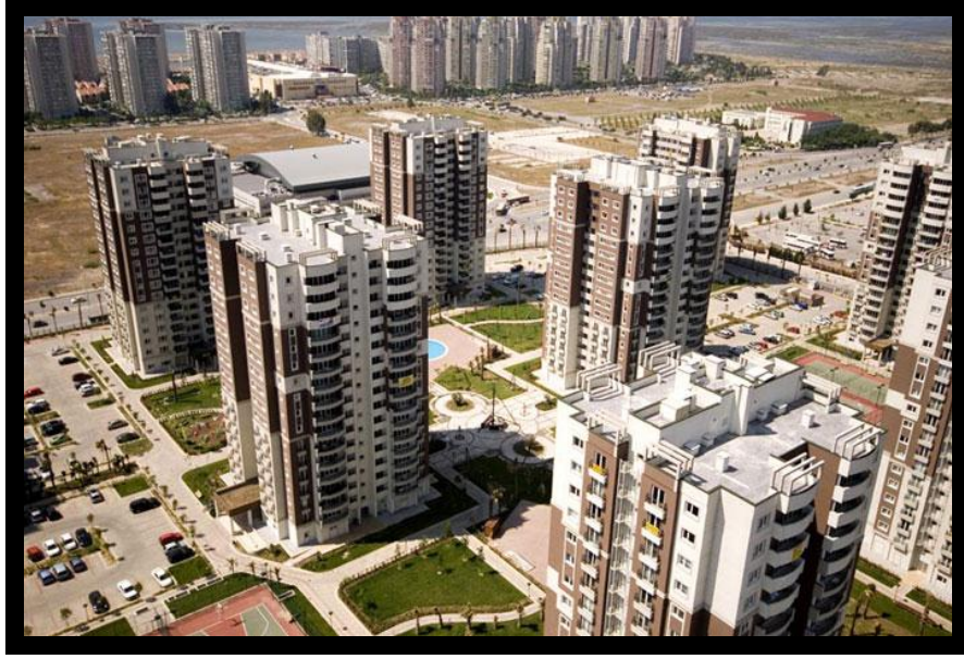
Şekil 4.86 Soyak Mavişehir 1. etap Konutları. (Soyak, bt. ).
