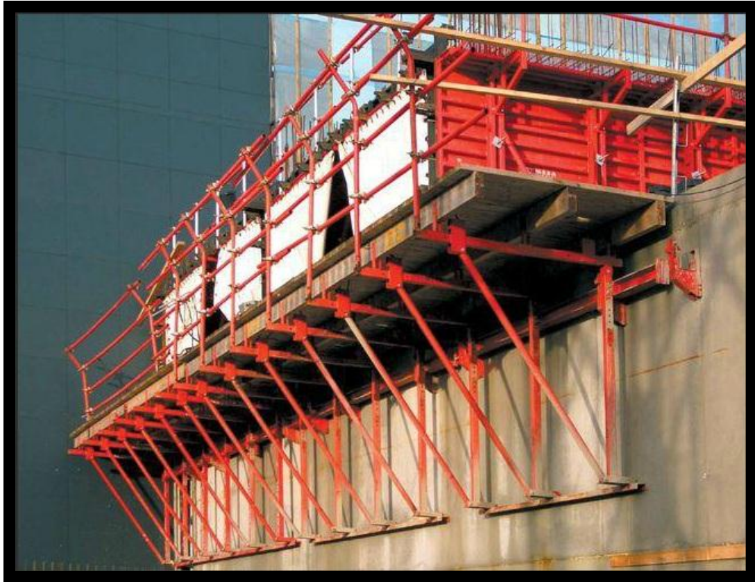
Şekil 3.2 Tünel kalıp sistem .(İnalpolat, 1996).
