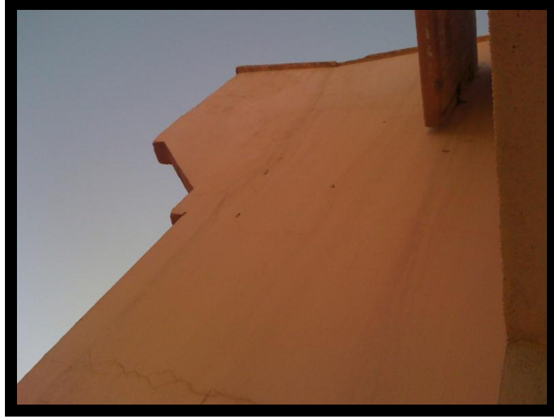
Şekil 4.84 Çatı katı dış cephe görünümü
