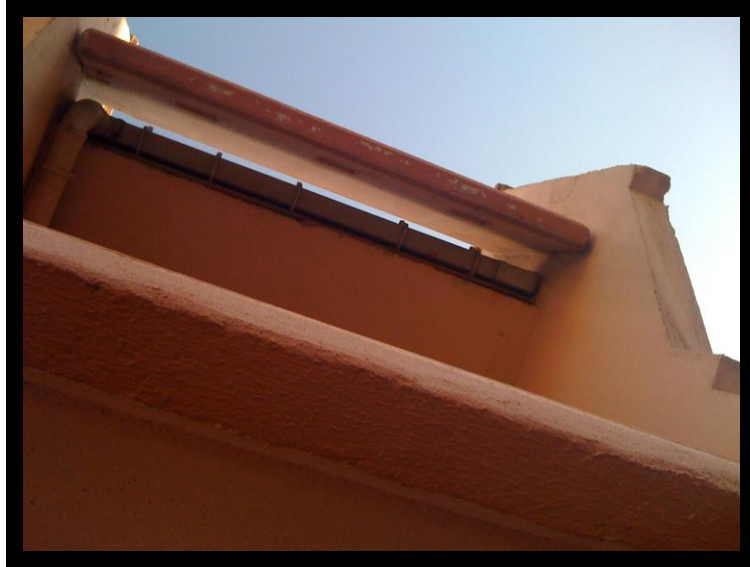
Şekil 4.74 TOKİ Uzundere Evleri dış cephe görünüşü (2) (Dilek Tezgelen arşivi2012)
