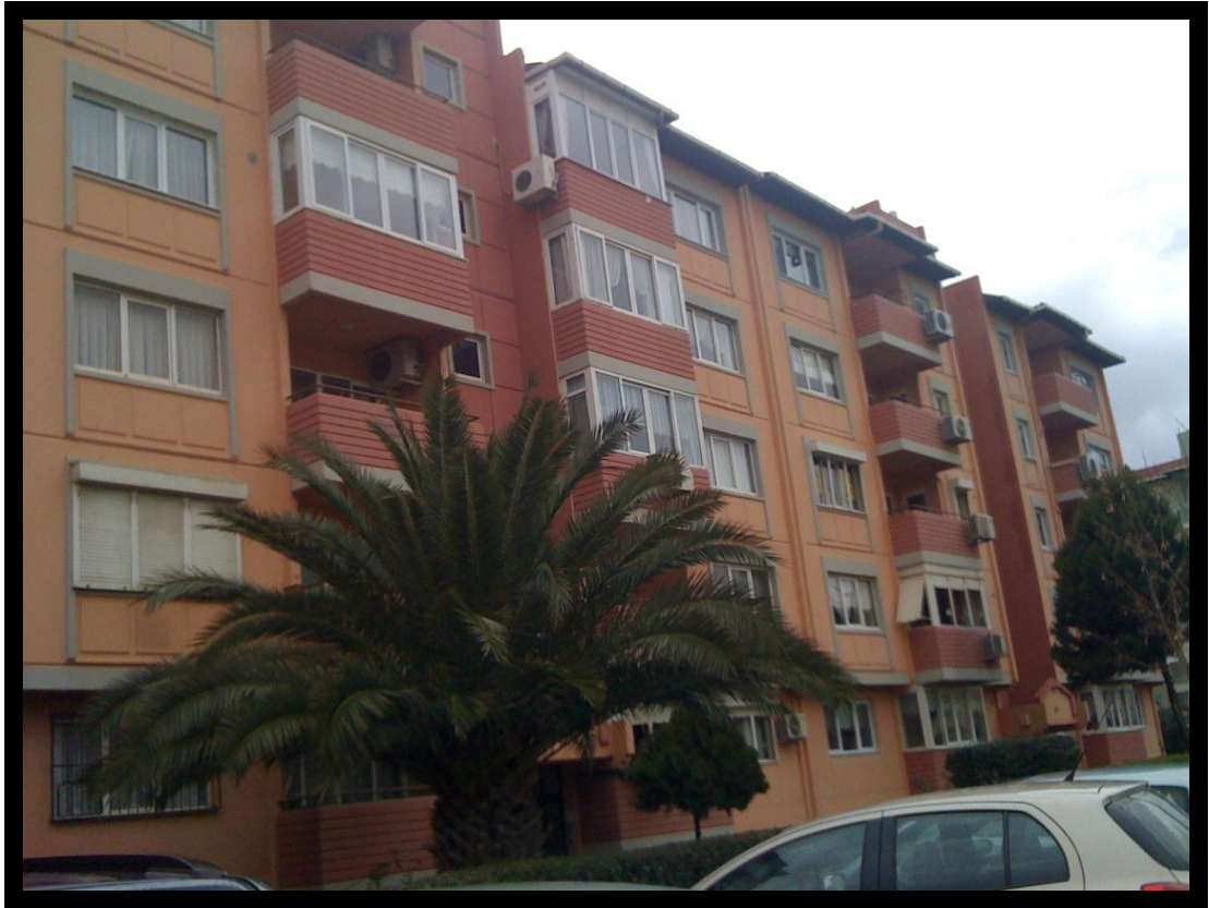
Şekil 4.8 Gazemir Emlak Bankası II. Etap evleri. (Dilek Tezgelen, 2012).
