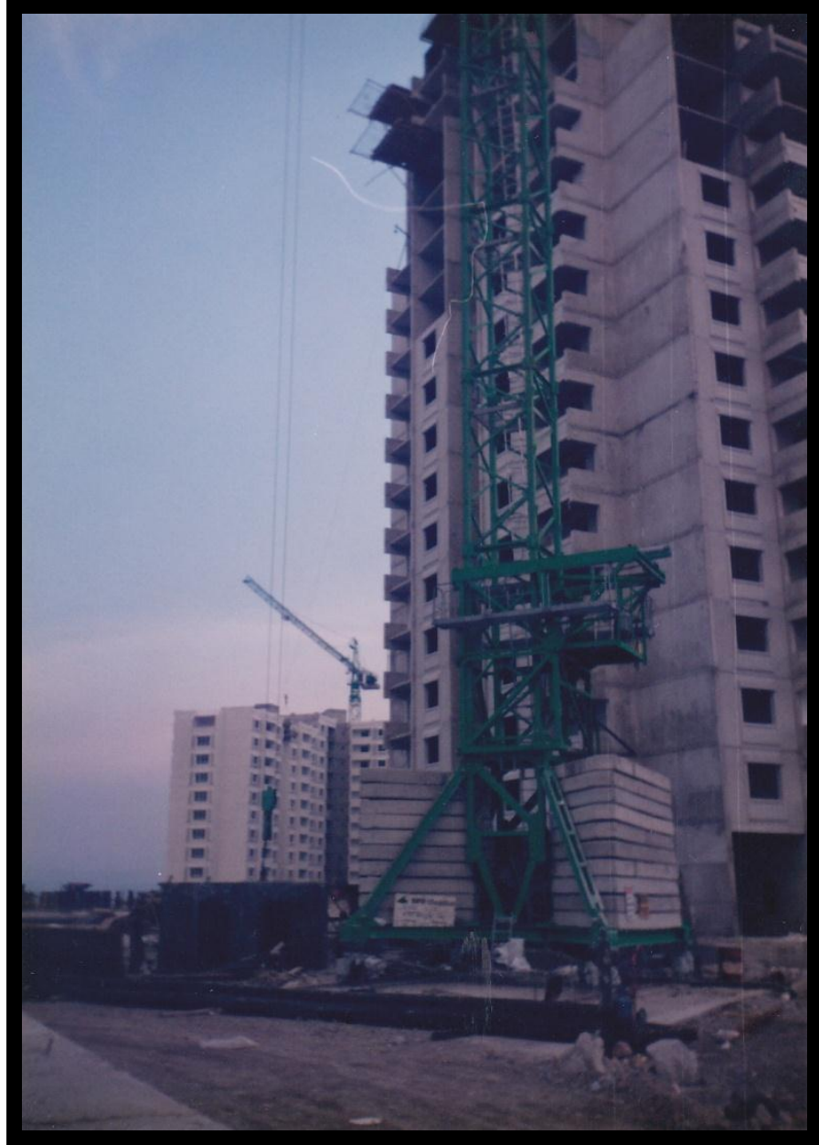
Şekil 3.14 Mavişehir I.Etap Prekast cephe elemanları için kullanılan vinç. (Dilek Tezgelen arşivinden,1991).
