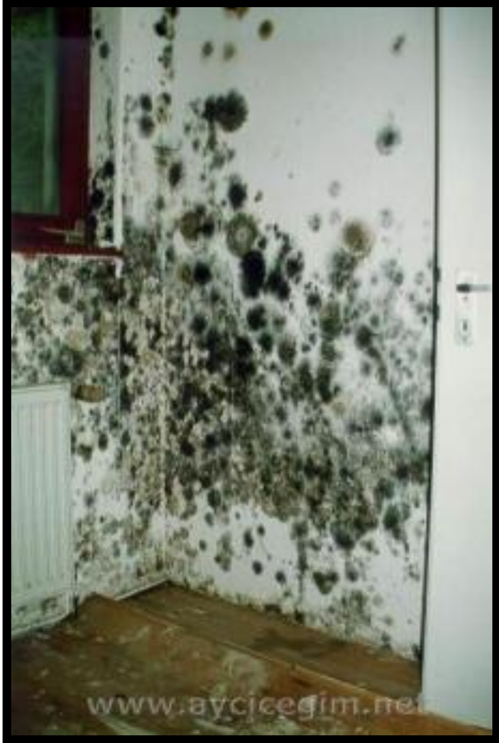
Şekil 2.29 İç mekanda rutubet (TMMOB, 2009)
