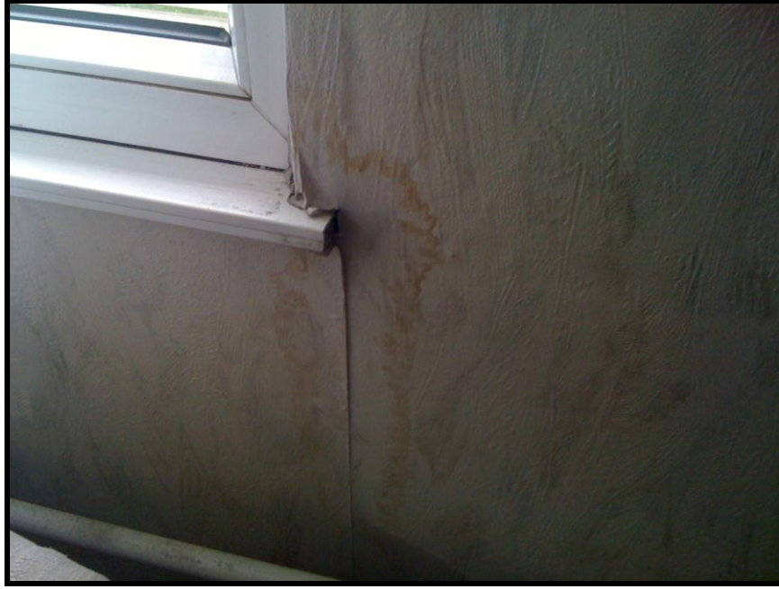
Şekil 4.27 Doğramaların montaj hatasından Kaynaklanan Rutubet Sorunu. (Dilek Tezgelen arşivi, 2012).
