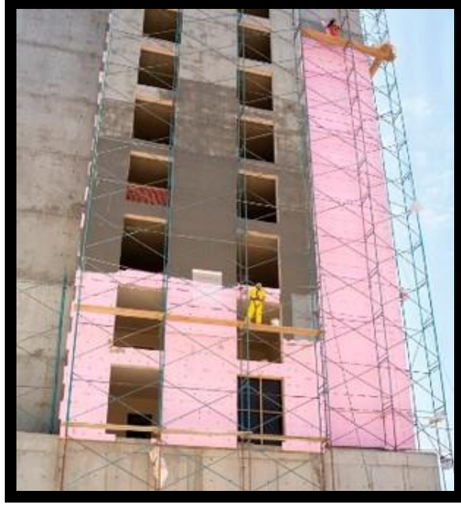
Şekil 2.18(1) Straforun uygulanışı. (izolasyon,2010).
