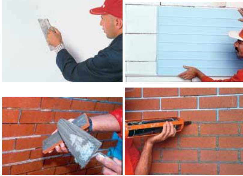
Şekil 3.2 Tuğla kaplama aşamaları ( http://building.dow )
