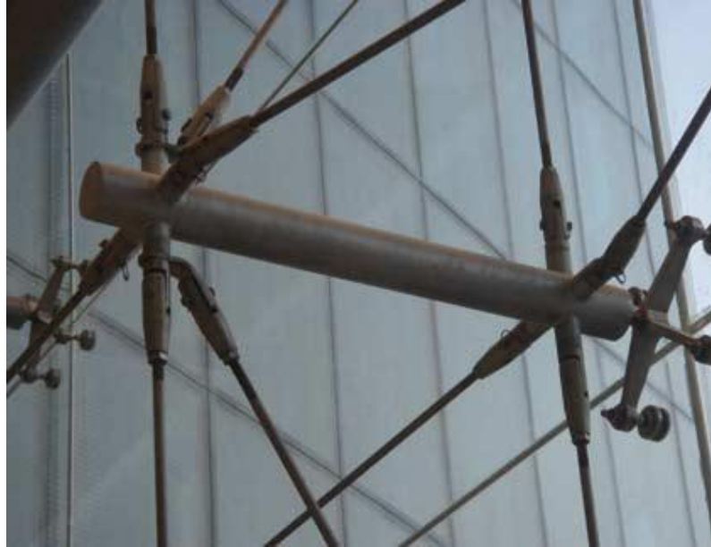
Şekil 3.21 Noktasal bağlantılı sistem giydirme cephe (discephegiydirmenet, 2012)
