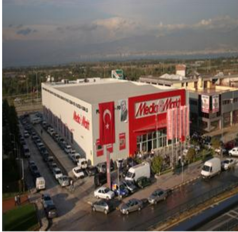
Şekil 3.32 Trapez sac uygulaması. Kaset sistem taşıyıcı + tek kat trapez sac. (Media Markt Elektronik Market Balçova/ İzmir ( http://www.artikelmuhendislik.com )
