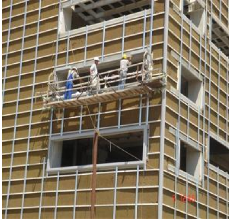
Şekil 3.31 Trapez sac uygulaması. Kaset sistem taşıyünü + tek kat trapez sac (Polyplex Folyo Fabrikası / Çorlu, http://www.artikelmuhendislik.com )
