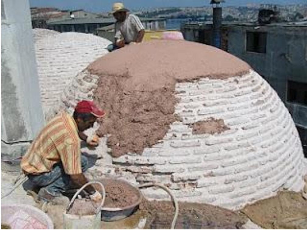
Şekil 2.3 Horasan harcı ile restorasyon çalışması ( http://www.renovanews.com )
