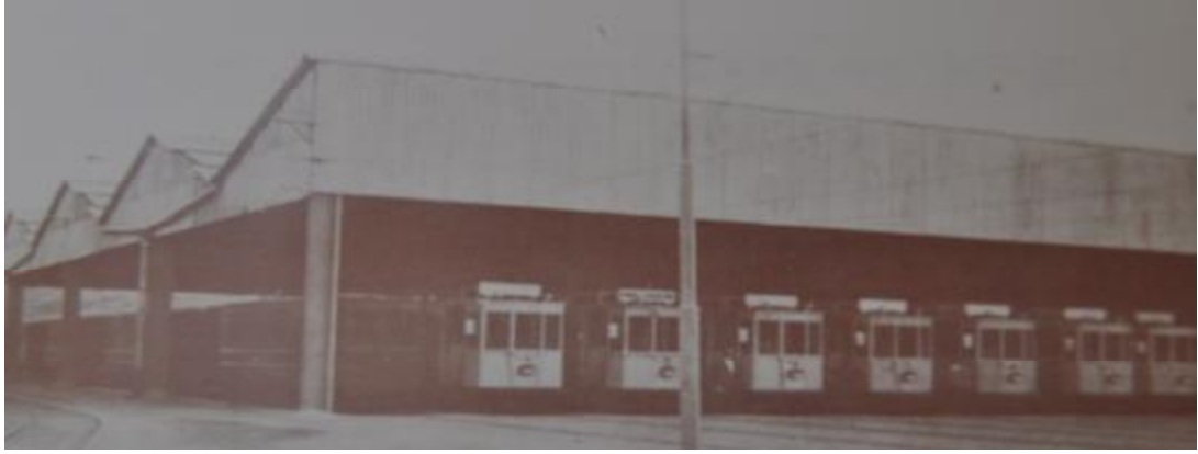
Şekil 3.2 Güzelyalı elektrikli tramvay garajı(ESHOT,2011a)
