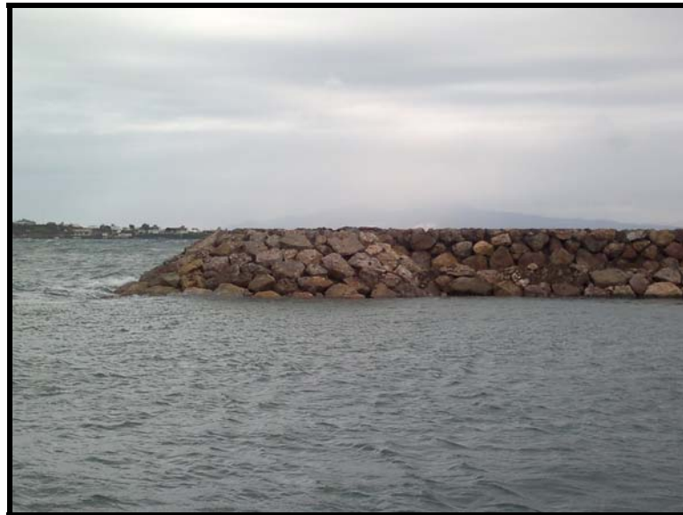
Şekil 5.29 Müzvar kısmı (onarım sonrası).
