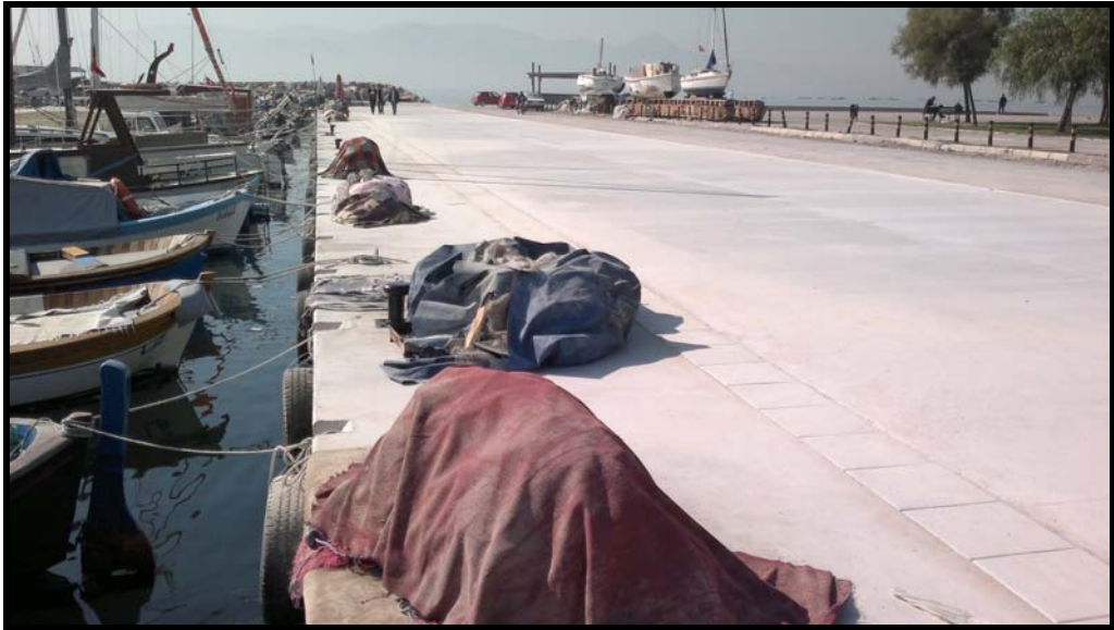
Şekil 5.38 Rıhtım ve geri sahası (onarım sonrası).
