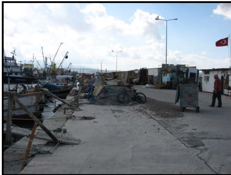
Şekil 5.40 Sirkülasyon kanalı sonrası rıhtım hattı (onarım öncesi).
