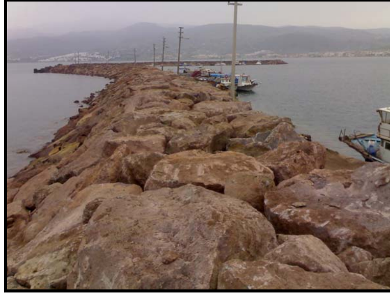
Şekil 5.17 Kret genişliği 3.75 m, şev eğimi 2/3 (onarım sonrası).
