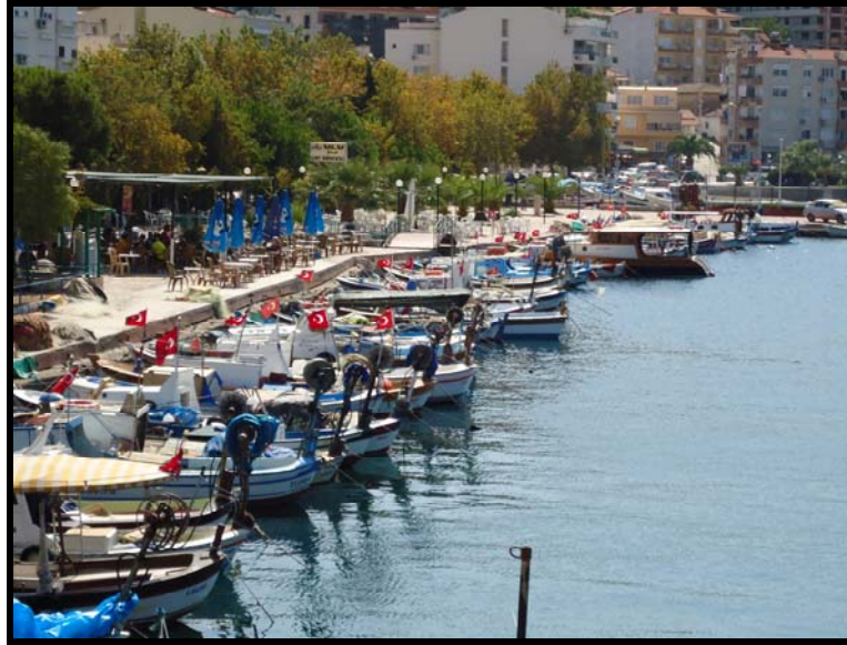
Şekil 5.10 Mevcut rıhtıma bağlı küçük tekneler (onarım öncesi).
