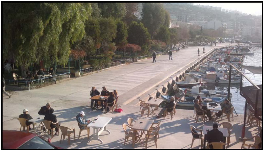
Şekil 5.12 Onarımı tamamlanmış rıhtıma bağlı küçük tekneler (onarım sonrası).
