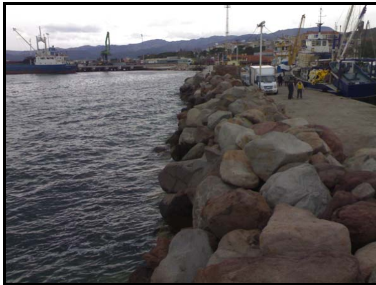
Şekil 5.2 Yetersiz kesit ve kategoriye sahip mendirek (onarım öncesi).
