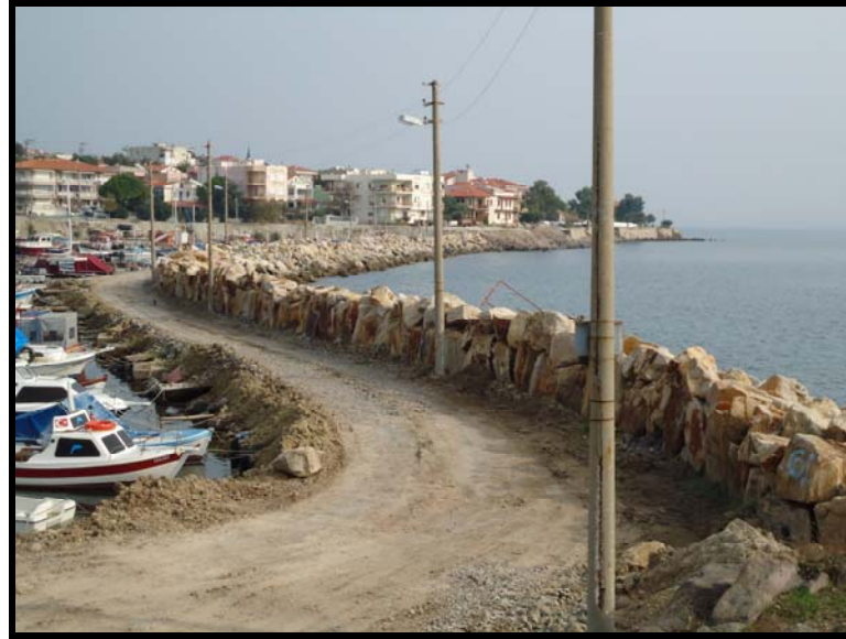
Şekil 5.16 Kret genişliği 0.5-1 m mertebesinde (onarım öncesi).
