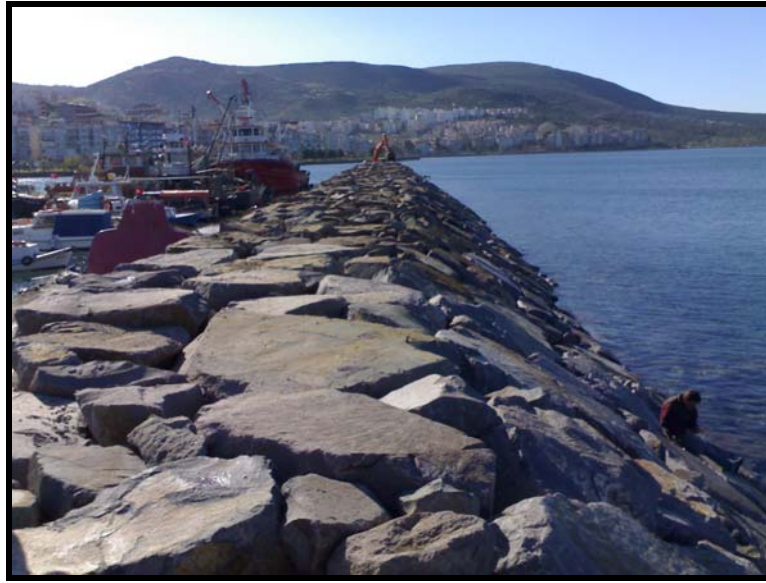
Şekil 5.3 4 m genişlikte kret'e ve 2/3 şev eğimine sahip mendirek (onarım sonrası).
