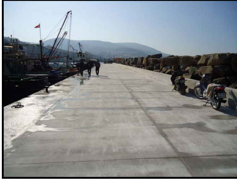
Şekil 5.7 Ortalama üst kotu +0.20 m'den +1.00 m'ye çıkarılan rıhtım (onarım sonrası).
