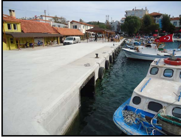
Şekil 5.8 Ortalama üst kotu +0.35 m'den +1.00 m'ye çıkarılan rıhtım (onarım sonrası).
