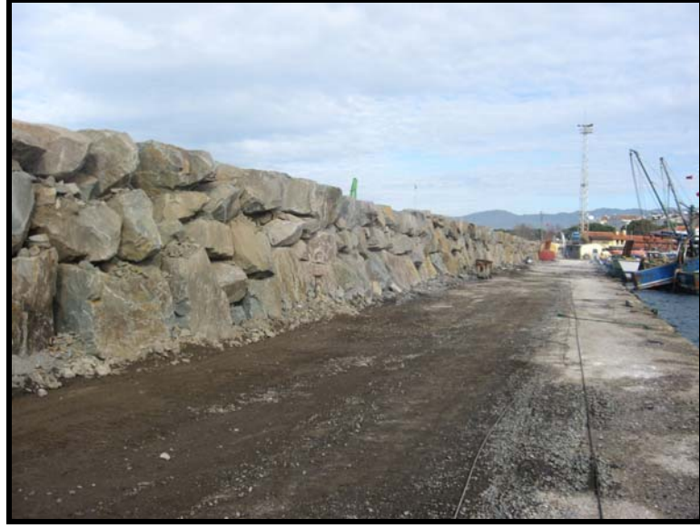
Şekil 5.4 +3.50 m. kret kotuna sahip mendirek (onarım sonrası).
