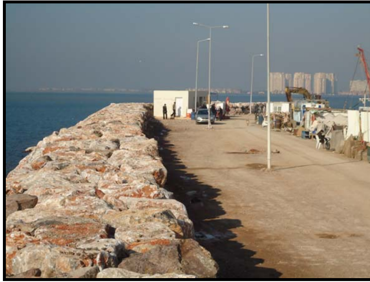
Şekil 5.34 Kret genişliği 3 m, şev eğimi 2/3 (onarım sonrası).
