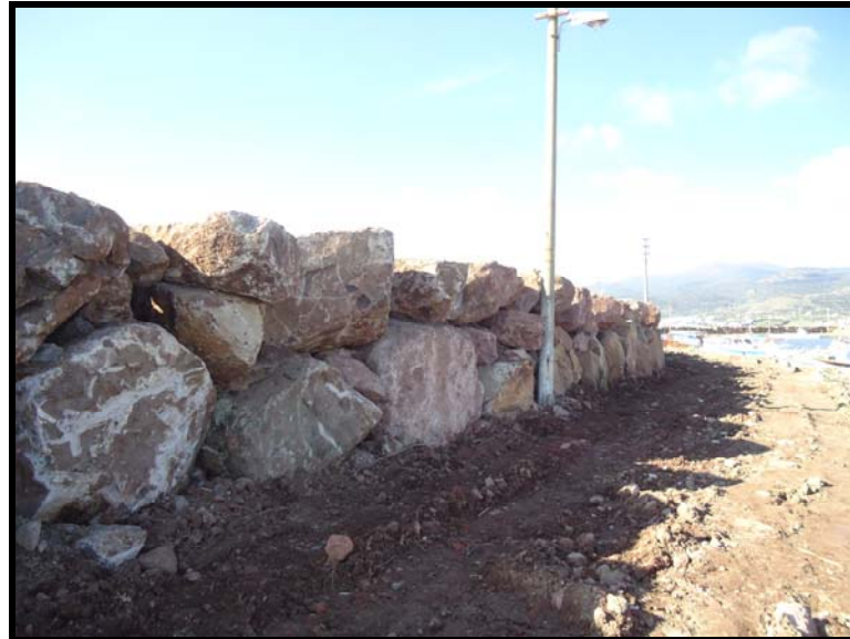
Şekil 5.18 +3.50 m kret kotuna sahip mendirek (onarım sonrası).
