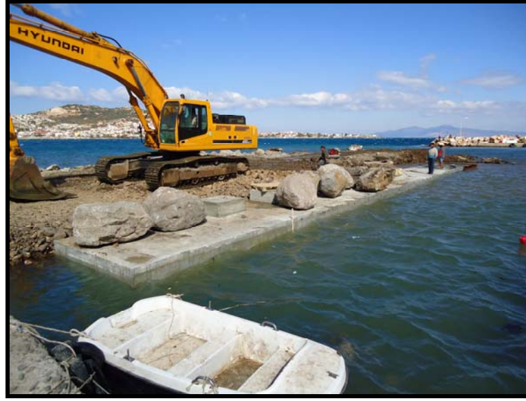
Şekil 5.24 Tamamlanan su içi beton imalatı sonrası sürşarj.
