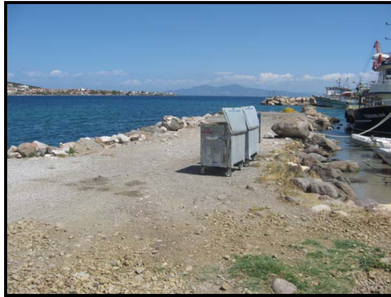
Şekil 5.23 Mevcut dolgu (onarım öncesi).
