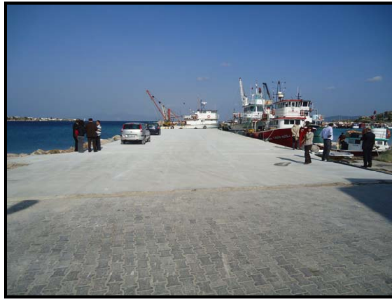
Şekil 5.25 Yapımı tamamlanan rıhtım ve geri sahası (onarım sonrası).
