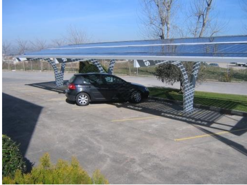
Şekil 2.15 Fotovoltaik panellerin üst örtü olarak kullanımı, Vidurglass otoparkı, İspanya (Pvdatabase, bt.)
