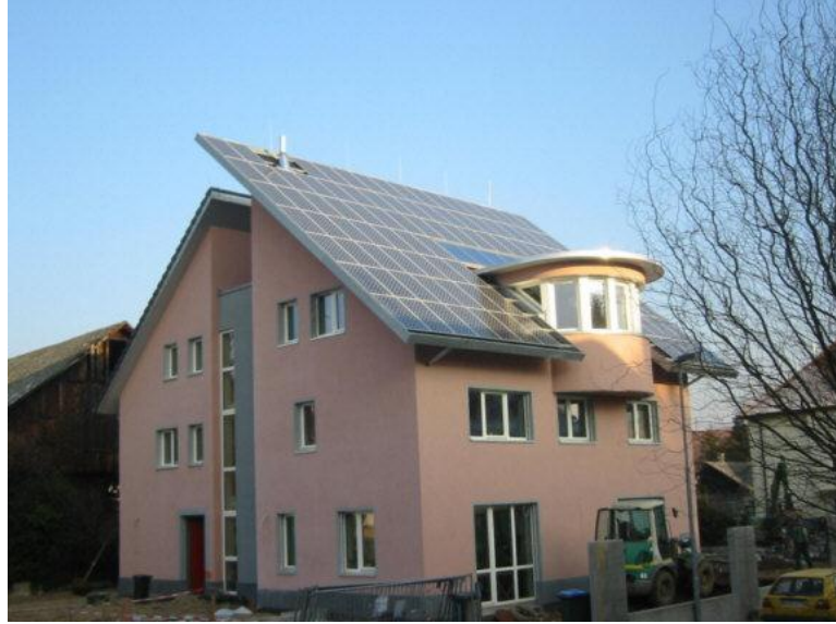
Şekil 2.18 Fotovoltaik panellerin eğik çatıda uygulaması, Almanya (Pvdatabase, bt.)
