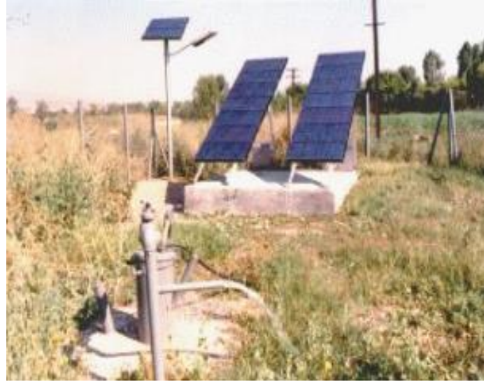
Şekil 2.15 Atatürk Orman Çiftliğinde ki su pompaj sistemi (YEGM, 2012)
