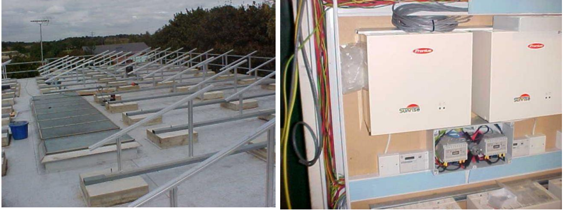
Şekil 3.29 PV panel taşıyıcı strüktürü ve invertörlerden bir görünüş (Pvdatabase, bt.)
