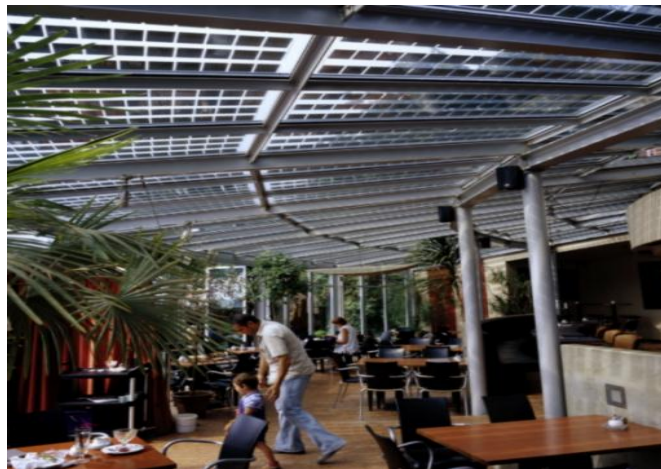
Şekil 2.17 Fotovoltaik panellerin çatıda ışıklık olarak kullanımı - Cafe Ambiente, Bremen, Almanya (Pvdatabase, bt.)
