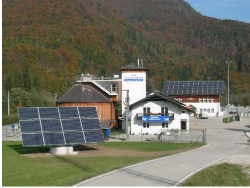
Şekil 2.24 Fotovoltaik panellerin yapıdan bağımsız olarak uygulaması, Dernek binası, Avusturya (Pvdatabase, bt.)
