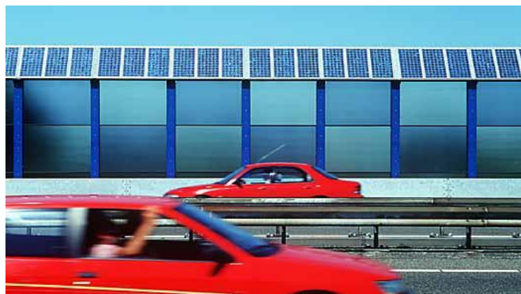
Şekil 2.23 Fotovoltaik panellerin ses kırıcı olarak kullanımı, Hollanda (Pvdatabase, bt.)
