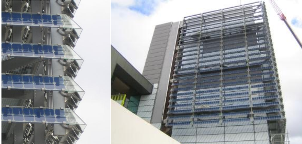
Şekil 2.22 Fotovoltaik panellerin cephede güneş kırıcı olarak kullanımı, Sağlık Merkezi, İspanya (Pvdatabase, bt.)
