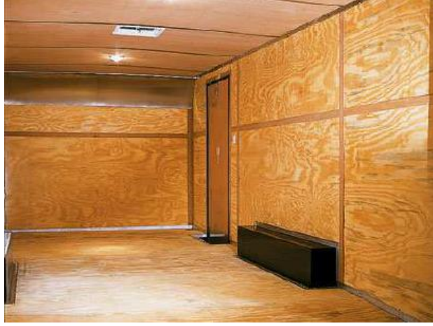
Şekil 3.38 Kontrplak döşeme ve duvar kaplaması (Seçkin, 2006)
