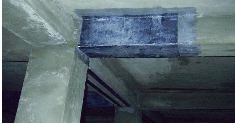
Şekil 3.19 FRP uygulanmış giriş (Yonteminsaat, 2008)
