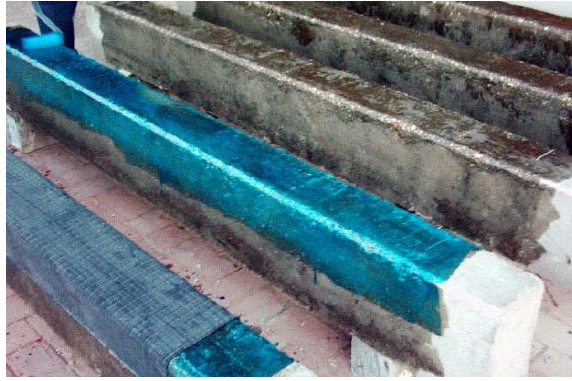
Şekil 3.18 FRP uygulaması (Özcan, 2005)
