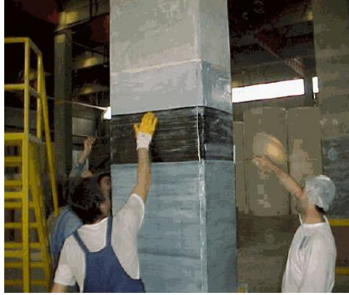
Şekil 3.17 FRP'nin betonarme bir kolonda gösterilmesi (Yonteminsaat, 2008)
