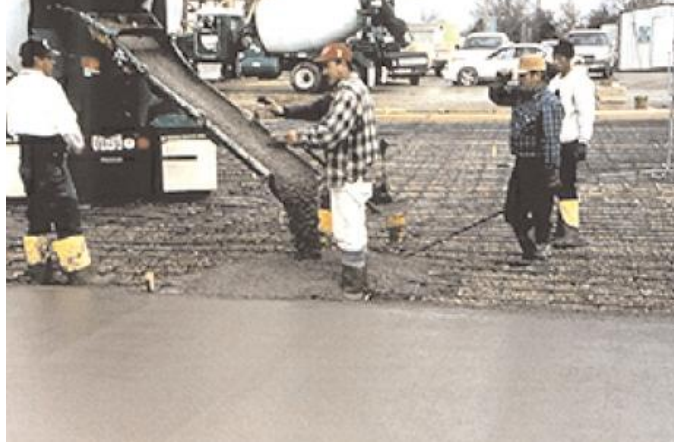
Şekil 3.26 Hazır beton dökümü ( Şimşek, 2007)
