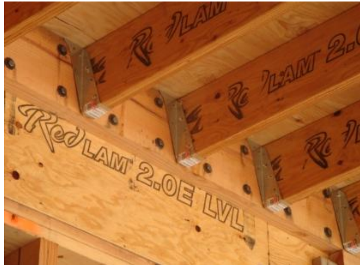
Şekil 3.41 LVL uygulaması (Redbuilt, 2012)
