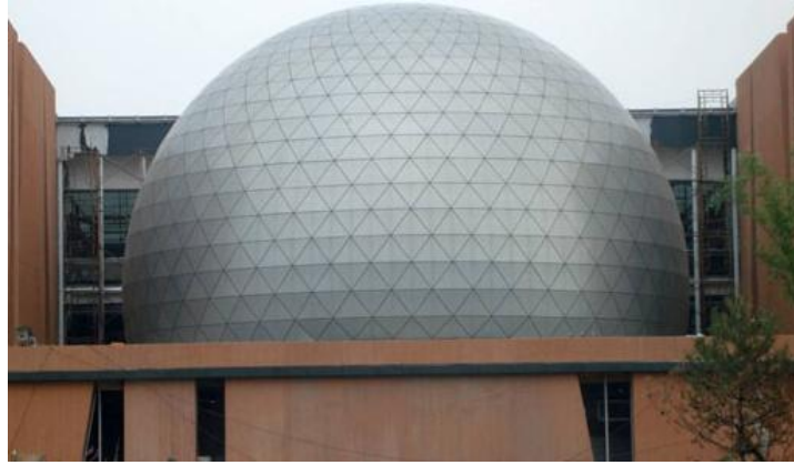
řekil 3.7 inko kompozit panel uygulaması (Huayuanfu, 2012)
