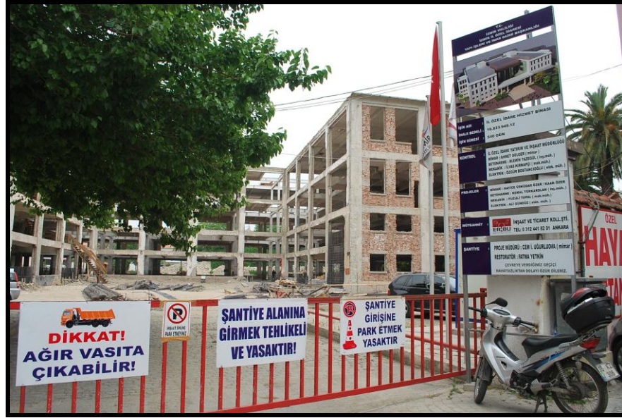
Şekil 4.5 Eski Tekel Tütün Fabrikası restorasyonu.
