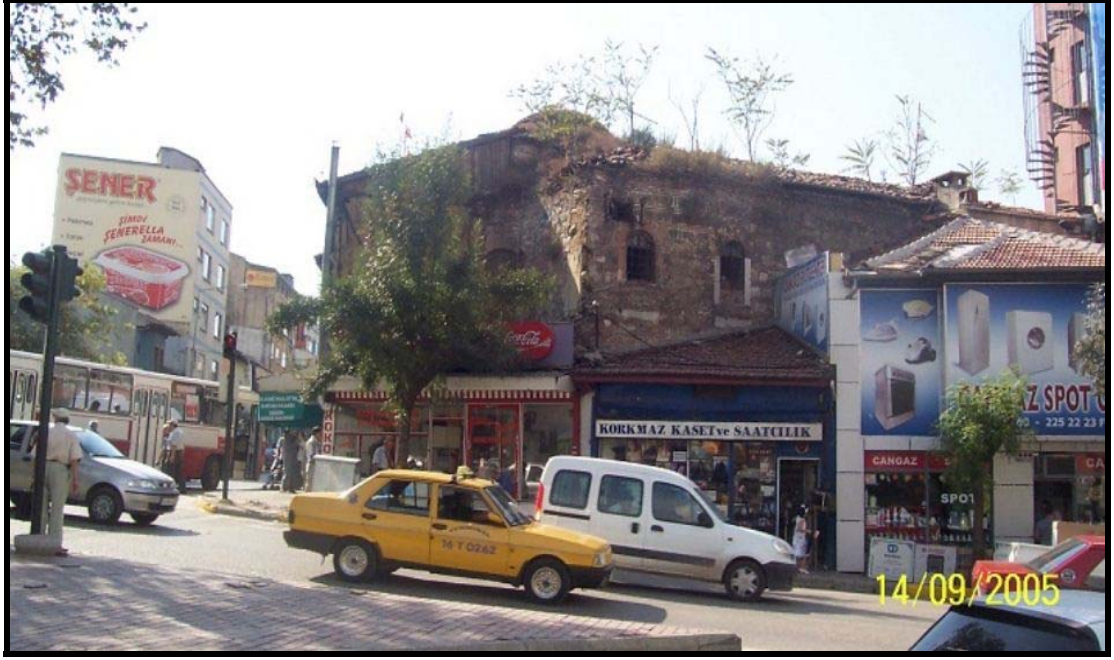
Şekil 2.7 Yeni Galle Pazarı Hanı'nın yapılan çalışmalardan önceki durumu (Bursayı tanıtıyoruz, bt).
