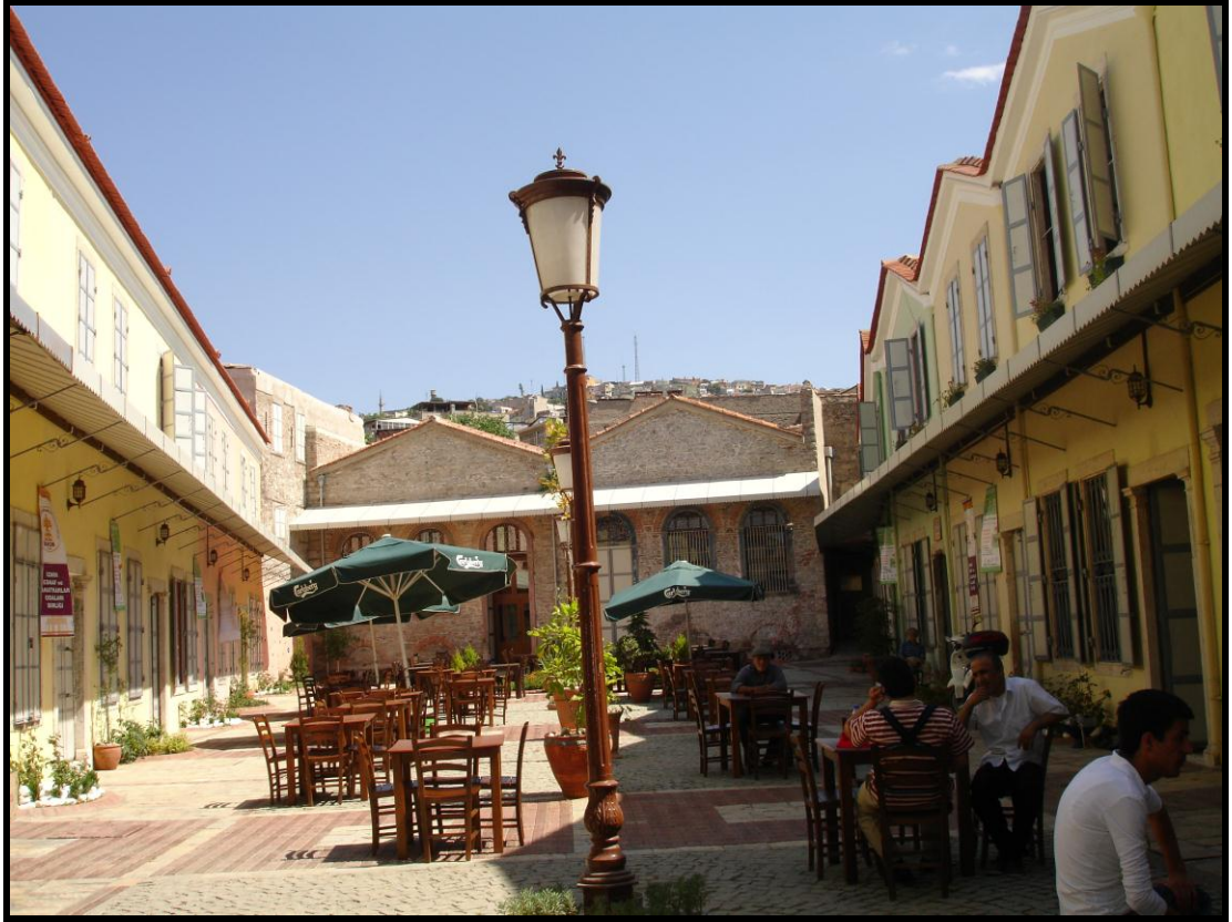
Şekil 4.14 Abacıoğlu Hanı'nın yapılan çalışmalardan sonraki görünümü (İzmir Konak Belediyesi AR-GE Müdürlüğü arşivi).
