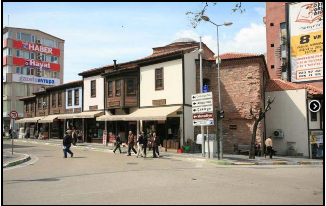
Şekil 2.8 Yeni Galle Pazarı Hanı'nın çalışmalardan sonraki durumu (Bursa, bt).
