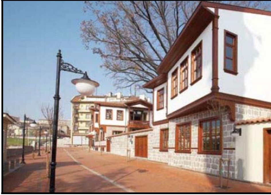
Şekil 2.5 Hamamönü'nde yer alan Mehmet Akif Ersoy Sokağı'nın çalışmalarından sonraki durumu (aso, bt).
