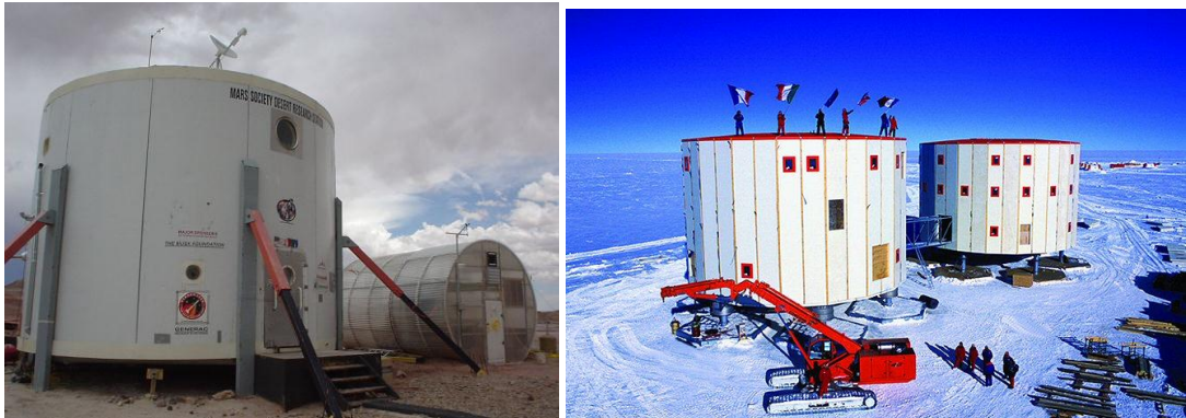
Şekil 1.2 Mars Araştırma İstasyonu ve Concordia İstasyonu (Concordia Station, 2012)
