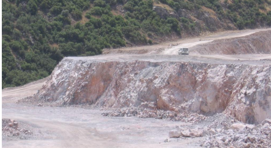
Şekil 6.2 Çimentaş İzmir Çimento Fabrikası Türk A.Ş' ye ait bir patlatma aynasından görünüm.
