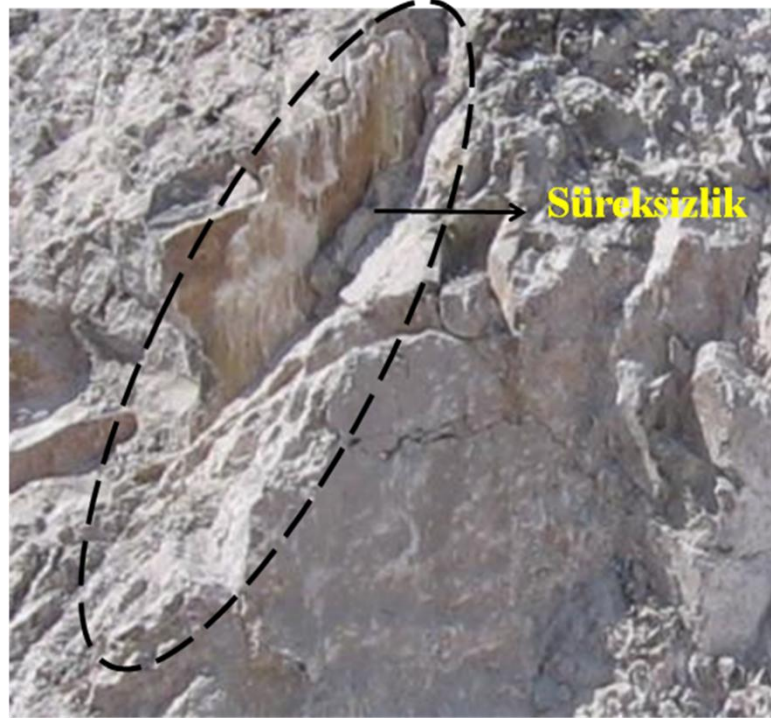
Şekil 3.1 Bir patlatma aynasında gözlenen süreksizliklere örnek.
