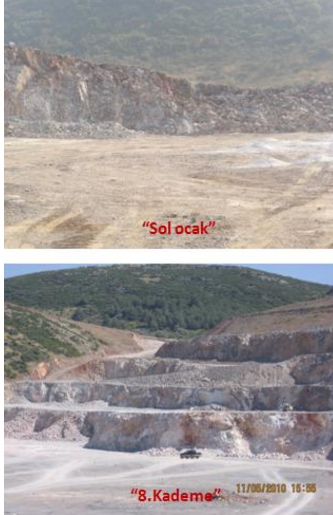
Şekil 6.4 “Sol ocak” ve “8.kademe”den genel görünüm.
