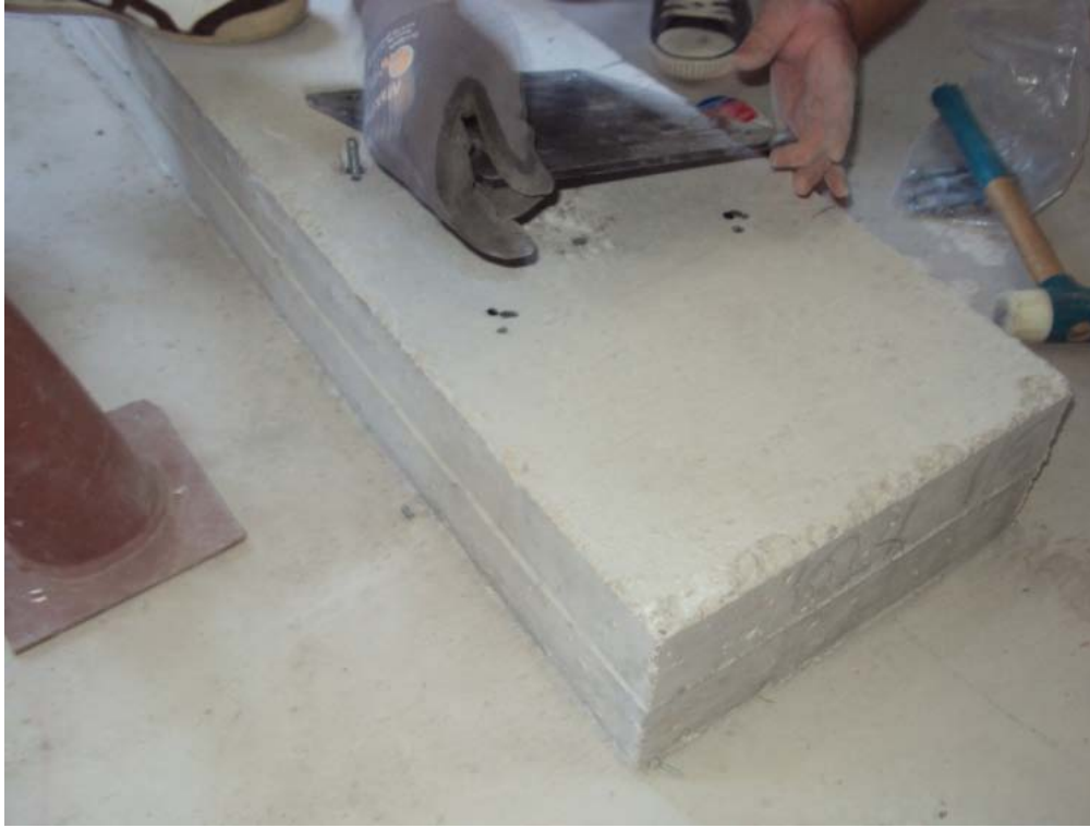
Şekil 8.9 Sacın betonarme plak üzerine yerleştirilmesi.
