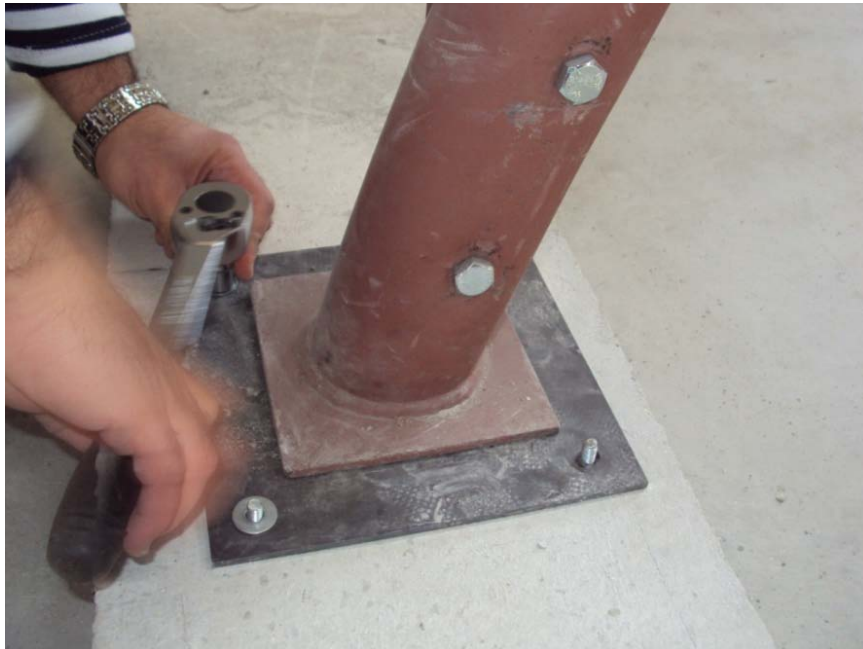
Şekil 8.10 Köprü ayaklarının dübellenmesi.
