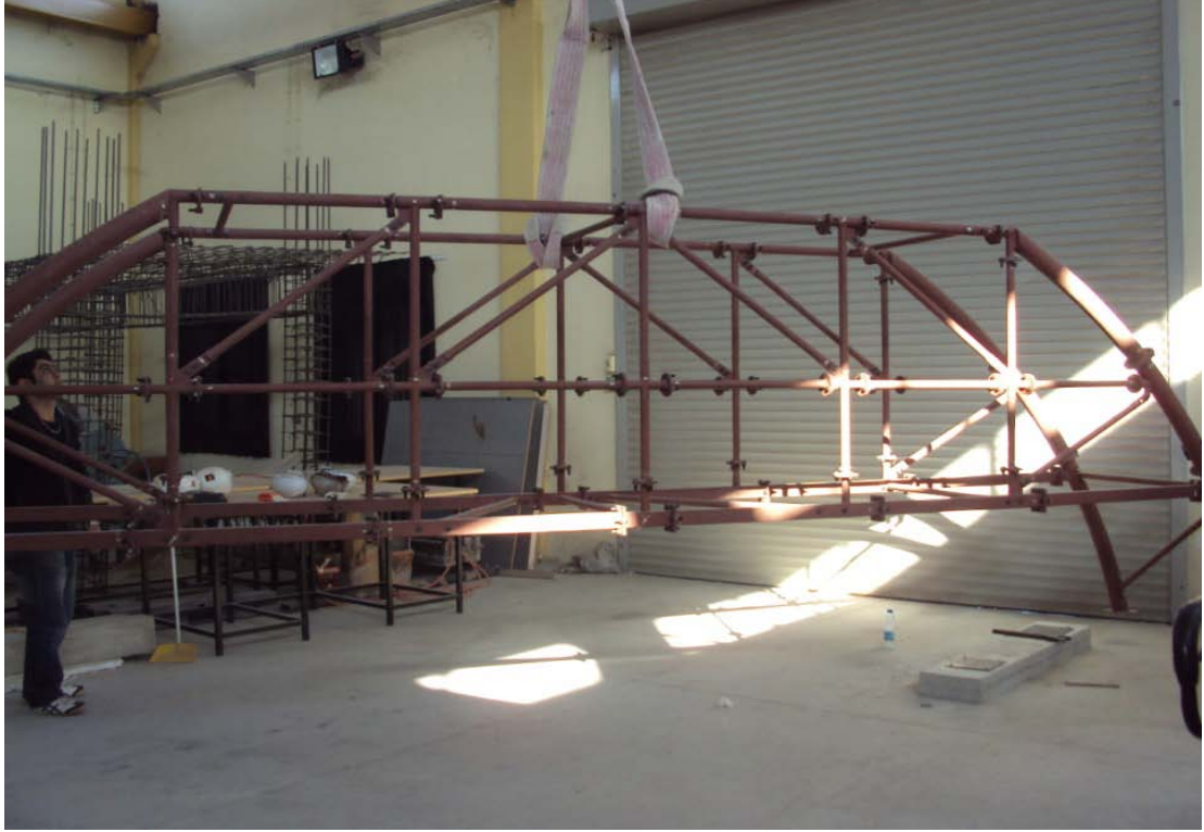
Şekil 8.7 Köprü'nün betonarme blok üzerine yerleştirilmesi.
