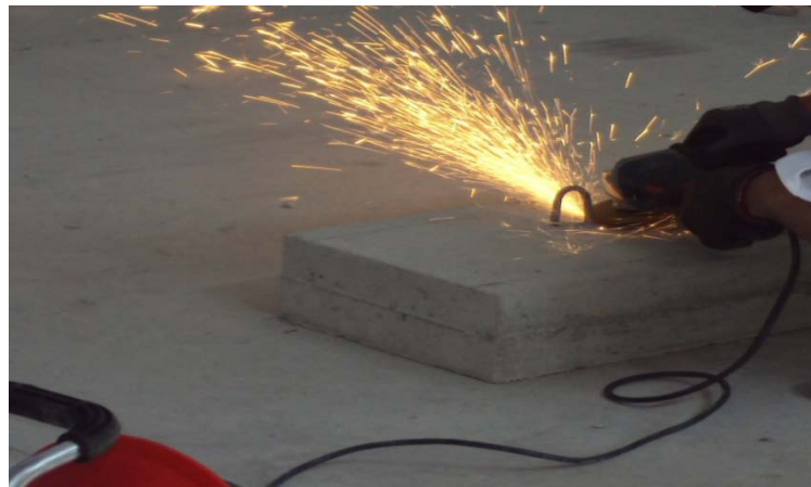
Şekil 8.4 Betonarme blokta bulunan kancaların kesilmesi.
