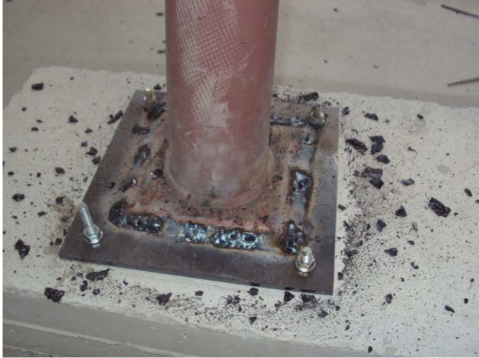
Şekil 8.11 Köprü Ayaklarının Kaynaklanarak Mesnetlenmesi.
