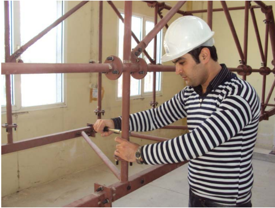
Şekil 8.13 Köprünün bağlantılarının belirli tork değeri ile sıkılması.
