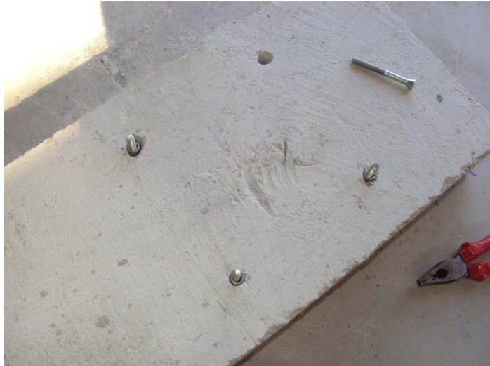
Şekil 8.6 Betonarme bloğa dübellerin yerleştirilmesi.
