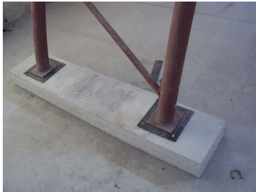
Şekil 8.8 Köprü ayaklarının görünümü.
