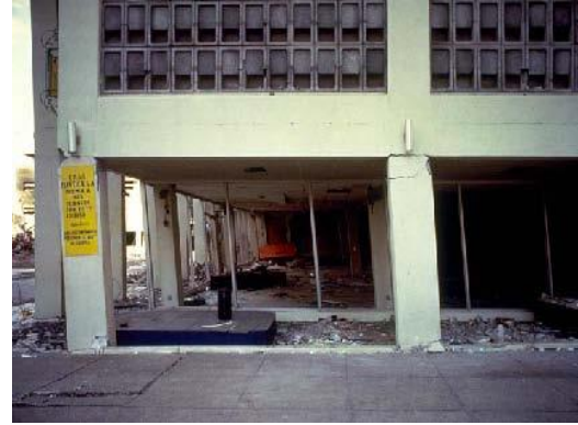
b) Yumuşak kat mekanizması
