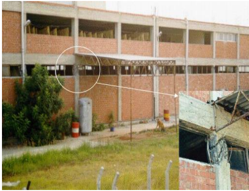
a) Kısa kolon mekanizması
