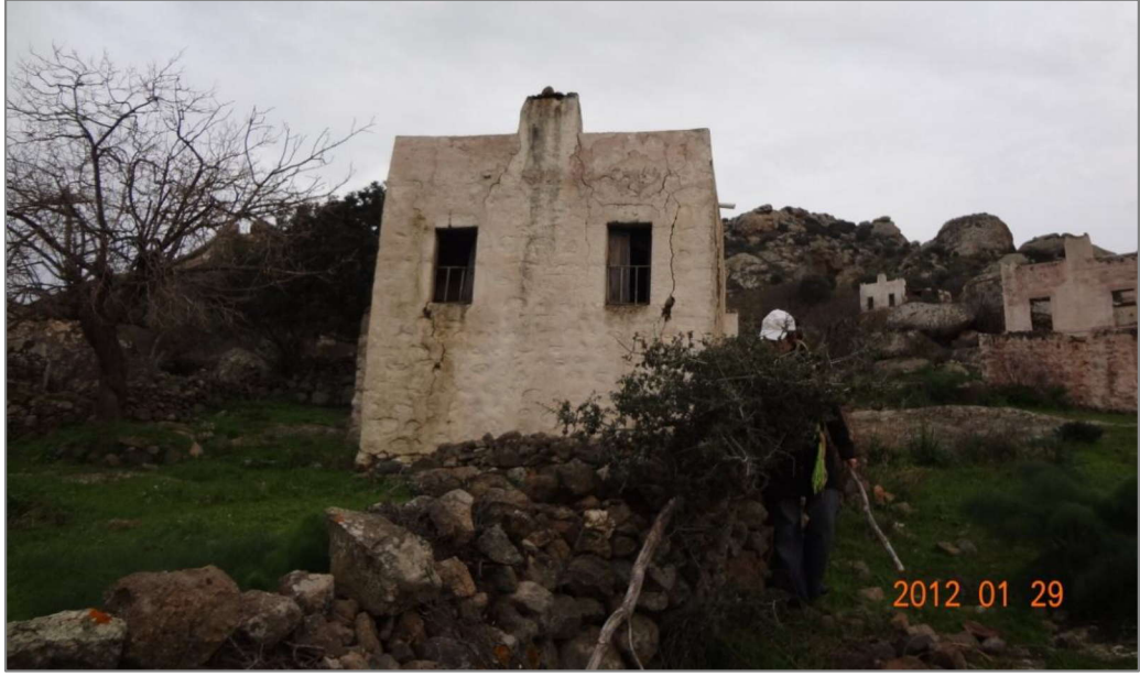
Şekil 3.19 Yerel konut örneği cephe görünümü, demir malzeme kullanımı.
