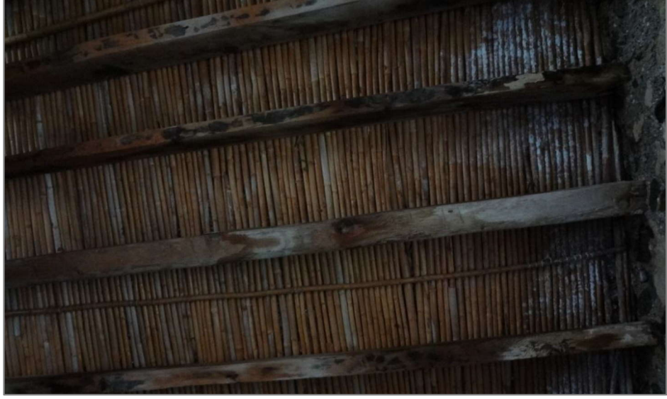
Şekil 3.20 Yerel konut yapısı, çatı iç görünümü, ahşap dilmeler ve kargı döşeme.
