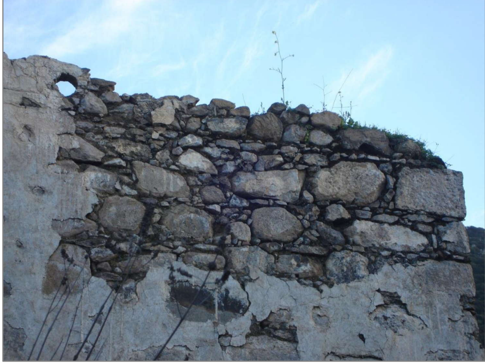
Şekil 3.14 Cephe taş duvar dokusu detayı.
