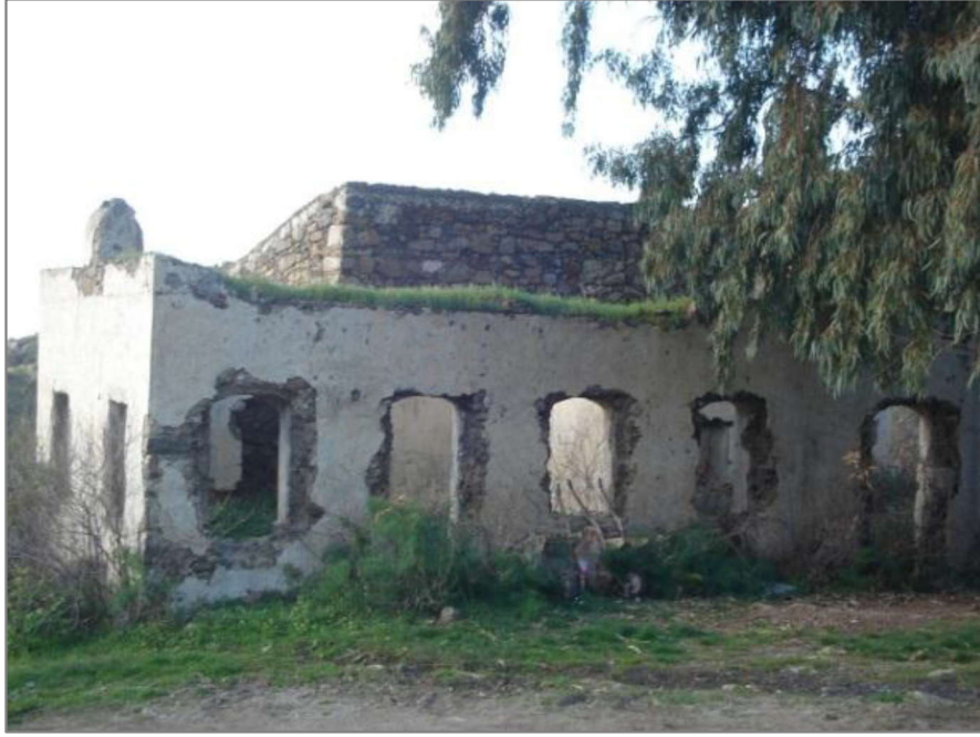
Şekil 3.7 Köy odasının köy meydanından görünümü.
