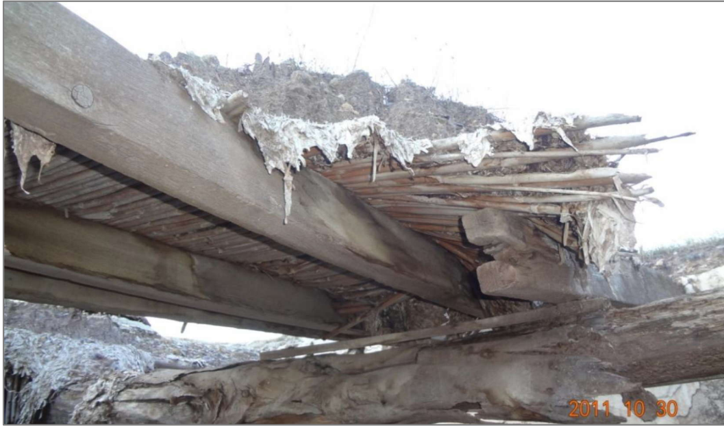
Şekil 3.21 Yerel konut yapısı, çatı kesit görünüşü, sırası ile çatı katmanları: ahşap kütük, ahşap dilme, kargı döşeme, acı çalısı, erişte, kara toprak, geren toprağı.
