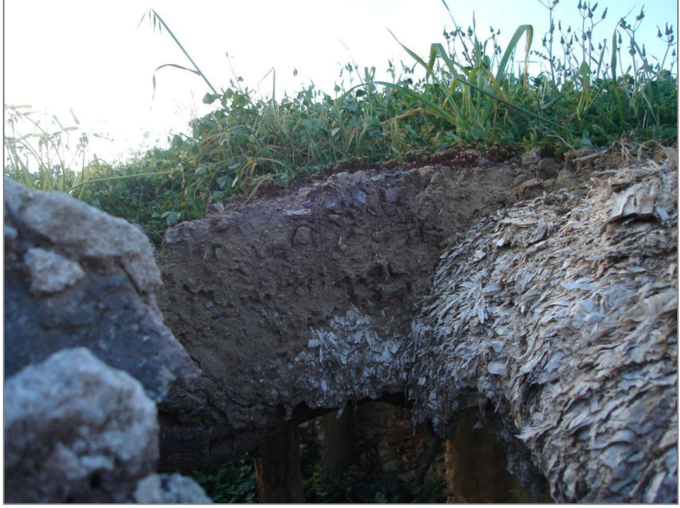
Şekil 3.26 “Çok katmanlı toprak dam” bileşenlerine dair görünüm.
