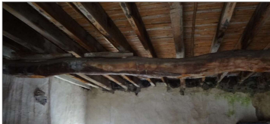
Şekil 3.23 Çatı bileşenlerine dair görünüm (taşıyıcı sistem ve kargı döşeme).
