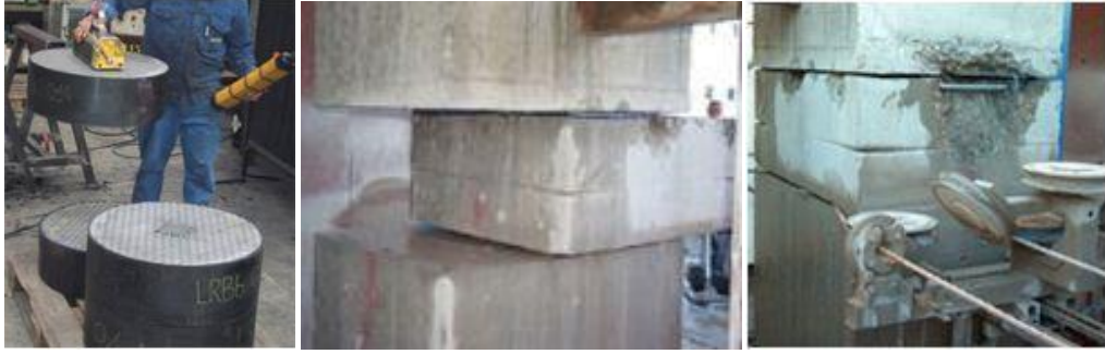
Şekil 1.6. Antalya Havaalanına sismik izolatörün uygulanaşı görölmektedir.
