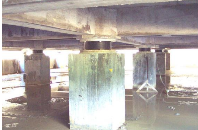
Şekil 2.6 Düşük sönümlü kauçuk izolator
