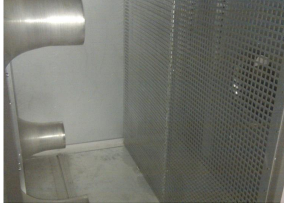
Şekil 5.16 Difüzör plaka yerleşimi
