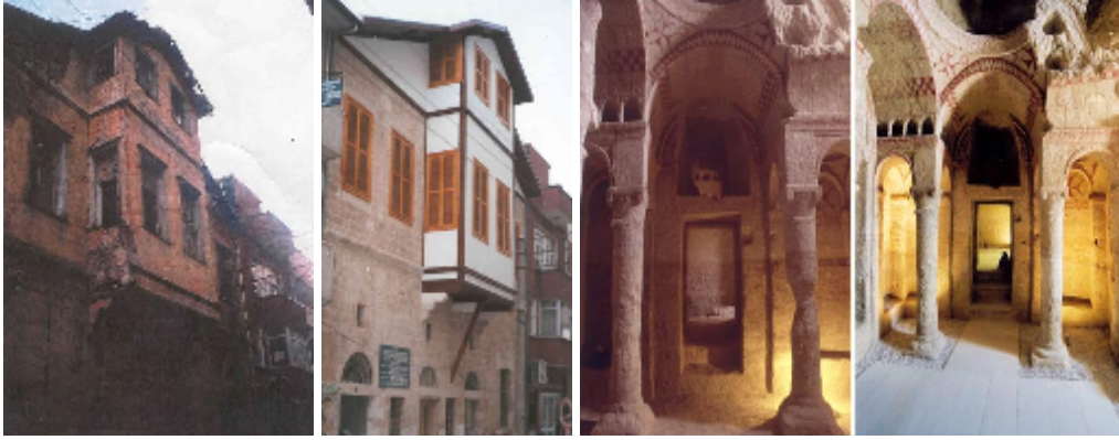
Restorasyon öncesi ve Restorasyon sonrası
