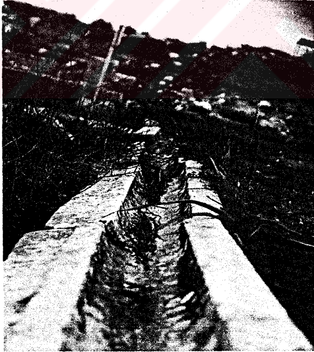
Şekil – 58 Miletos Latrinası temiz su kanalı.
