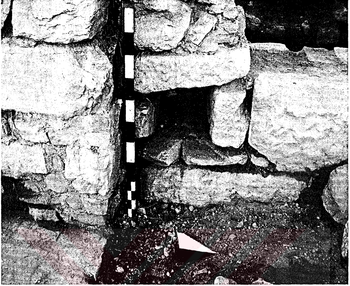
Şekil- 97 Temiz suyun 2. kanal odası kapı girişinin hemen solundan latrinaya girdiği nokta.
