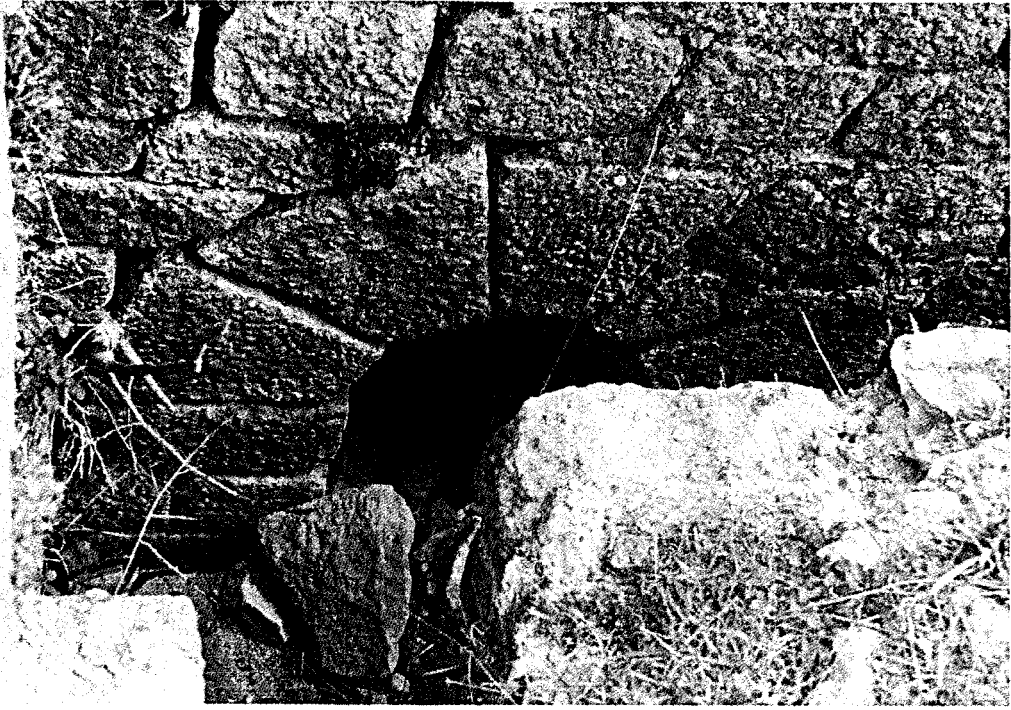
Şekil - 17 Pergamon Erkekler Latrinası atık su kanalı tonozu.
