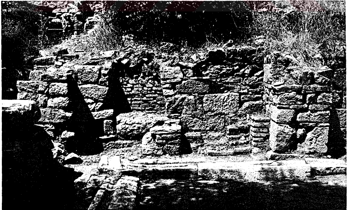
Şekil - 98 Metropolis Latrinası'nın Bizans Döneminde tuğla duvar ile kapatılan 2. kanal odası girişi.
