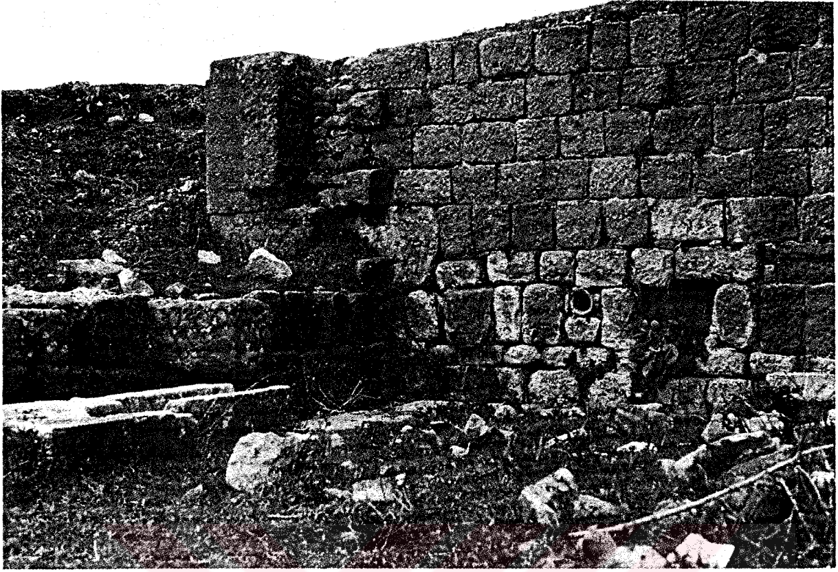
Şek – 69 Pergamon Asklepieion Latrinaları andezit duvar örgüsü.
