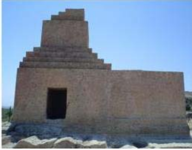
Şekil 54: Phokaia Taş Kule'nin kuzeybatı cephesi.
