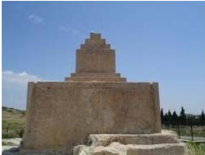
Şekil 59: Phokaia Taş Kule'nin güneybatı cephesi.
