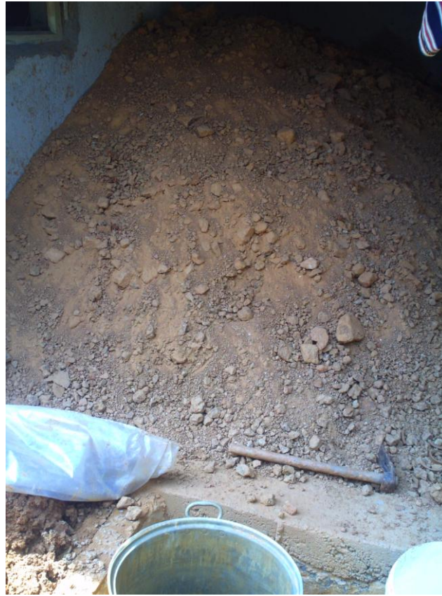
Resim99-Çıkarılan kilin bahçede havalandırılıp kurutulması
