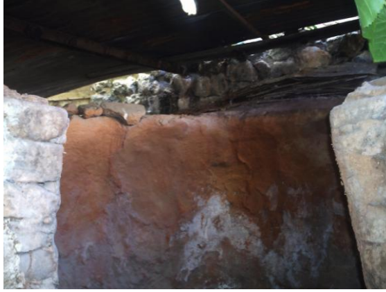
Resim85- Fırının yarım kubbe şeklindeki üst kısmı
