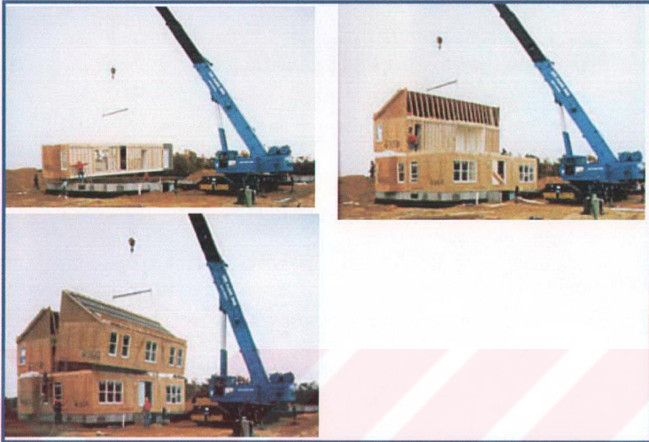
Şekil 3.22 Dört modülden oluşan iki katlı bir konutun montaj evreleri (WEB_11).
