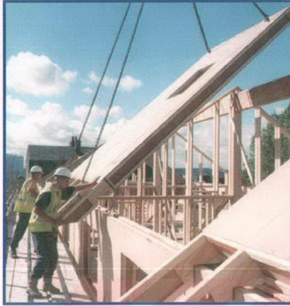
Şekil 3.46 Sandviç paneller ile çatının kurulması ( WEB_15 )
