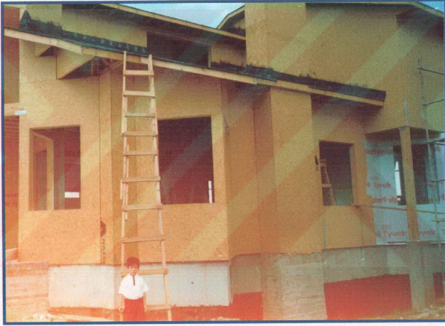
Şekil 2.12 Yönlendirilmiş yonga levha'nın duvar levhası olarak kullanımı (Fotoğraf: Öztank, N. 2003)
