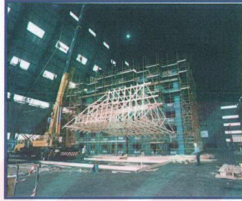
Şekil 3.55 Çatının vinç yardımı ile montajı (Grantham, R., & Enjily, V.2003, s.2)
