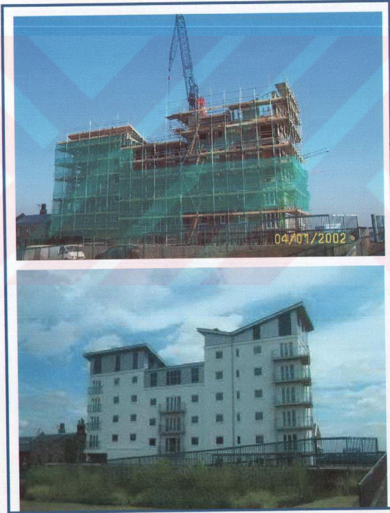
Şekil 3.75 “Ion Apartmanı”, İnşaat aşamasında ve tamamlanmış durumda 6 katlı bina, North Thames bölgesi, Woolwich (WEB_19)
