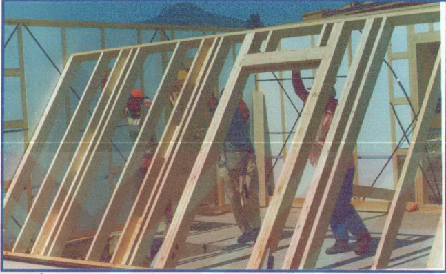
Şekil 3.33 İç duvarların yapı alanında yapılıp yerine kaldırılması (Fotoğraf: Öztank, N. 2003)
