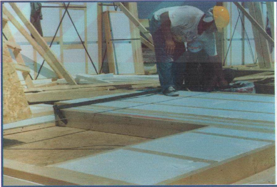
Şekil 3.15 Platform iskelet sisteminin iki küçük panelin yerde birleştirilmesi, Yeşil Vadi Evleri, Afyon (Fotoğraf: Öztank, N. 2003)
