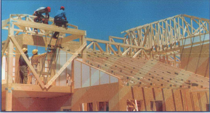
Şekil 3.45 Çatı makasları ile çatının düzenlenmesi (Fotoğraf: Öztank,N. 2003)
