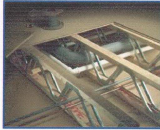
Şekil 3.40 Çelik gövdeli makas kiriş döşeme detayı (WEB_14, 2003)
