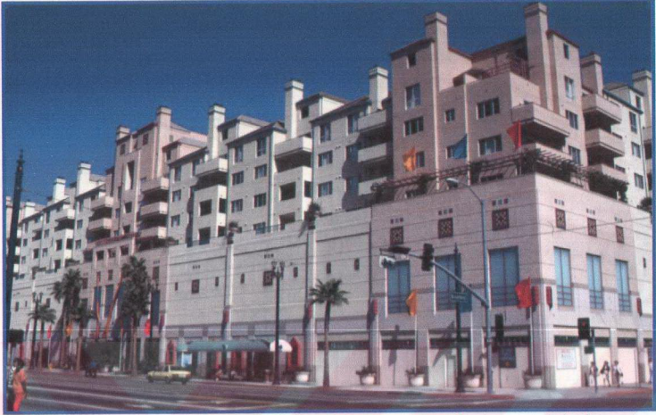
Şekil 3.77 Karma Sistem-Betonarme ve çelik alışveriş merkezi, otopark katları ve ahşap karkas konut katları bitmiş hali. A.B.D. (Erdoğan, E., arşivi U.A.B başkanı)
