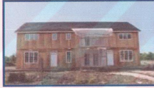
Şekil 3.19 Hücre sistemle üretilmiş ikiz blok konut (WEB_11).
