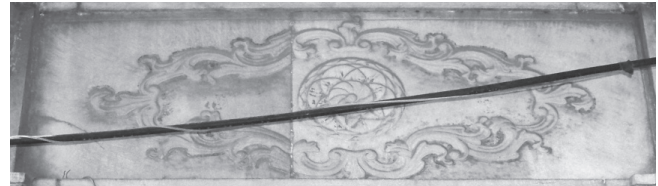
Resim 12 : Beden Duvarlarının üst Bölümünde yer alan Panolar
