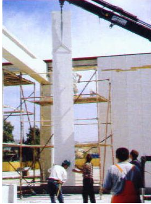
Şekil 4.4 Vinç yardımıyla düşey duvar panellerinin yerleştirilmesi (Gazbeton broşürü).
