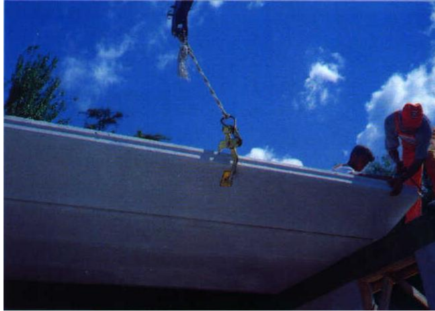
Şekil 4.5 Vinç yardımıyla döşeme panellerinin yerleştirilmesi (Gazbeton broşürü).
