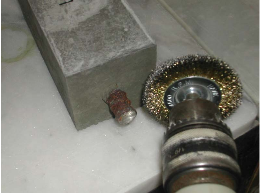
Şekil 6.15 Açıkta kalan donatılardan korozyon ürünlerinin temizlenmesi.
