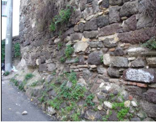
Şekil 5.19 806 ve 803 Sokakların köşesinde, eski bir yapıya ait duvar kalıntısının altında, tonozlu antik bir yapıya ait olabilecek izler bulunmaktadır.
