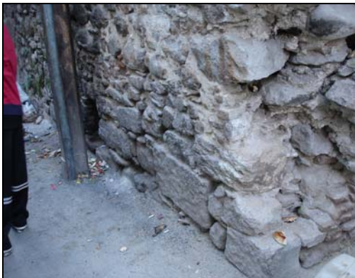
Şekil 5.47 952 Sokakta yer alan 13 numaralı konut ve diğer geleneksel yapılarda, antik yapılara ait blok taşlar devşirme malzeme olarak kullanılmıştır.
