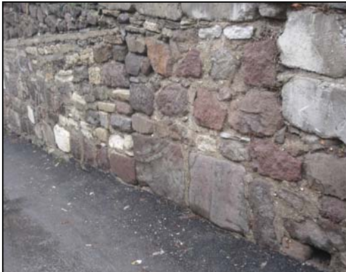
Şekil 5.17 Kuzey-Güney doğrultusunda konumlanan 806 Sokakta, eski bir yapıya ait duvar kalıntısında antik taş bloklar bulunmaktadır.
