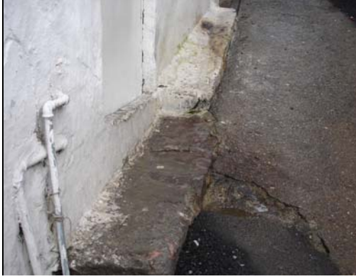
Şekil 5.13 Kuzey-Güney doğrultusunda konumlanan 819 Sokakta 25 numaralı evin dış duvarında yer alan antik taş bloklar, sokak boyunca devam etmektedir.
