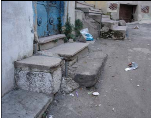
Şekil 5.39 Kuzey-Güney doğrultusunda konumlanan 951 Sokakta 7 numaralı evin giriş merdiveninin altında yer alan antik blok taşlar sokak boyunca görülmektedir.
