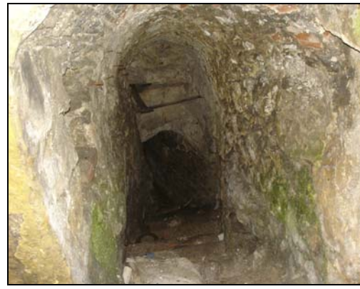
Şekil 5.10 821 Sokakta yer alan 23 numaralı evin altında, evin bahçesinden girilen içi su dolu tonozlu bir su sarnıcı konumlanmaktadır.
