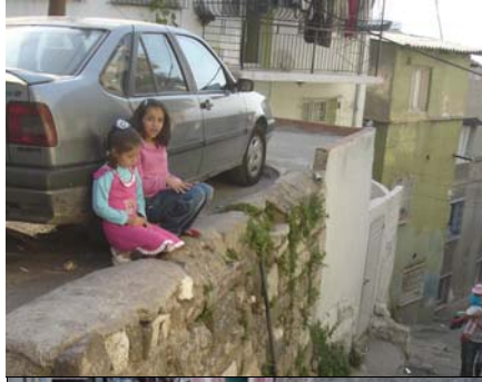
Şekil A.10 Sur Duvarı
