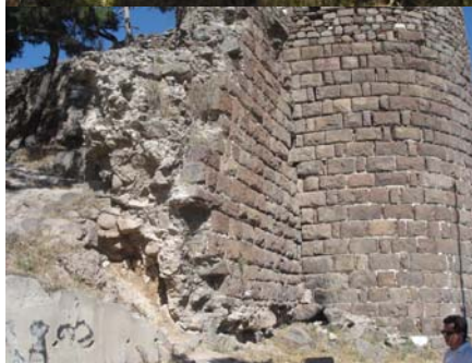
Şekil A.14 Sur Duvarı
