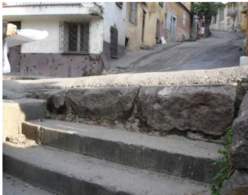
Şekil 5.53 806 ve 812 Sokakların köşesinde konumlanan antik taş bloklar yolun altında devam etmektedir.
