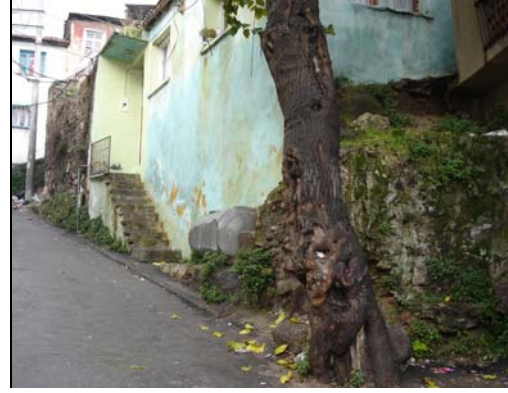
Şekil 5.20 806 ve 803 Sokakların diğer köşesinde, antik bir su yapısına ait olabilecek kalıntılar bulunmaktadır.
