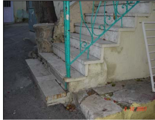
Şekil 5.46 948 Sokakta yer alan Pazaryeri Camii'nin giriş merdiveninin altında, antik bir yapıya ait olduğu düşünülen taş bloklar konumlanmaktadır.
