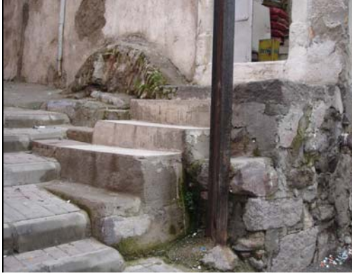
Şekil 5.55 811 Sokakta 35 numaralı evin altında, antik bir yapıya ait olabileceği düşünülen blok taşlar ve kemer kalıntısı bulunmaktadır.
