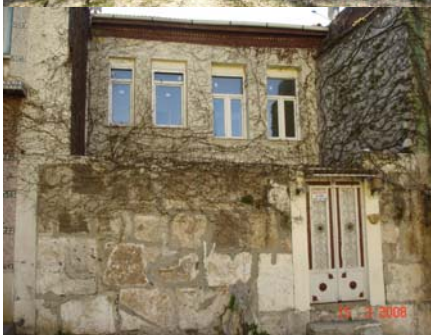
Şekil A.8 Sur Duvarı
