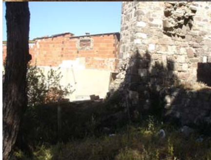
Şekil A.13 Sur Duvarı
