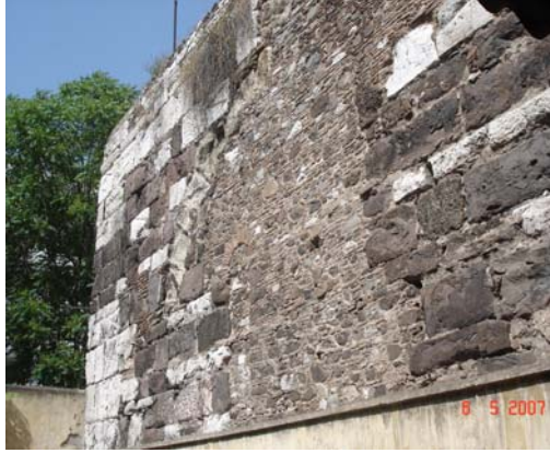
Şekil 5.7 939 Sokakta konumlanan Saray Sineması'nın arkasında, Roma Dönemine ait olduğu tahmin edilen antik bir yapı kalıntısına ilişkin duvar parçaları, yeni yapılar arasında sıkışmış durumdadır.
