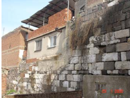
Şekil A.12 Sur Duvarı
