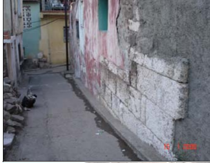
Şekil A.11 Sur Duvarı
