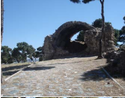
Şekil A.6 Şapel yapısı
