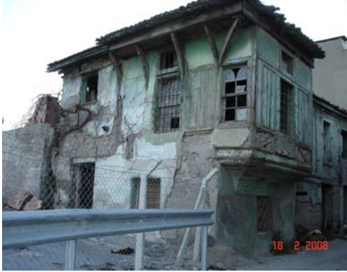
Şekil. 5.69 Agora 1. derece arkeolojik sit alanı içinde konumlanan, 61/385 ada, 90 parsel üzerinde yer alan, tescilli geleneksel mimarlık örneği yapıdan bir görünüm.
