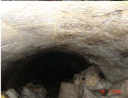
Şekil A.24 Tiyatro'ya ait tonozlu altyapı galerisi
