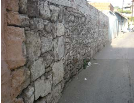
Şekil A.9 Sur Duvarı
