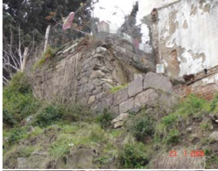
Şekil A.15 Sur Duvarı
