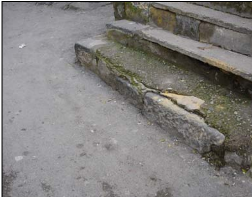
Şekil 5.23 972 Sokağın doğu-batı doğrultusunda konumlanan kısmında, 10 numaralı evin giriş merdiveni altında konumlanan döşeme kalıntısı sokak boyunca görülmektedir.
