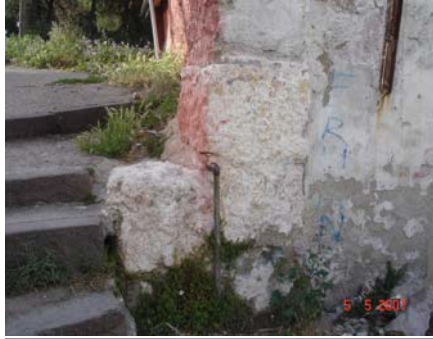
Şekil A.16 Sur Duvarı
