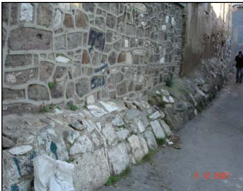
Şekil 5.41 951 Sokakta yer alan Emir Sultan Türbesi'nin etrafındaki bahçe duvarının kuzey-güney doğrultusunda konumlanan kısmının altında, tonozlu bir antik yapıya ait olabilecek mimari parçalar bulunmaktadır.
