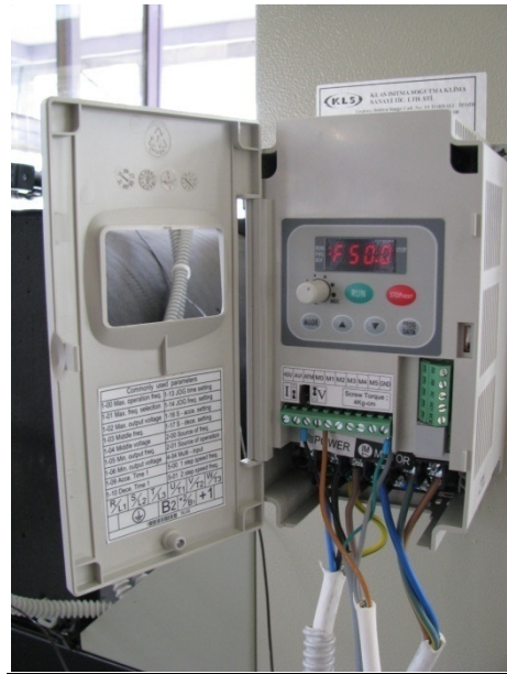
Şekil 6.12 Kullanılan PWM invertör
