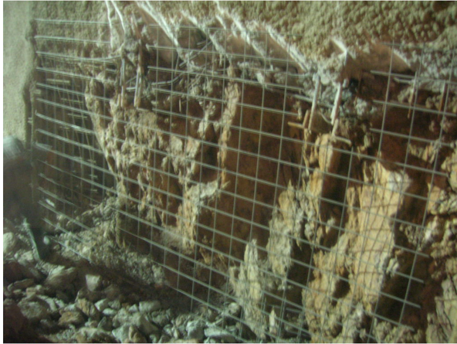
Şekil 4.28 Kademe kazısında çelik hasırın yerleştirilmesi
