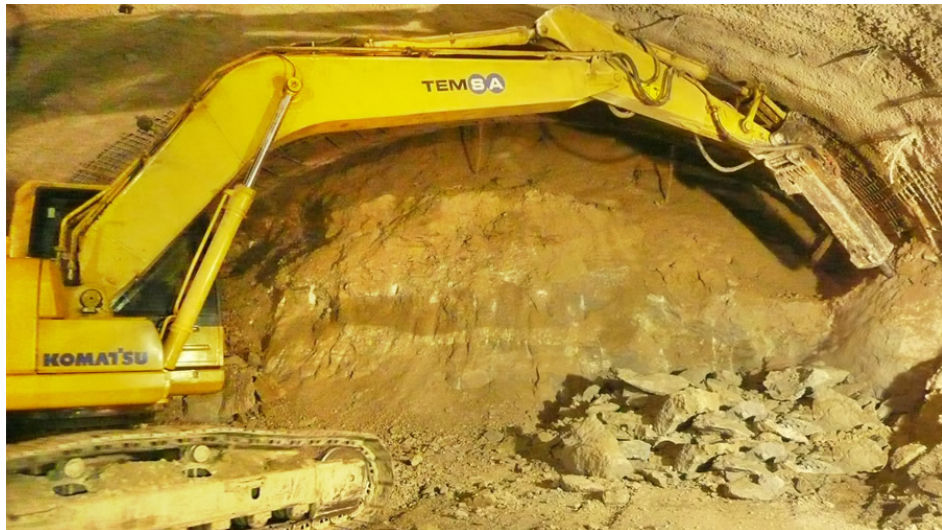
Şekil 4.27 Tünel kazılarında kullanılan darbeli kırıcı
