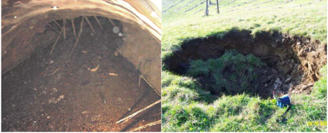
Şekil 3.6 Trojane Tünel' in de ayna akması ve buna bağlı yüzeyde oluşan çökmeler. (Slovenya)
