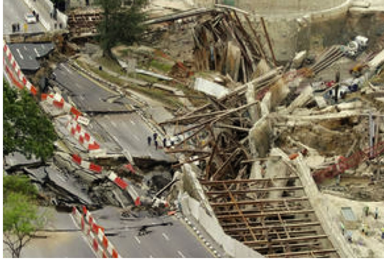
Şekil 3.2 Yer altı hattı shaft yakınında karşılaşılan durum (Singapur)
