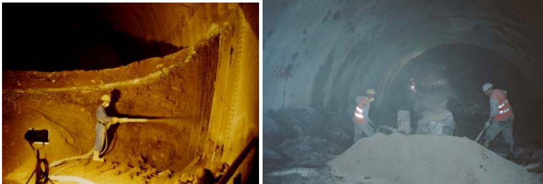
Şekil 3.12 Yaş ve Kuru Püskürtme Beton Uygulaması
