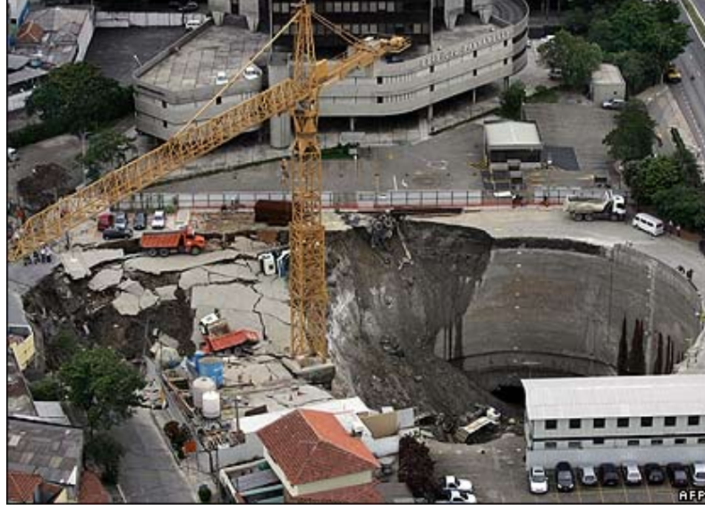
Şekil 3.5 Sao Paulo otoyol tüneli inşası sırasında şaft ve tünel eksenini boyunca karşılaşılan durum (Brezilya)
