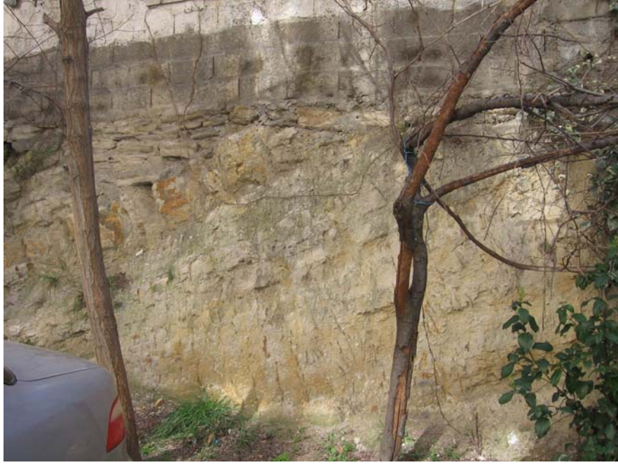
Şekil 4.18 Altındağ Formasyonu'nun temel kazı alanında görünümü (MTA, 2005).
