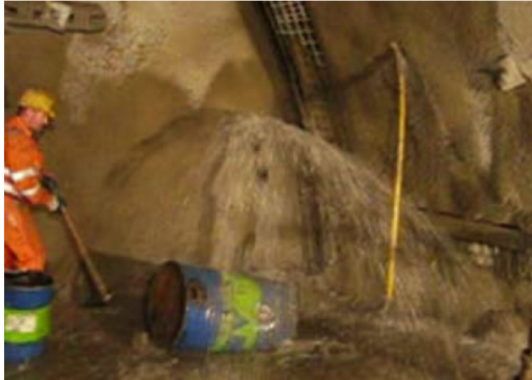
Şekil 3.4 Wienerwald demir yolu tüneline inşası sırasında karşılaşılan durum (Avusturya)
