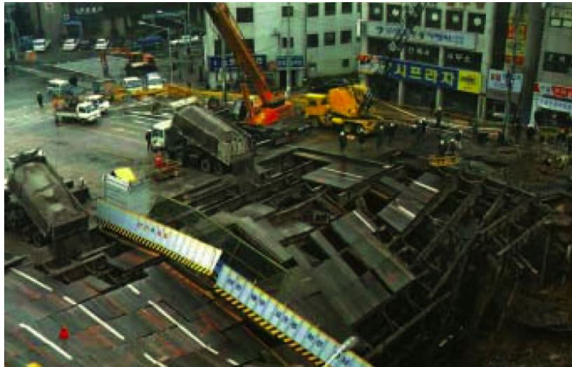
Şekil 3.1 Yer altı hattı, istasyon kazısında karşılaşılan durum (Güney Kore)
