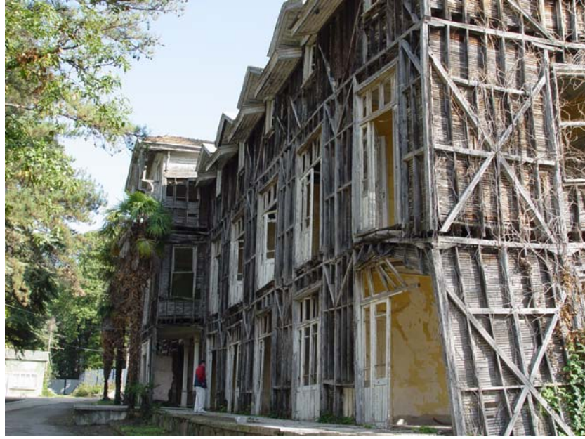
Şekil 4.36 Büyük Otel, yıkılmadan önceki görünümü
