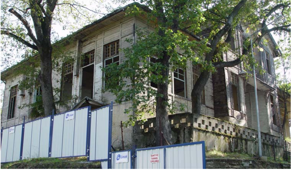
Şekil 4.38 Büyük Gazino, yıkılmadan önceki görünümü
