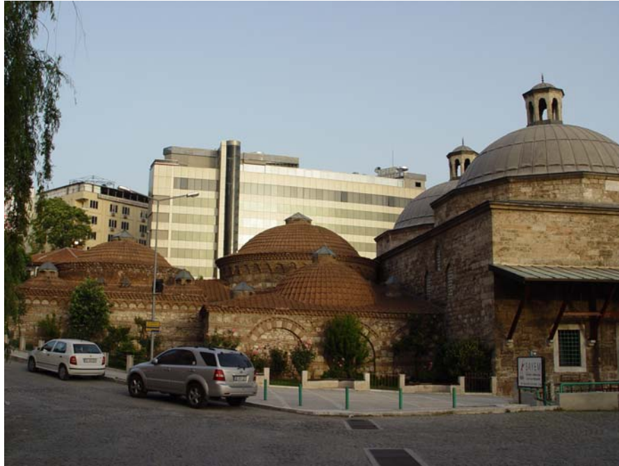
Şekil 3.66 Eski Kaplıca, güneydoğu yönünden görünüm
