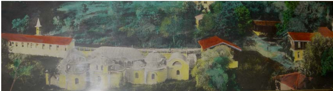
Şekil 4.52 Yalova Kaplıcaları'nın 1900 yıllarındaki genel görünümü (Çamlık Otel arşivinden alınmıştır, Kasım 2008)
