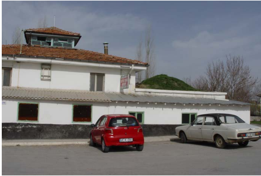
Şekil 3.55 Kütahya- Yoncalı Kaplıcası, güney cephesinden görünüm
