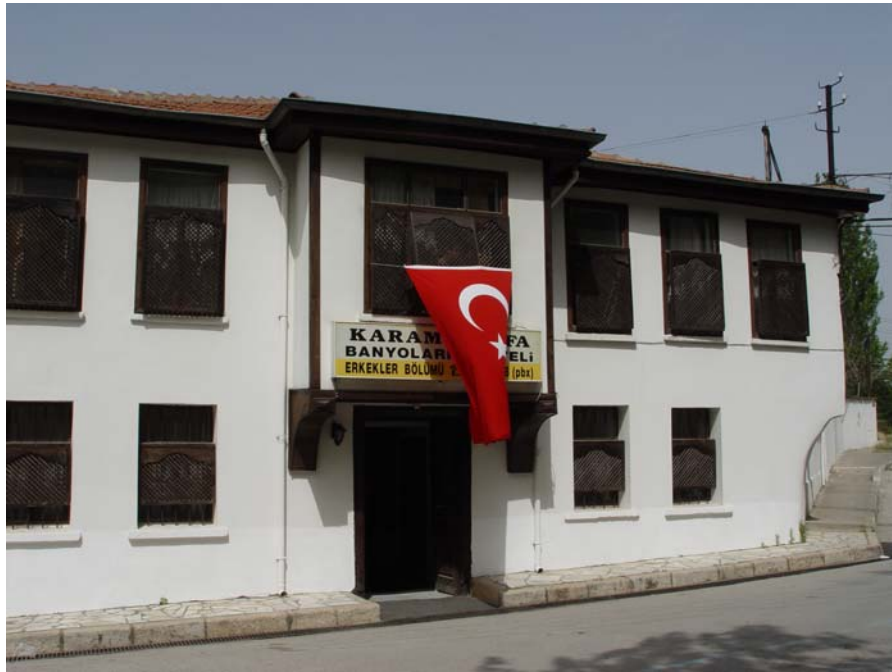
Şekil 3.73 Kara Mustafa Kaplıcası, soyunmalık bölümünün yol cephesinden görünümü
