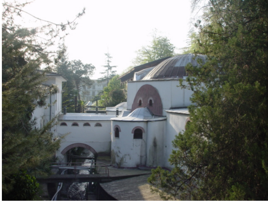
Şekil 4.18 Valide Banyo, batı yönünden görünüş
