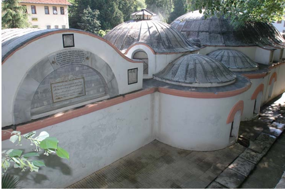
Şekil 4.16 Kurşunlu Banyo, çatı örtüsü
