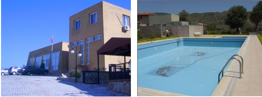
Şekil 5.136 Sosyal tesis binası ve havuzdan görünüm (tanıtım CD'si, 2009; kişsel arşiv, 20.12.2009 )
