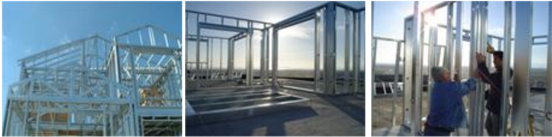
Şekil 5.40 Hafif çelik konstrüksiyon sistem uygulama safhası ( http://www.yamacevler.com )
