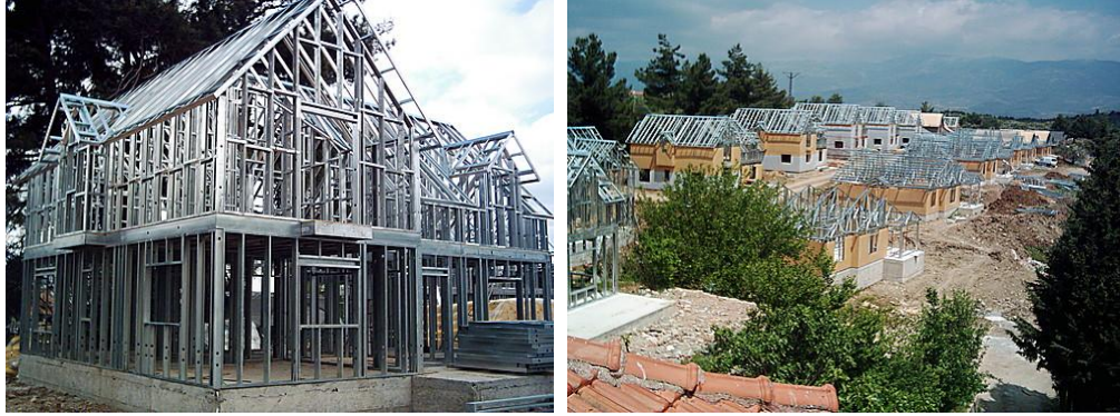
Şekil 5.29 Hafif çelik konstrüksiyon sistem uygulama safhası ( http://www.milliyetemlak.com/century , 2008)
