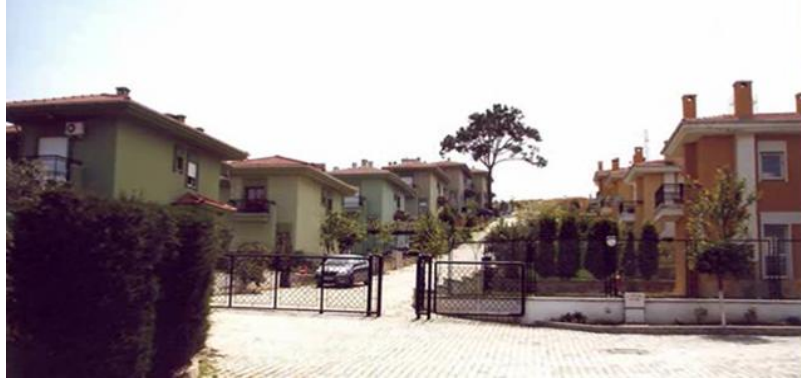
Şekil 5.137 Site girişi (tanıtım CD'si, 2009)
