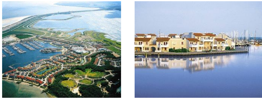
Şekil 2.33. Port Zelande, Hollanda ( http://gedachtengolven.blogspot.com ; http://www.eenoudervakantiegids.nl )
