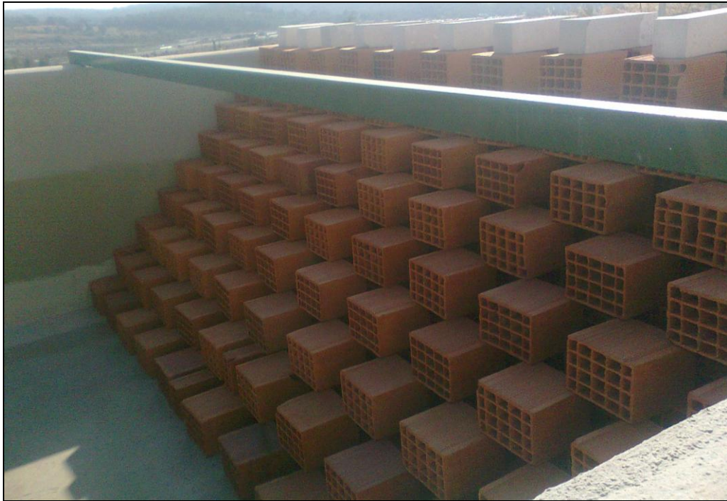
Şekil 4.5 Dalga kanalı sahilinde yer alan dalga sönümleme sisteminin genel görünüşü.
