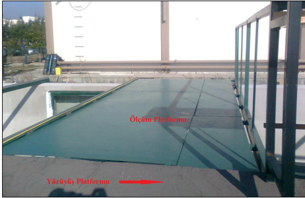
Şekil 4.6 Yürüyüş platformu ve ölçüm platformunun genel görünüşü.
