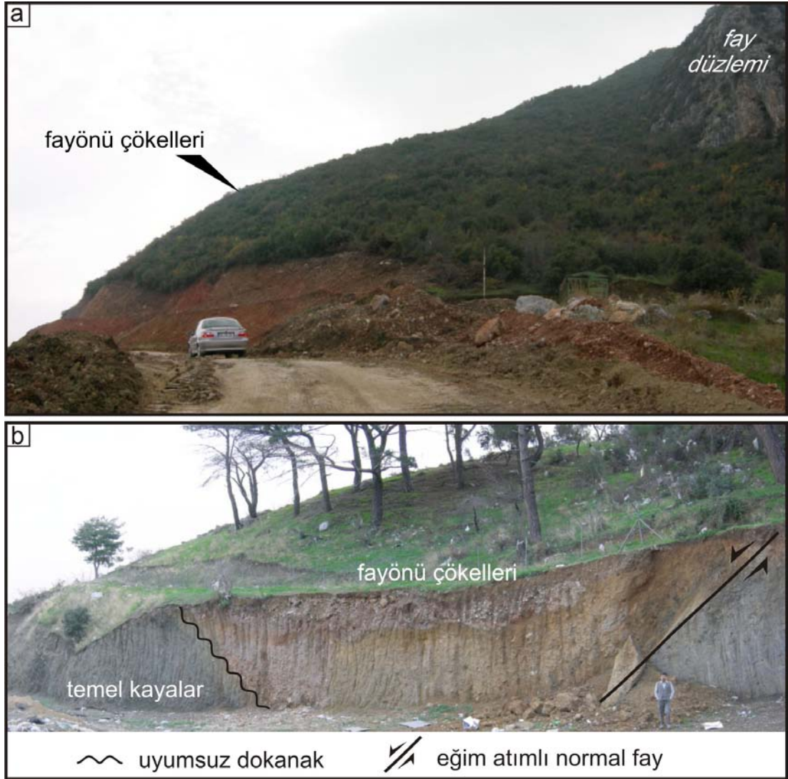
Şekil 4.17 (a) Manisa Fay Zonu merkez bölümünde gözlenen dağ önündeki ana fay düzlemi ve fay önü çökelleri, (b) bu bölümde gözlenen fay önü çökellerini ve temel kayaları kesen eğim atımlı normal fay. Temel kayalar, Bornova Fliş Zonu'na ait kumtaşı-şeyl ardalanması ile temsil edilmektedir.
