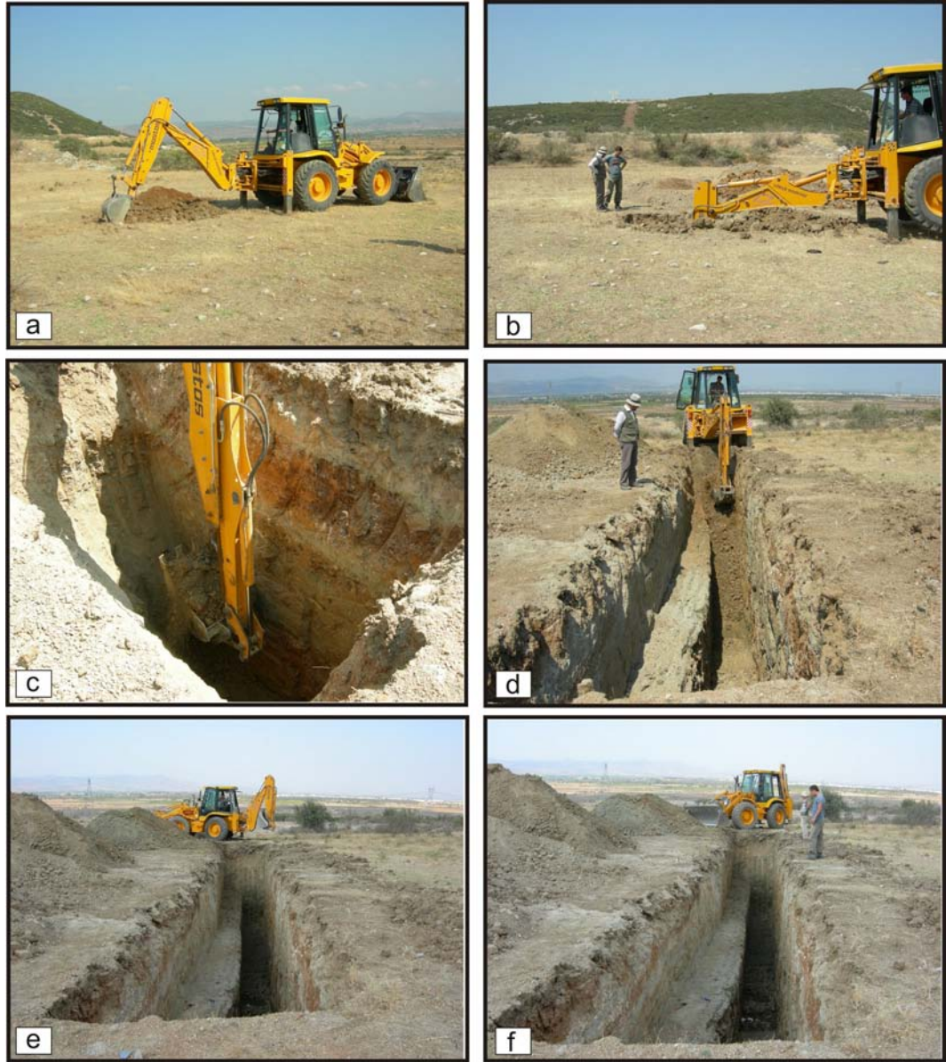
Şekil 1.10 Mugirtepe fayı üzerinde yapılan 1 numaralı hendeğin açılması çalışmaları. a-f) kronolojik sıraya göre hendeğin açılma evrelerini gösteren arazi fotoğrafları.
