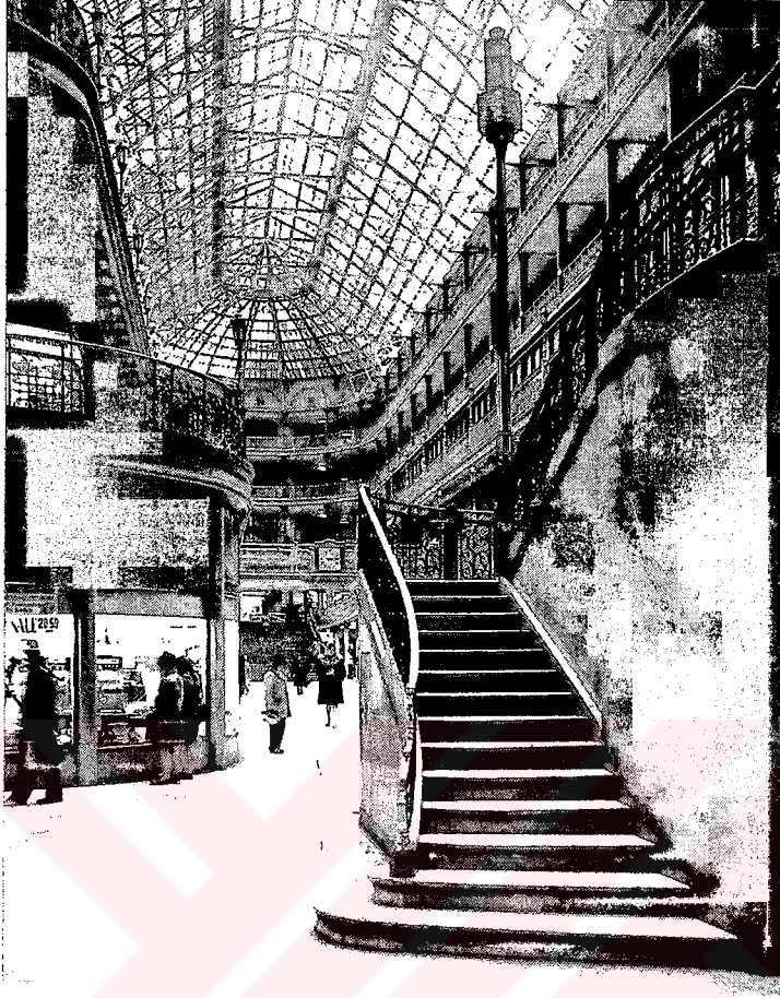
Şekil 2.13 Cleveland Arcade, iç mekan. (Bednar, 1986, s.9)
