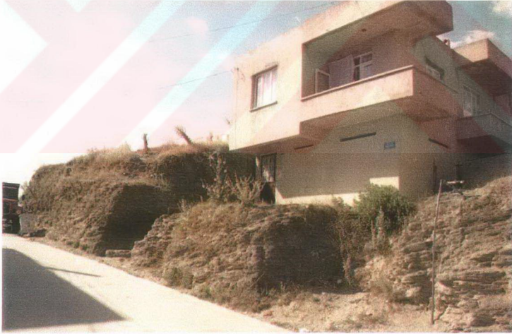
Şekil 6.12 : Selçuk ilçesi yerleşim alanında kaya zemine oturtulmuş yapı.
