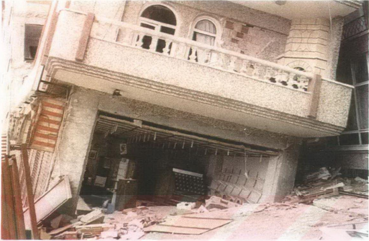
Şekil 6.16 : 17 Ağustos 1999 İzmit Körfezi depreminde sivilaşma sonucu zemine gömülmüş bina (Demirtaş ve Erkmen, 2000).
