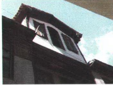
Resim 3.40. Çatı odası cephe düzeni.
