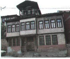
Resim 3.32. Kastamonu Çatlakkapı Sokak No: 19.
