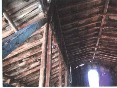
Resim 3.39. Çatı odası ve ana çatıda kullanılan ahşaplar.
