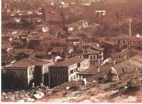
Resim 3.42. Zencirlioğlu Konağı eski fotoğrafı.
