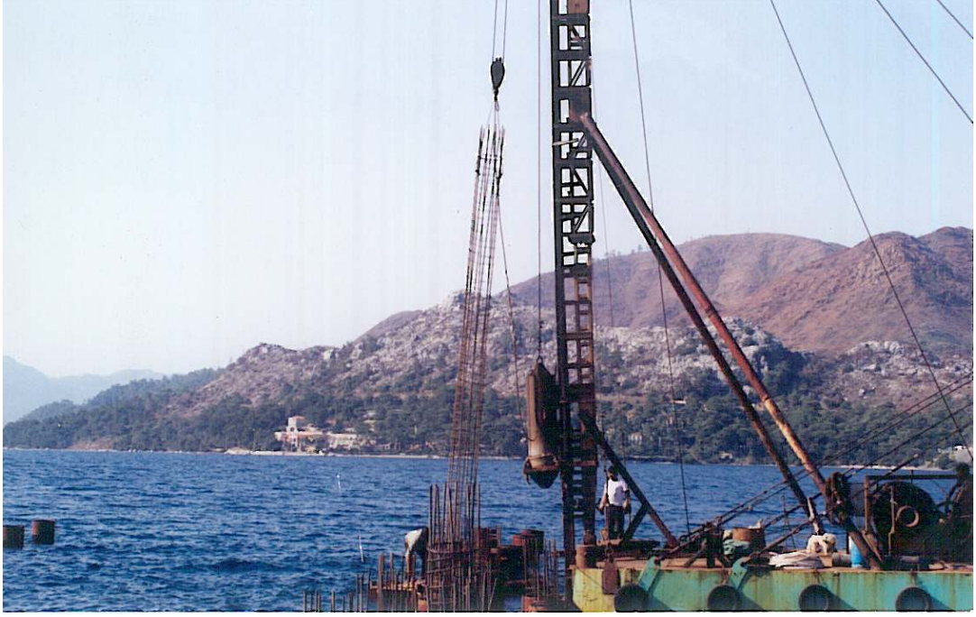
Şekil 4.5 Betonarme ayak inşaatında kalıp inşaatı
