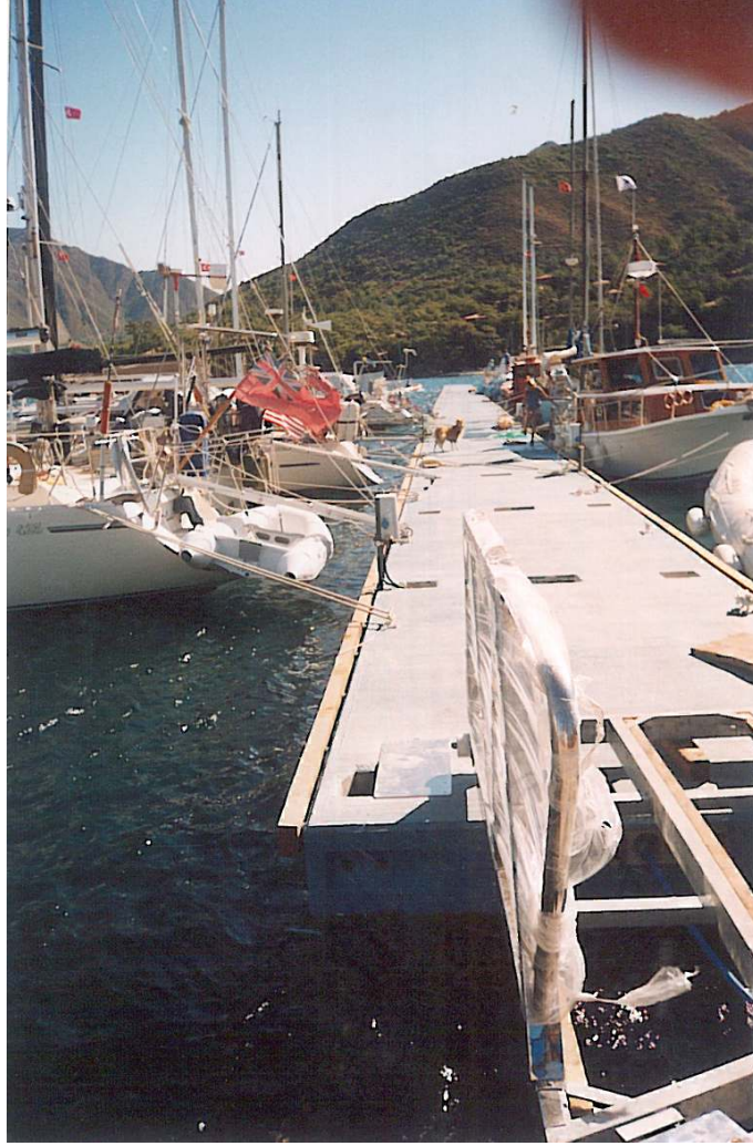
Şekil 4.8 Yüzer iskeleden bir görünüşü.
