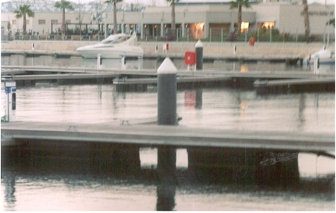
Şekil 4.9 Yüzer iskele sistemlerinde iskele bağlama sütunları.
