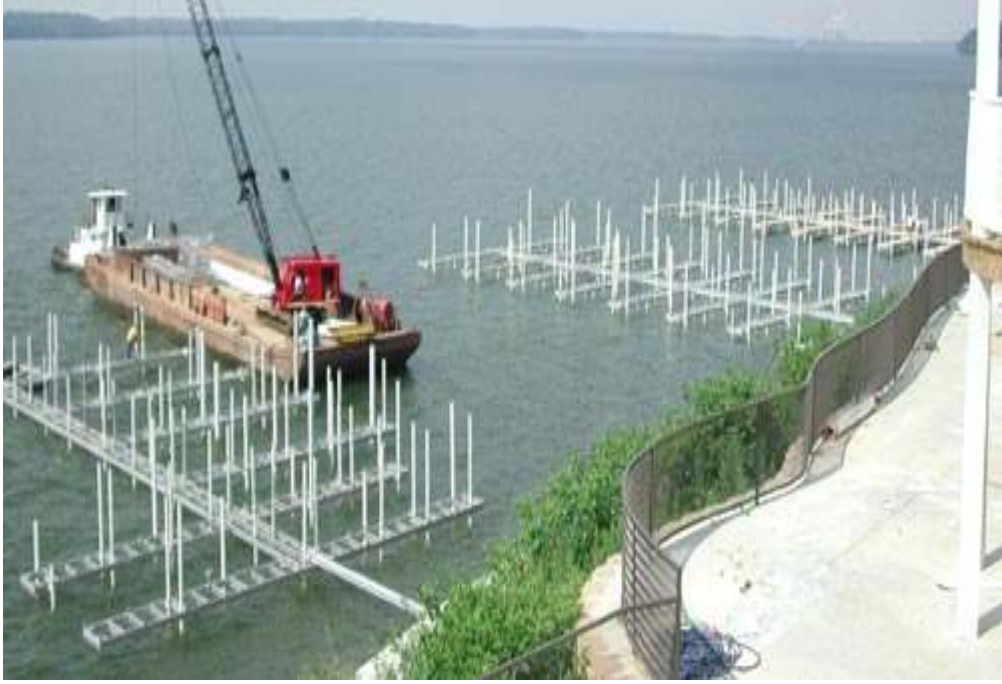
Şekil 5.1 Alüminyum iskele sistemlerinin inşaat aşaması.
