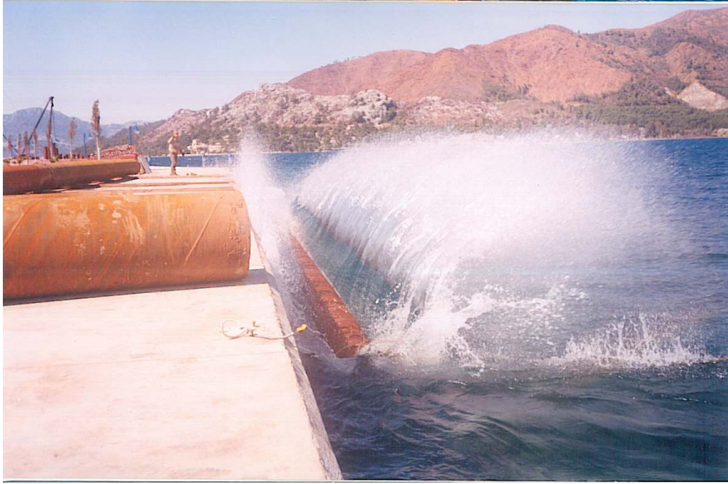
Şekil 4.6 Beton İskele ayağı olan çelik kalıbın suyu indirilişi.
