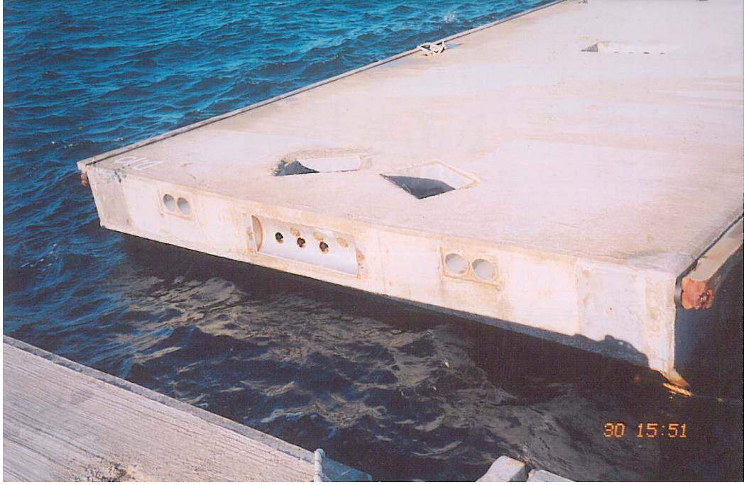
Şekil 4.11 Betonarme yüzer iskele sistemlerinde iskele birleşim bölgesi.
