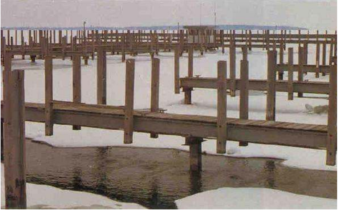
Şekil 4.2 Ahşap sabit iskele
