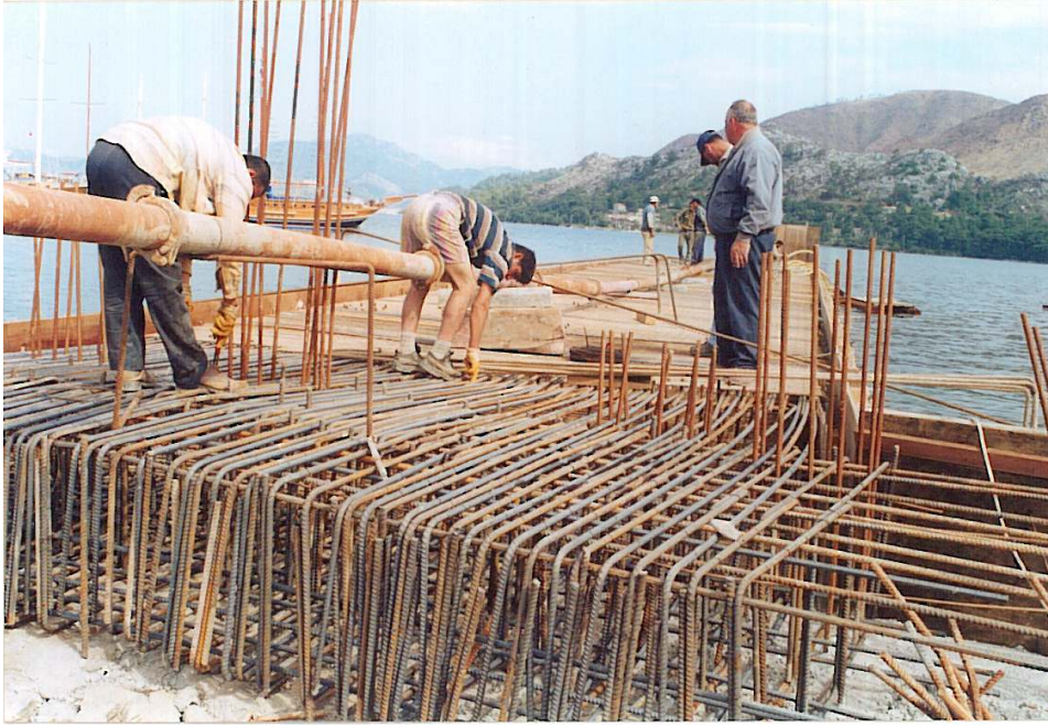
Şekil 4.3 Sabit iskelede iskele donatısını yerleştirilmesi
