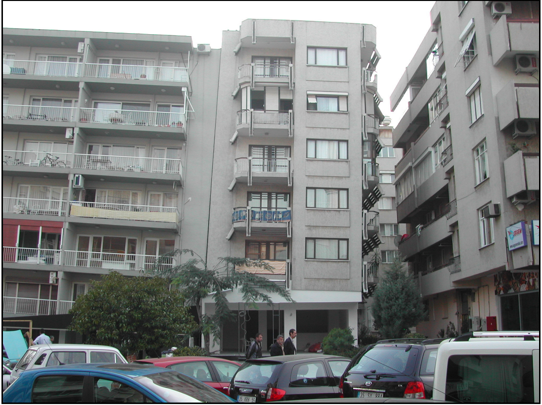
Şekil 7.12 Bostanlı (İzmir) mahallesinde binalarda gözlenen oturma tipi deformasyon.
