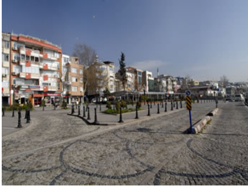
Şekil 5.3 Fıstıklı graniti ile küp taş yol döşemesi
