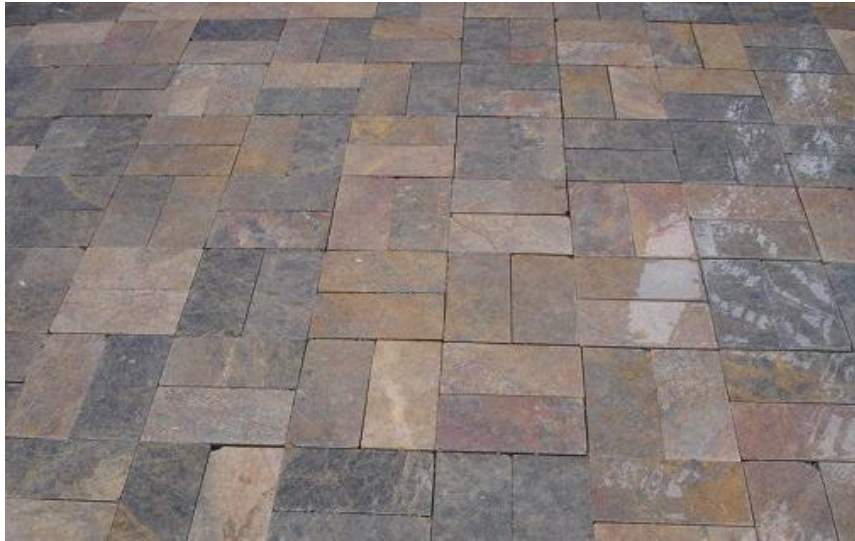
Şekil 5.12 Farklı yüzey işlemleri kullanılan Demirtaş Diyabazı ile yer döşemesi
