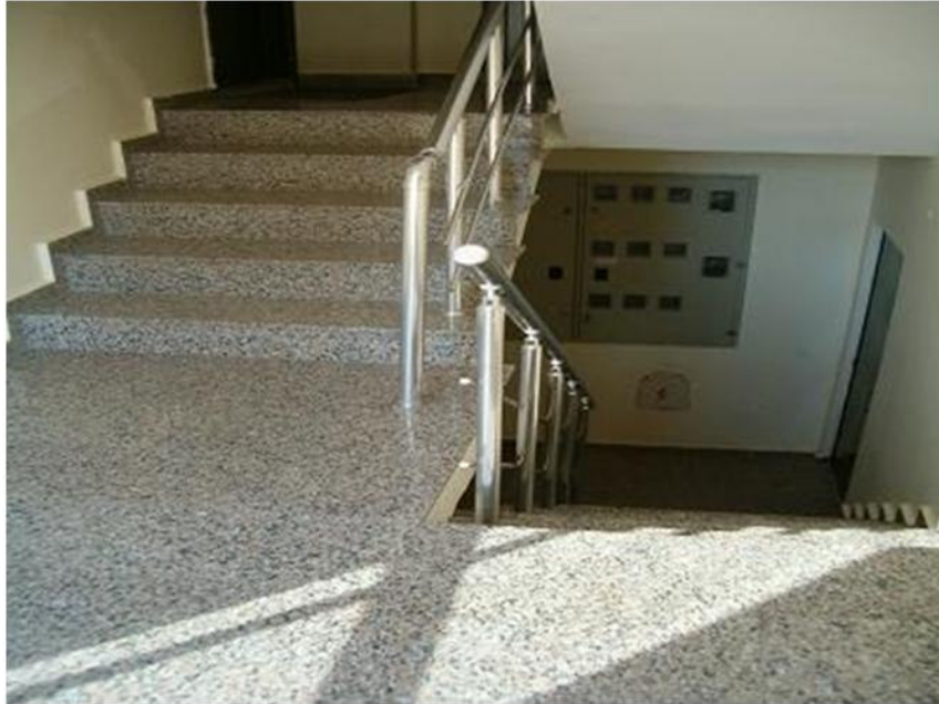
řekil 5.2 Granit ile merdiven dřemesi
