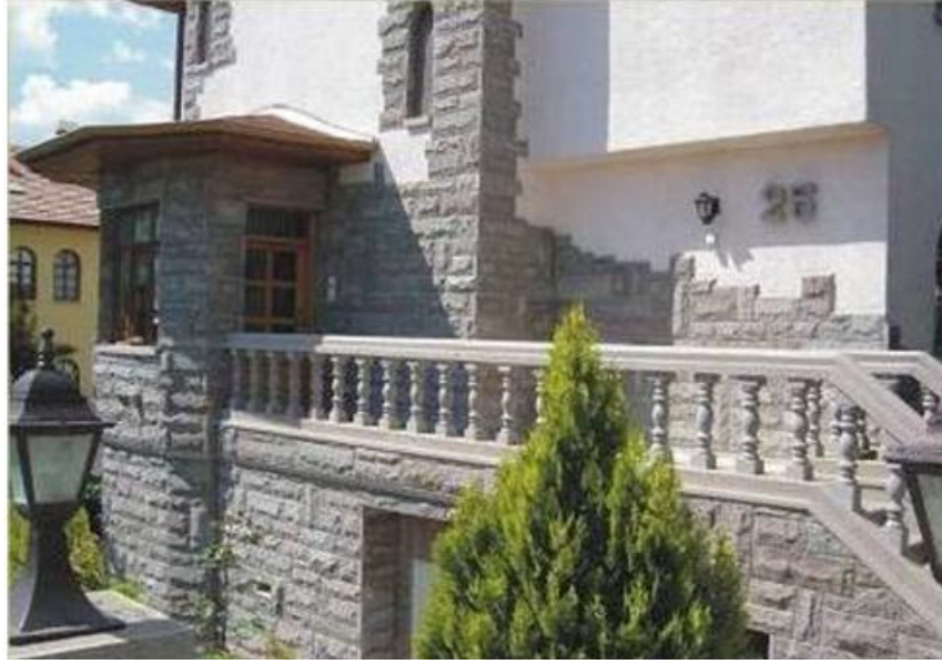
Şekil 5.5 Andezit ile yapılmış dış cephe kaplaması
