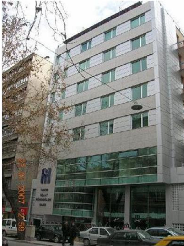
Şekil 5.4 Granit dış cephe kaplaması
