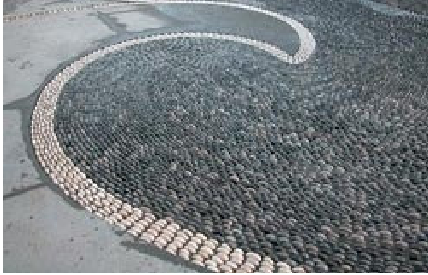
Şekil 5.9 Farklı şekillerde işlenmiş bazaltlar ile zemin uygulaması
