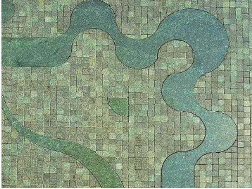
Şekil 5.11 Demirtaş Diyabazı ile yapılan dekoratif yer döşemesi
