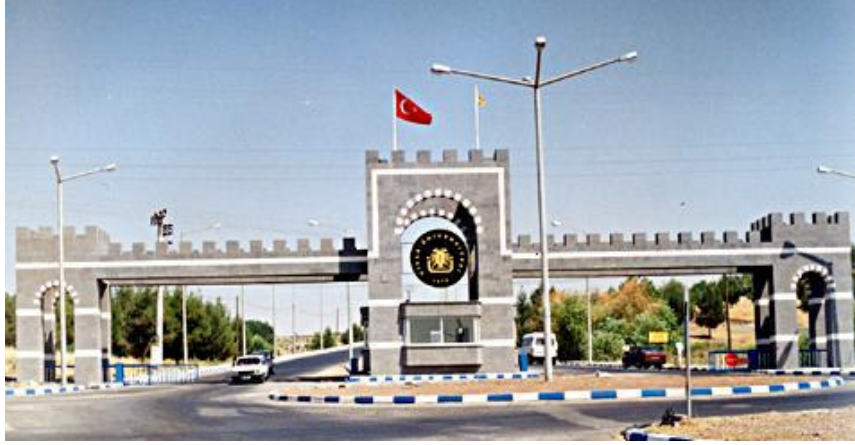
Şekil 5.8 Diyarbakır Bazaltı ile kaplanan Dicle Üniversitesi giriş kapısı
