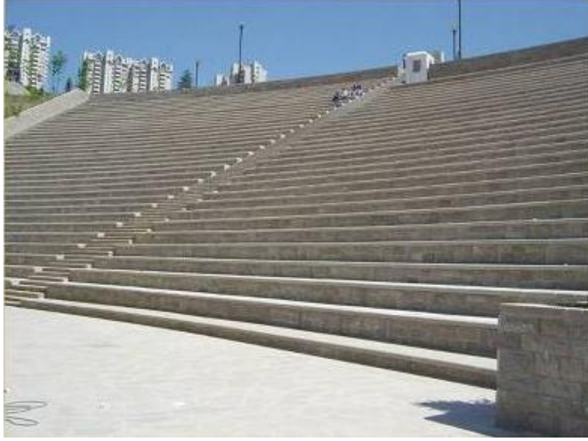
Şekil 5.7 Gölbaşı andezit ile zemin ve merdiven döşemesi
