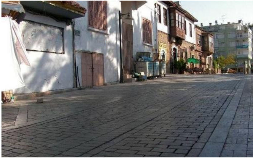
Şekil 5.10 Demirtaş Diyarbazı ile yol döşemesi
