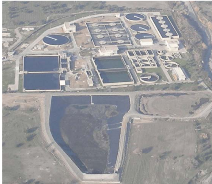
Şekil 5.12 Atık su arıtma tesisinin genel görünümü.
