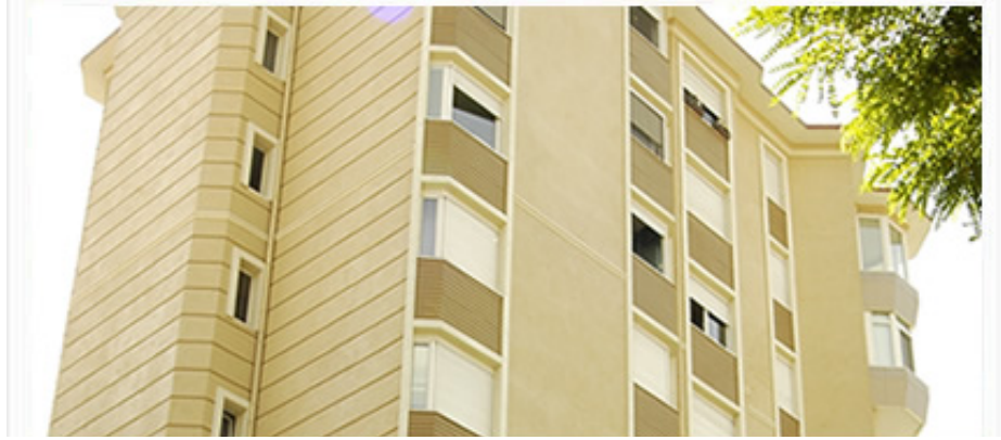
Şekil 3.65 Gül apartmanı Suadiye - İstanbul (Paksiding, 2008).
