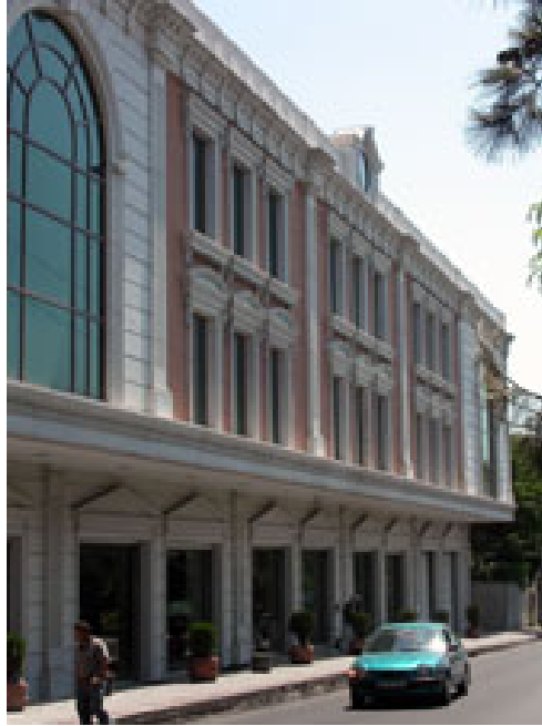
Şekil 3.48 Emelda Alış-veriş Merkezi-Zeytinburnu-İstanbul (Refsan Prekast 2008).
