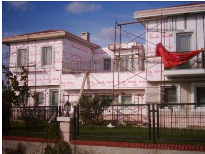
Şekil 3.64 Vinil siding uygulanmış konut (Paksiding, 2008).
