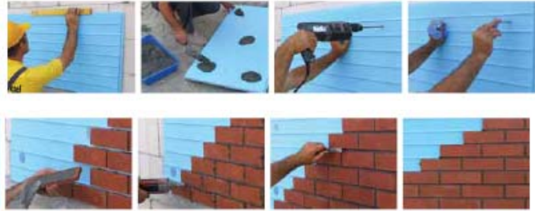
Şekil 3.100 Tuğla cephe kaplaması uygulama aşamaları (Harun yüksel, 2008).
