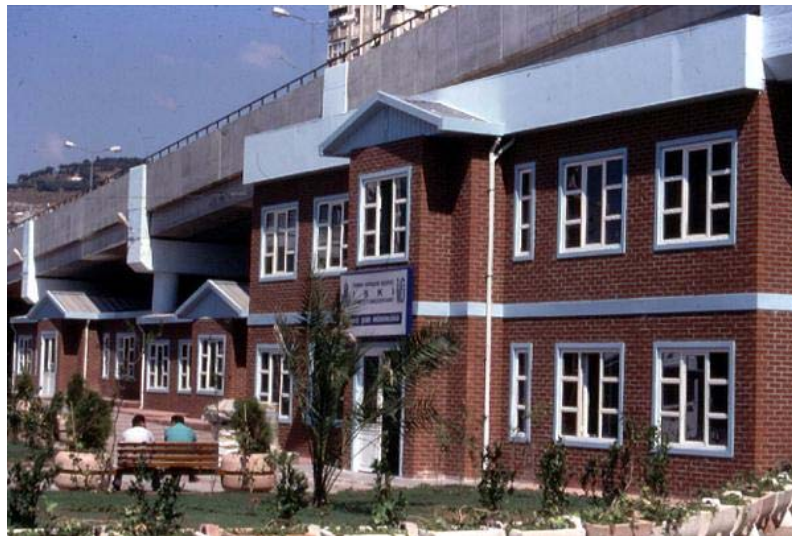
Şekil 3.103 İski Binası, İstanbul (www.isiklartugla.com.tr).
