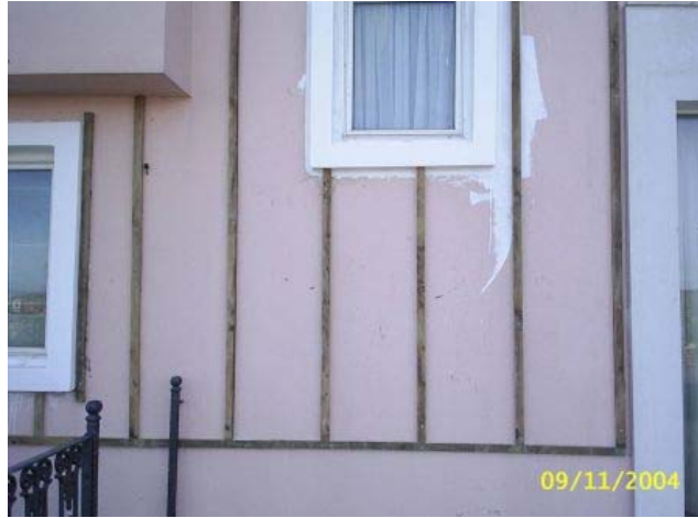
Şekil 3.63 Vinil siding cephe kaplaması uygulaması (Paksiding, 2008).
