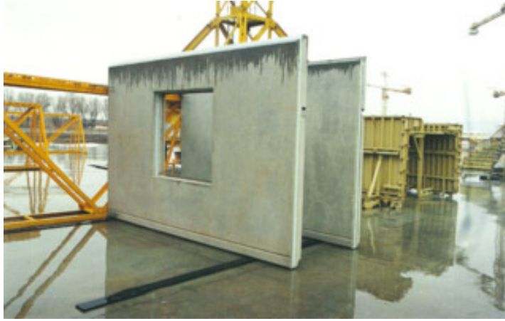
Şekil 3.26 Betonarme panel taşınması (Fibrobeton, 2007).
