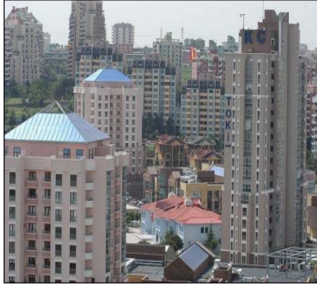
Şekil 5.22 Şehr-i Bahçe görünüm
