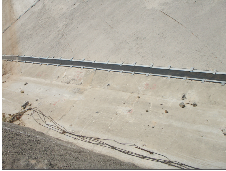
Şekil 7.10 Anolar arasındaki kauçuk contaların görünümü
