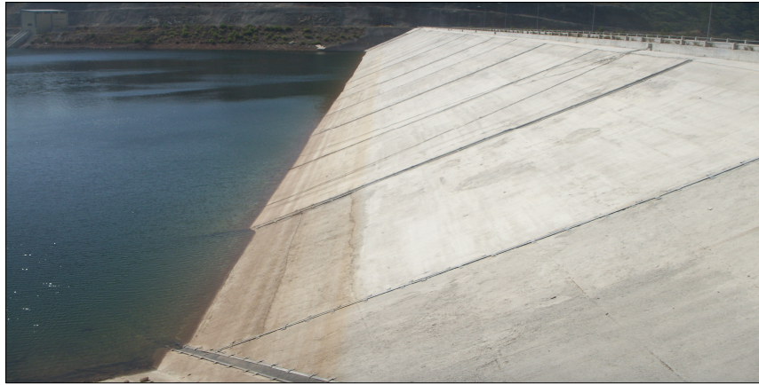
Şekil 7.16 Kaplama betonunun bugünkü hali, su kotu +50 metre
