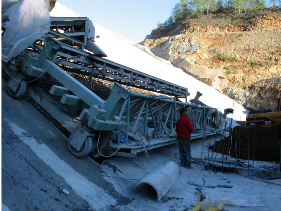
Şekil 7.9 Beton kaplama işleminde kullanılan finişer
