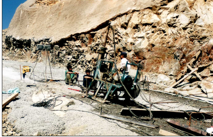
Şekil 5.2 Sondaj çalışmalarından bir görünüm (sağ sahil)
