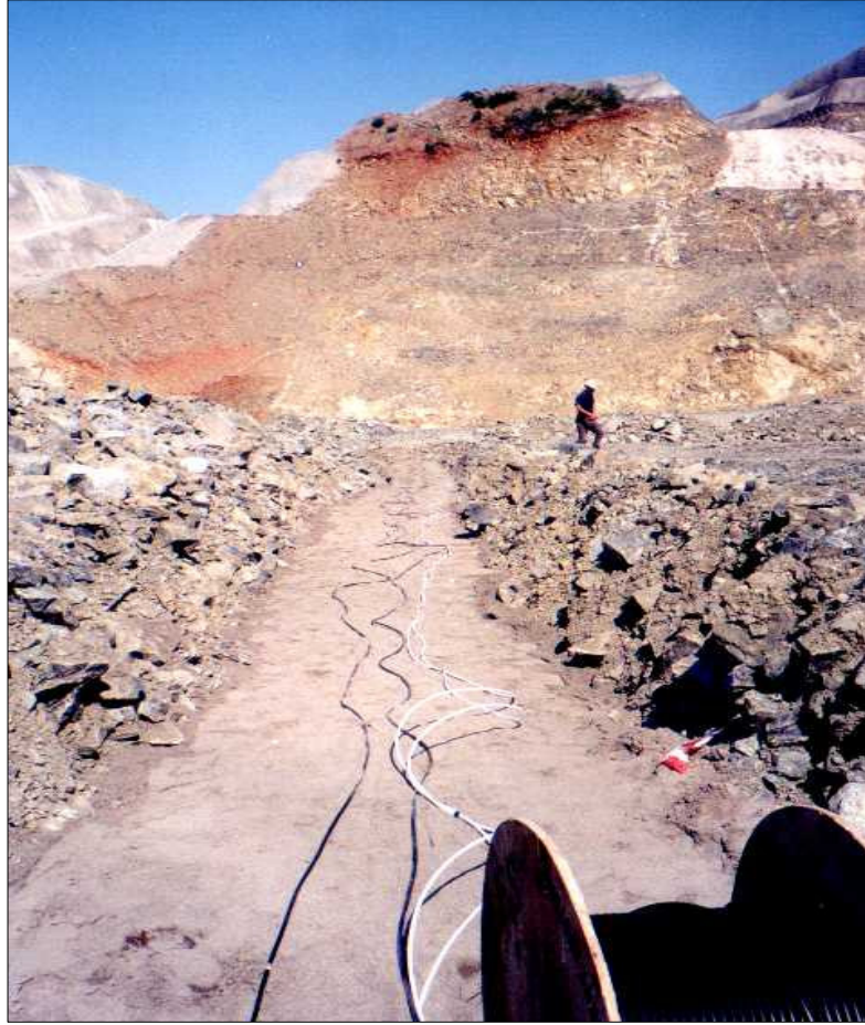
Şekil 7.7 + 20 kotunda ZDÖ hücrelerinin kaya dolgu içerisine yerleştirilmesi
