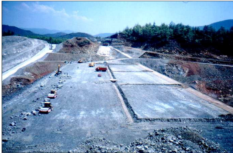
Şekil 7.8 + 40 kotunda ZDÖ hücrelerinin kaya dolgu içerisine yerleştirilmesi
