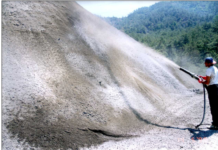
Şekil 7.12 Dolu savak shot-crete uygulaması
