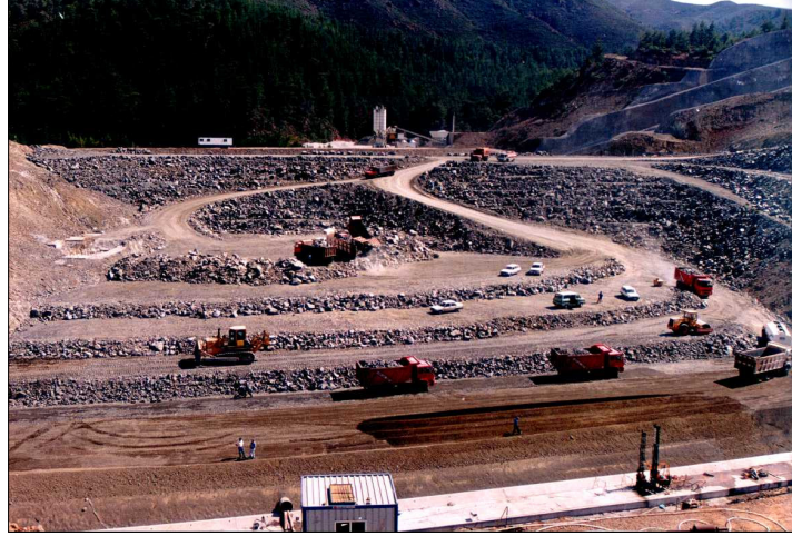
Şekil 7.3 Zonlu gövde dolgusu çalışmalarından bir görünüm.
