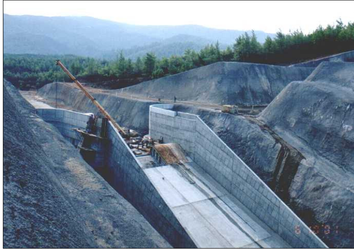
Şekil 7.13 Dolu savak betonlama çalışmaları
