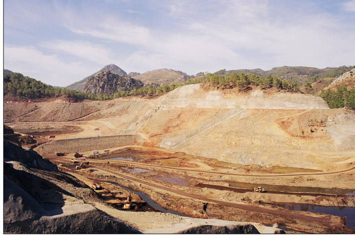
Şekil 7.1 Baraj sıyırma ve alüvyon kazısından görünüm
