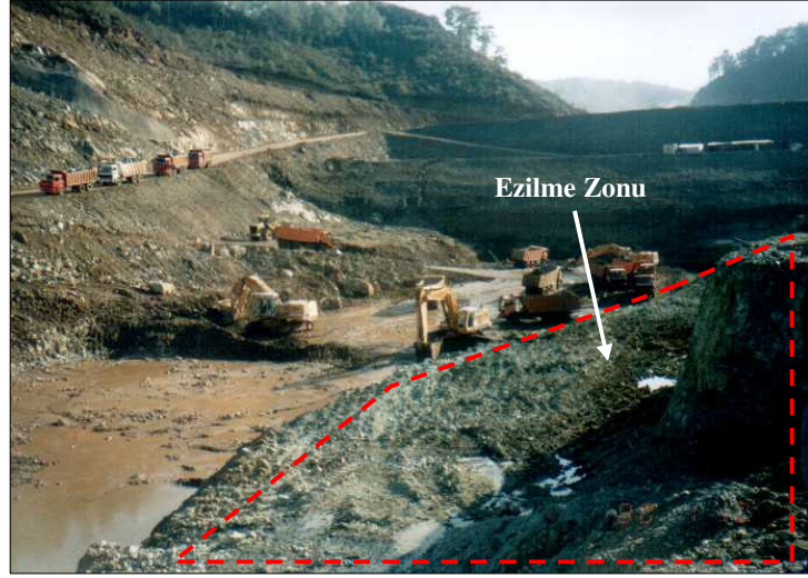
Şekil 2.3 Baraj gövdesinin oturacağı alanda görülen ezilme zonu
