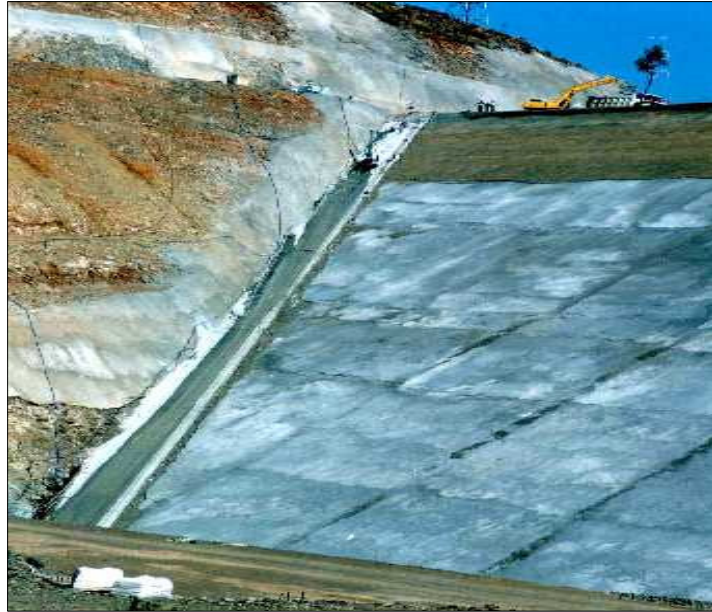
Şekil 7.2 Sol sahil plinth betonu dökümü
