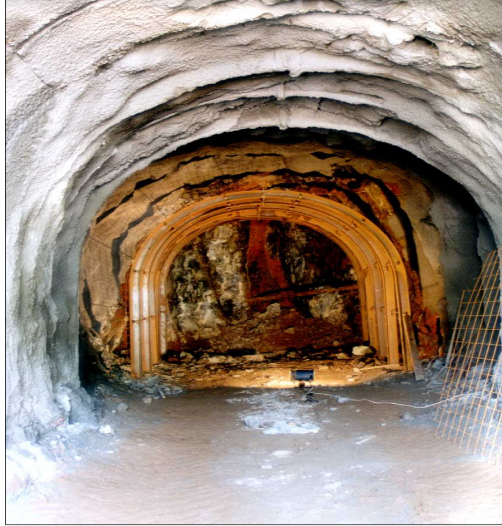
Şekil 5.14 Derivasyon tneli kazı-destek sistemlerinin grnm
