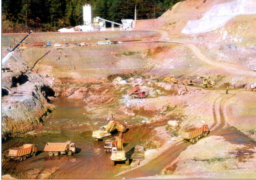
Şekil 5.11 Baraj sıyırma ve temel kazısından bir görünüm
