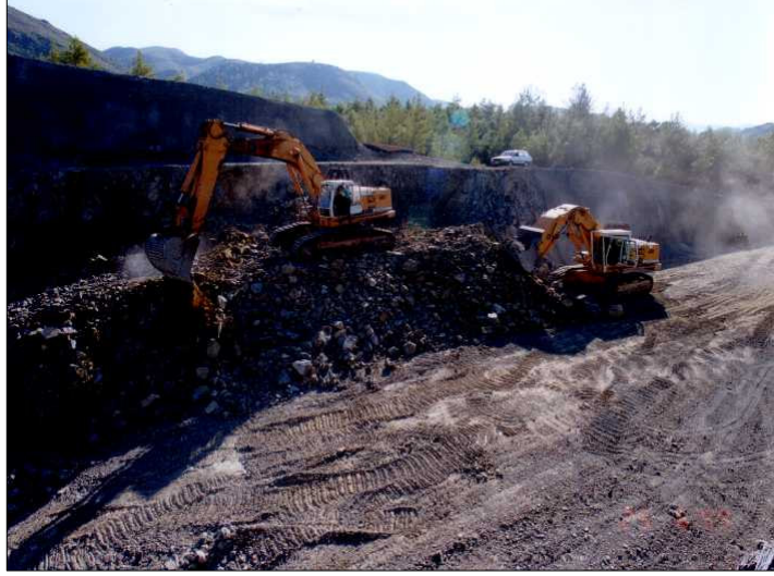
Şekil 7.11 Dolu savak kazısı
