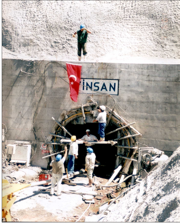
Şekil 7.14 Derivasyon tüneli beton kaplama çalışmaları
