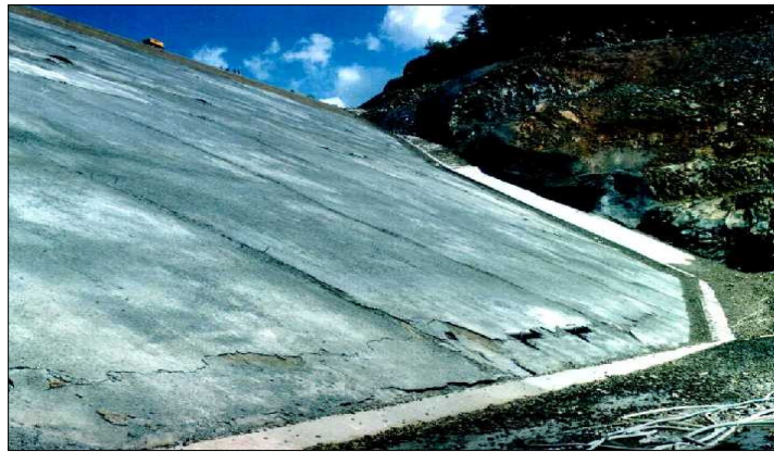
Şekil 7.4 Dolgu ön yüzeyine yapılan shot-crete uygulaması
