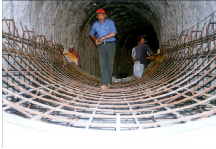
Şekil 5.13 Derivasyon tüneli enjeksiyon çalışmaları
