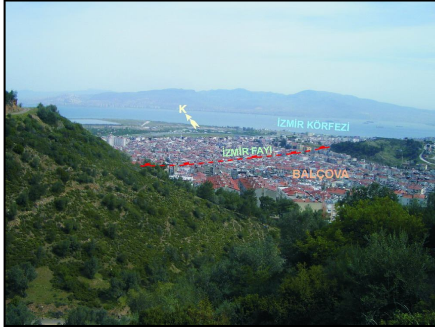
Şekil 5.1 Çalışma alanını içerisine alan Balçova İlçe’sinin, İzmir Fayı üzerinde yer alan yoğun yapılaşması (koordinat: 04475/48521)
