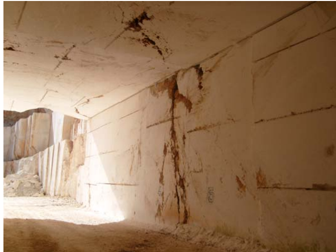
Şekil 4.11 Üç nolu galeride gözlenen kırık ve çatlaklar.
